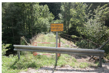
Pont des Portes ancien, vue de la chaussée et des garde-corps Phot. Pascale Renard IVR84_20207401024NUCA
