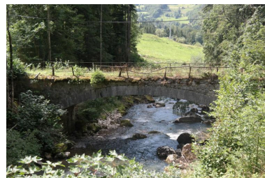
Pont des Portes ancien, vue de la face amont Phot. Pascale Renard IVR84_20207401023NUCA
