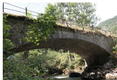
Pont des Portes ancien, vue de la face amont et garde-corps Phot. Pascale Renard IVR84_20207401026NUCA
