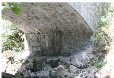
Pont des Portes ancien, vue du dessous Phot. Pascale Renard IVR84_20207401025NUCA
