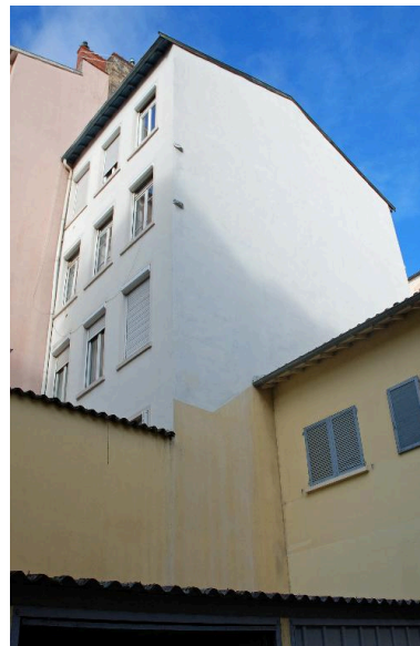
Vue des élévations latérale et postérieure Phot. Magali Delavenne IVR82_20146902960NUCA
