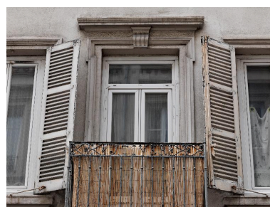
Garde-corps du balcon, inscription en ferronnerie Phot. Eric Dessert IVR84_20166901456NUCA
