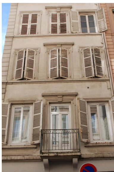
Vue rapprochée de l'élévation sur rue Phot. Magali Delavenne IVR82_20146902961NUCA
