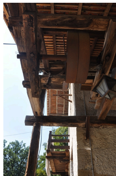
Détails des axes de transmission sur la façade sud Phot. Yannick Milleret IVR82_20107300294NUCA
