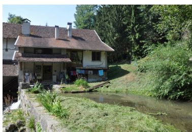
Détail de la réserve d'eau du moulin Phot. Yannick Milleret IVR82_20107300293NUCA
