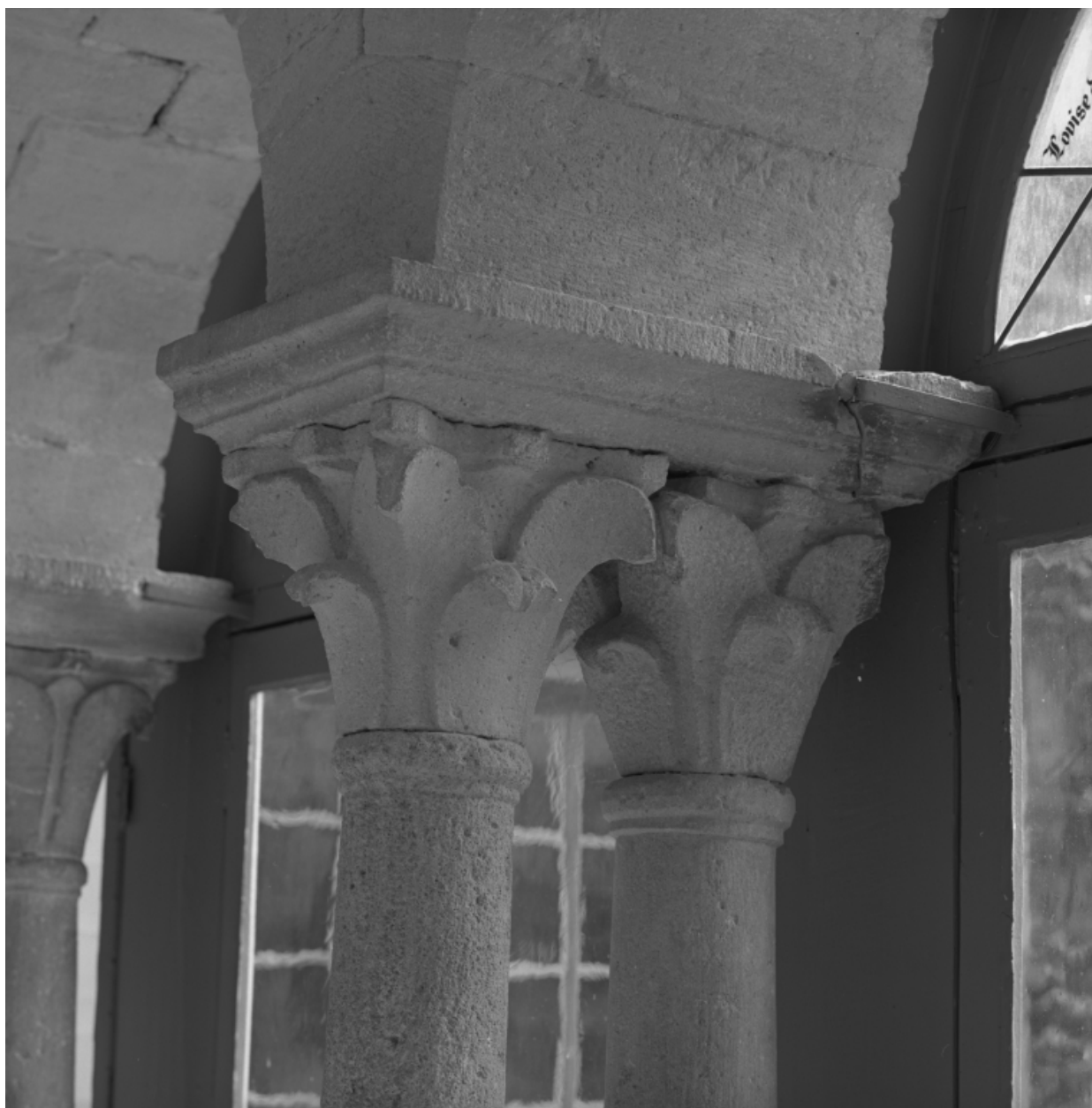
Colonnes 3 et 4, détail (vue prise de l'ouest).
