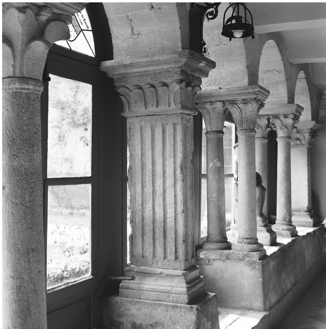
Vue partielle des vestiges, galerie nord-est.
