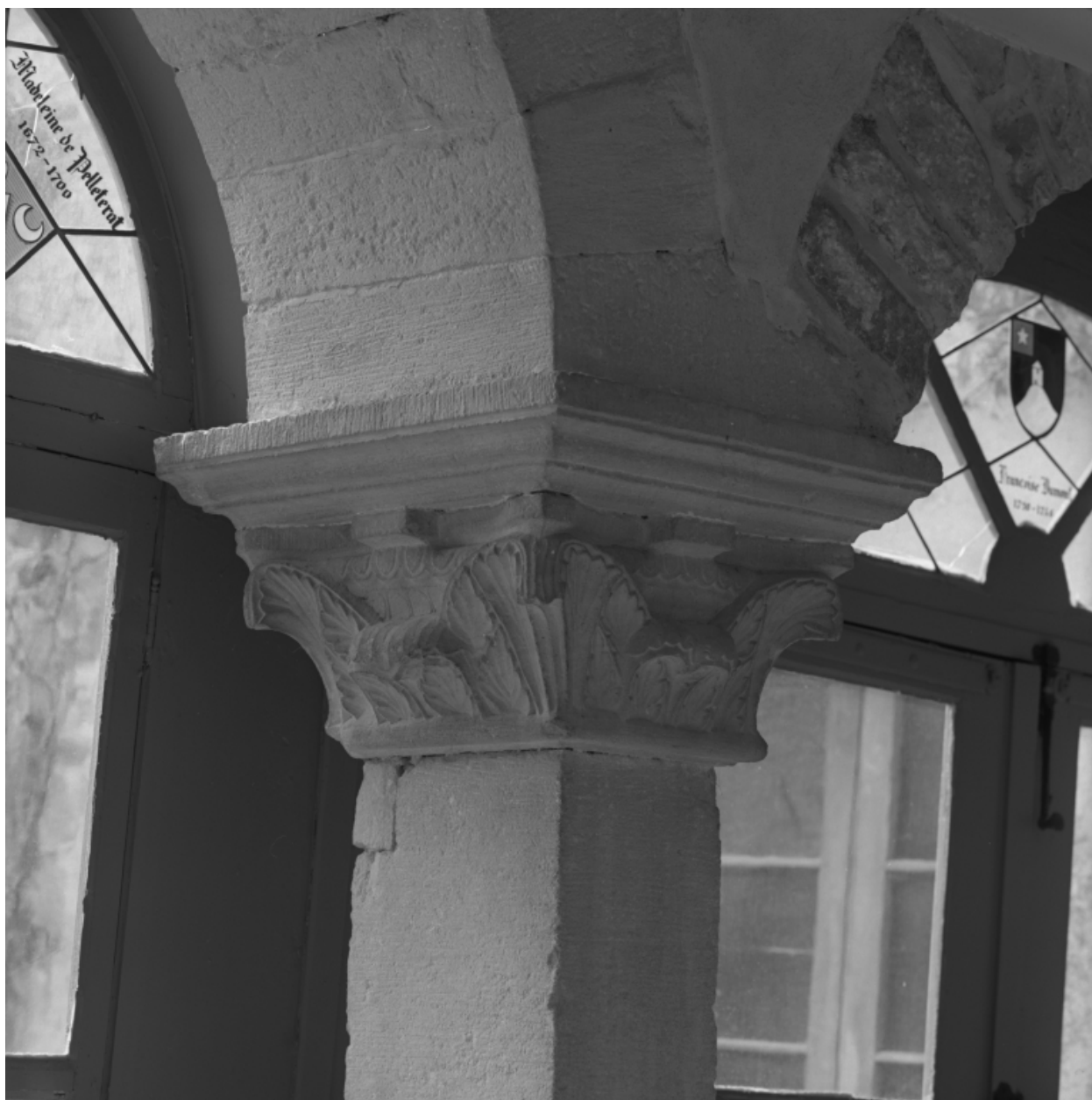
Chapiteau du pilier 3.
