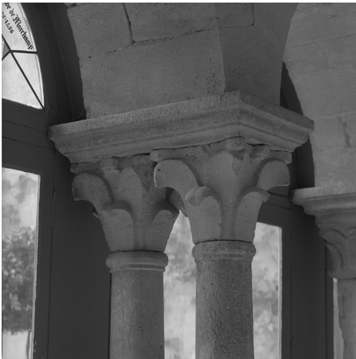
Colonnes 3 et 4, détail (vue prise du nord).
