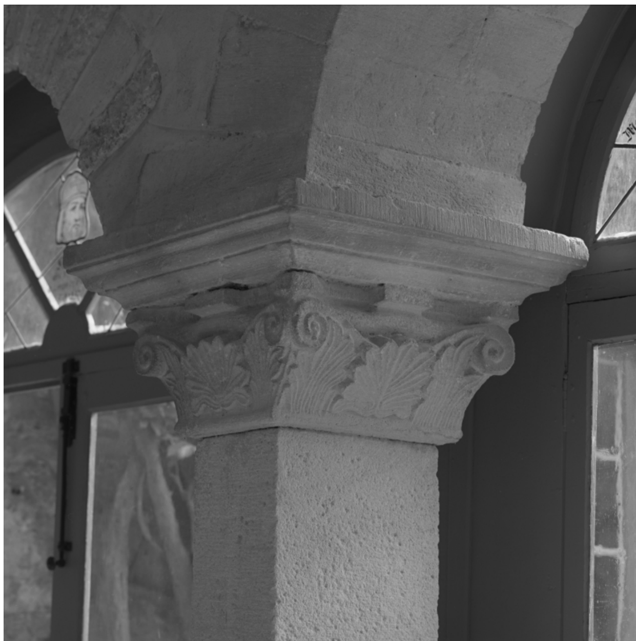
Chapiteau du pilier 1.
