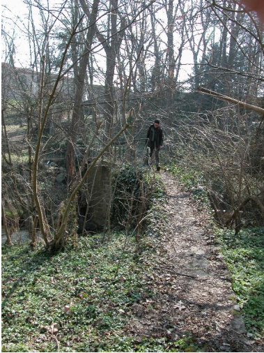
Vue d'ensemble du tablier de la passerelle. Phot. Thierry Monnet IVR82_20144200369NUCA
