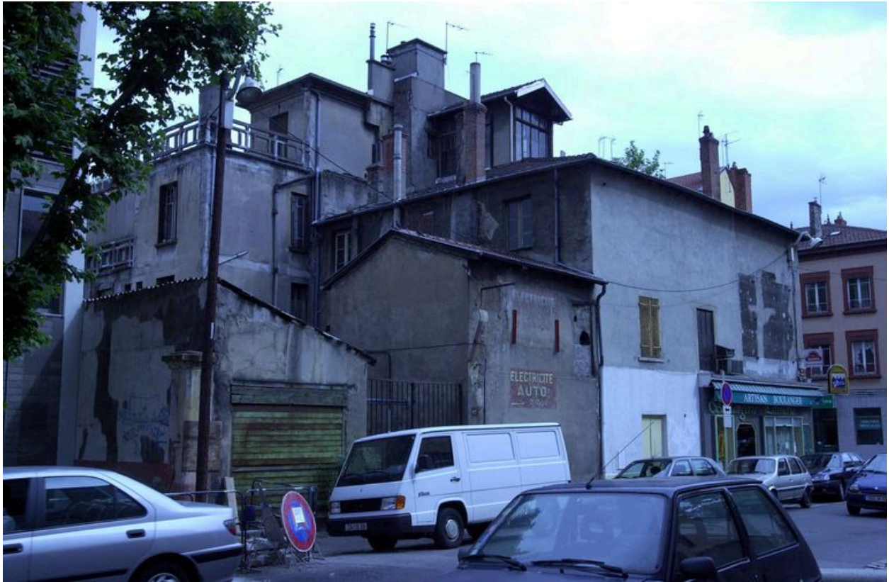
Façades sur cour prises depuis la rue Feuillat
