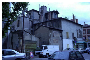
Façades sur cour prises depuis la rue Feuillat Phot. Bernard Ducouret
