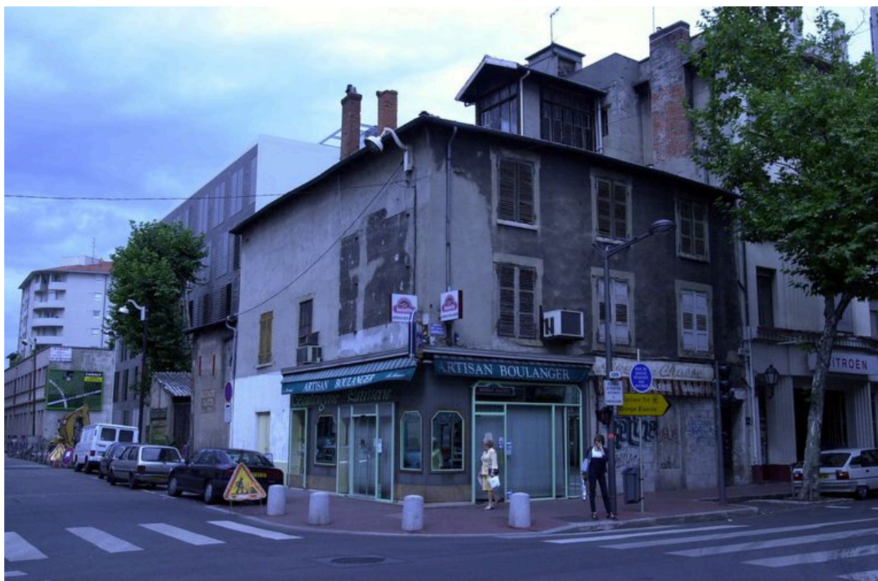
Vue générale des façades sur rue
