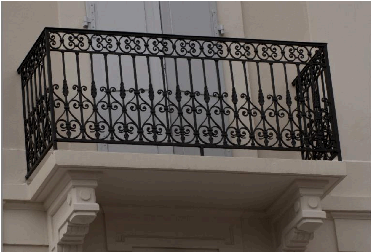
Détail sur un des deux balcons en pierre de la façade, avec consoles en pierre et garde-corps en fer ou fonte
