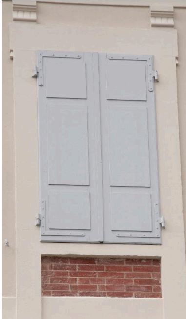
Détail sur une baie de la façade, avec contre-cœurs en briques Phot. Denys Harreau IVR82_20157300964NUCA
