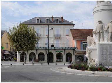
Vue générale depuis l'est Phot. Denys Harreau IVR82_20157300960NUCA
