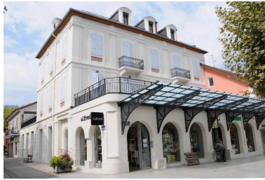
Vue de trois-quart depuis le sud-est Phot. Denys Harreau IVR82_20157300963NUCA
