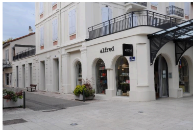
Les baies du rez-de- chaussée commercial sur la rue du Commerce, au sud Phot. Denys Harreau IVR82_20157300968NUCA
