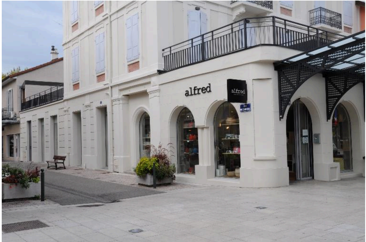
Les baies du rez-de-chaussée commercial sur la rue du Commerce, au sud
