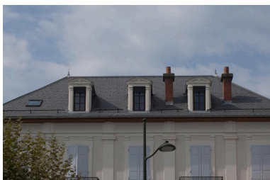
Lucarnes "en pierres factices" amortissant les trois travées centrales de la façade Phot. Denys Harreau IVR82_20157300961NUCA
