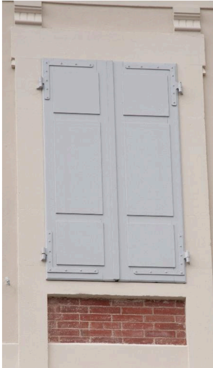
Détail sur une baie de la façade, avec contre-cœurs en briques
