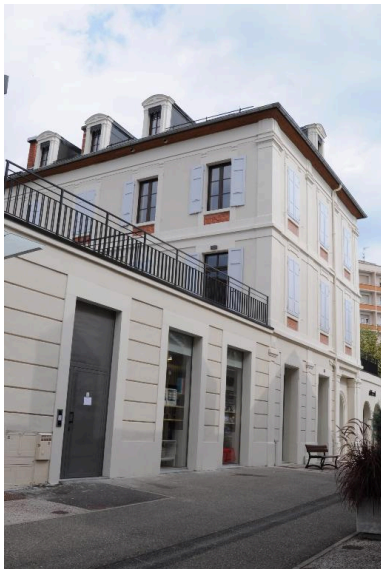
Élévation postérieure, vue de trois-quart depuis le sud-ouest Phot. Denys Harreau IVR82_20157300966NUCA
