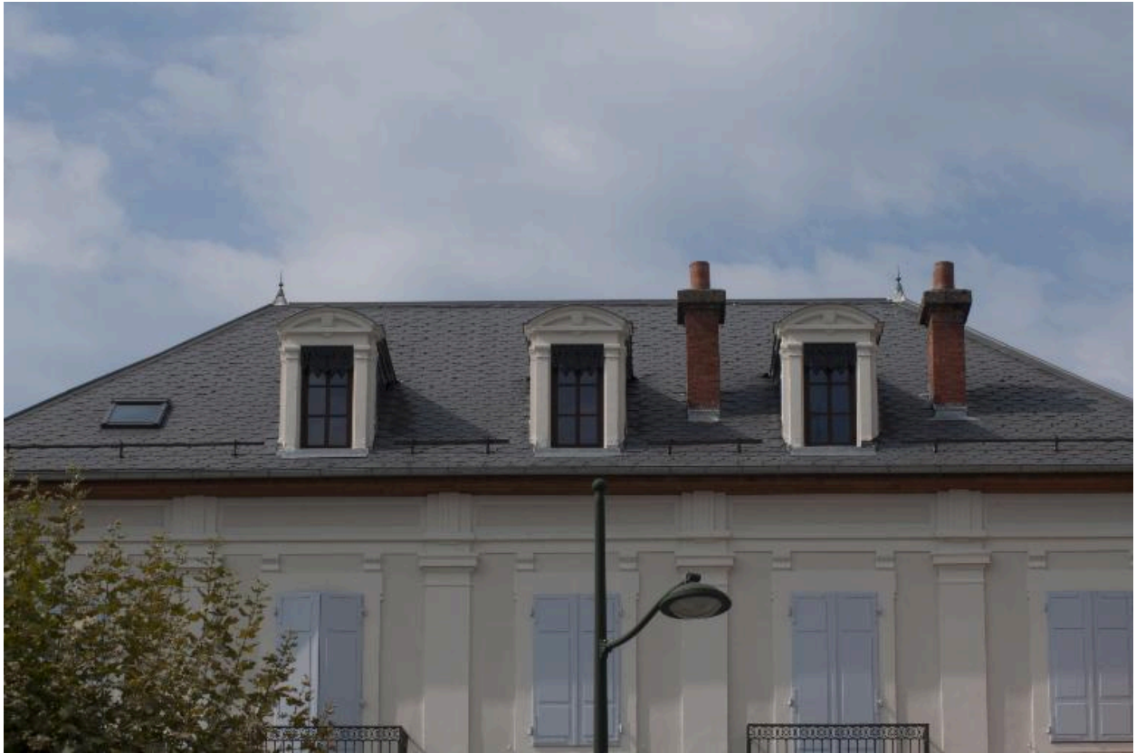
Lucarnes "en pierres factices" amortissant les trois travées centrales de la façade
