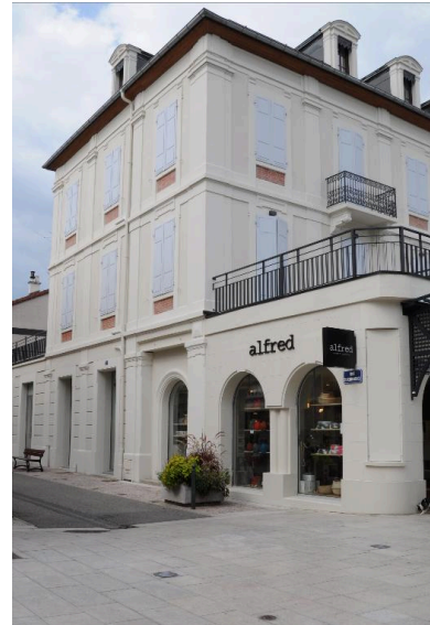
Élévation latérale, vue de trois-quart depuis le sud-est Phot. Denys Harreau IVR82_20157300969NUCA
