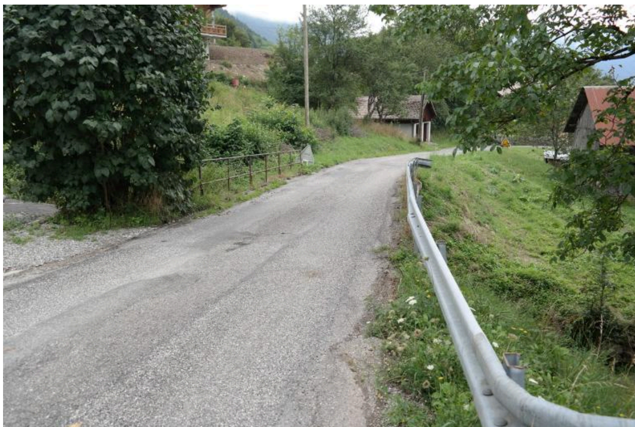
Ponceau de Taverole, vue de la chaussée et des garde-corps
