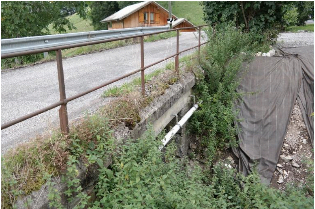
Ponceau de Taverole, vue de la face amont
