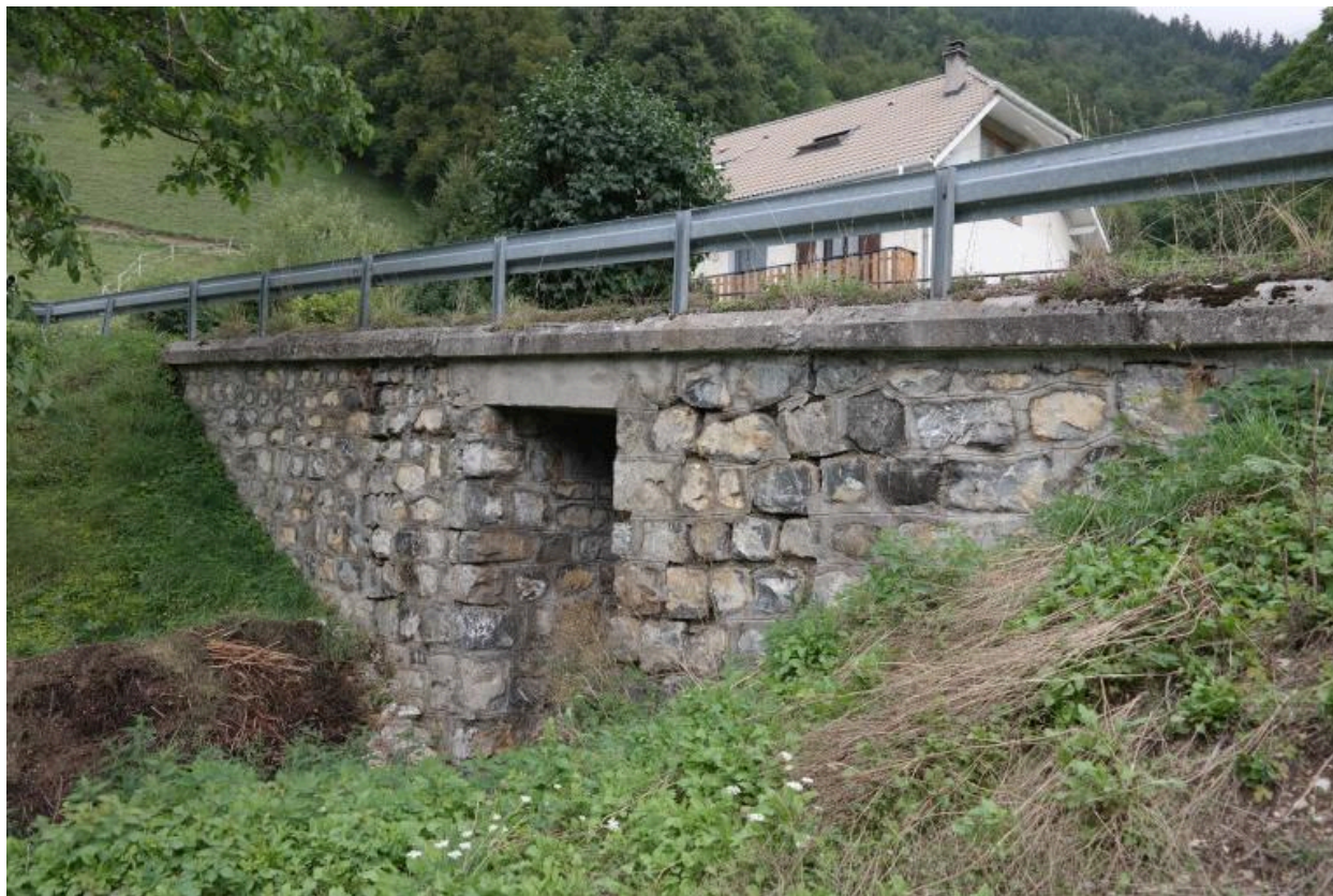
Ponceau de Taverole, vue de la face aval
