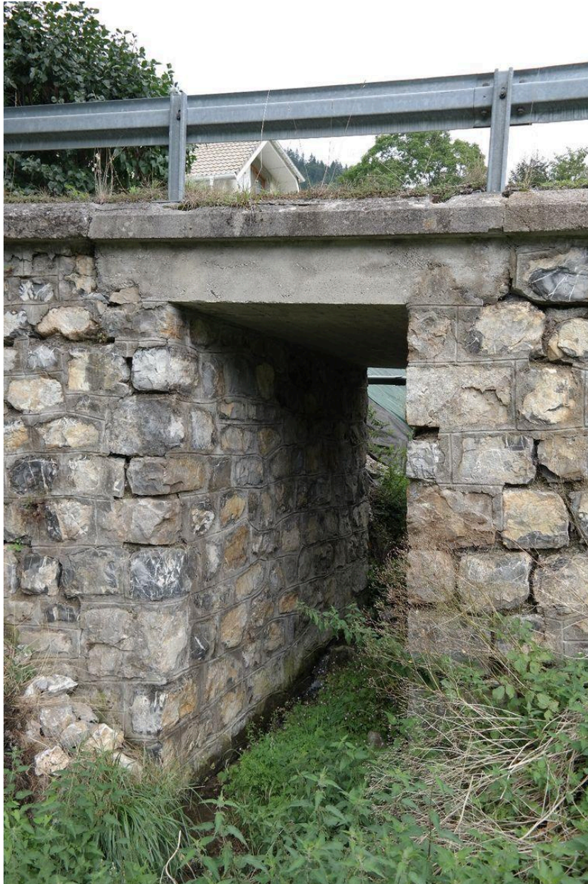
Ponceau de Taverole, détail du dessous
