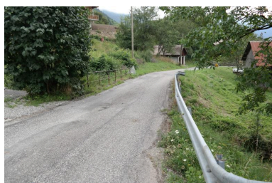
Ponceau de Taverole, vue de la chaussée et des garde-corps Phot. Pascale Renard IVR84_20207401232NUCA
