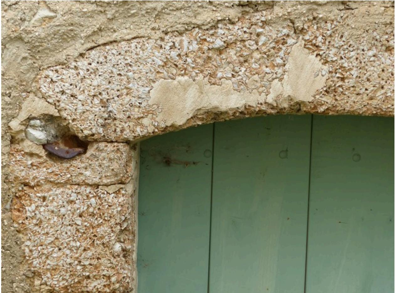
Elévation sud, premier niveau. Porte, détail de l'encadrement en pierre de taille de brèche calcaire.
