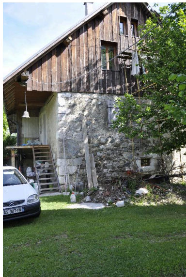
Vue de l'habitation. Phot. Caroline Guibaud IVR84_20167302346NUCA
