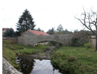
Vue générale Phot. Thierry Monnet IVR82_20134203374NUCA
