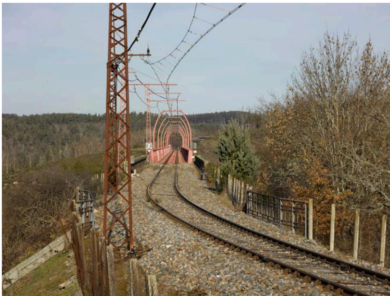
La voie ferrée à son passage sur le viaduc de Garabit ; l'électrification de la ligne est ici bien visible.
