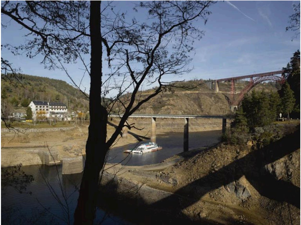
Ponts routier et ferroviaire de Garabit sur la Truyère.
