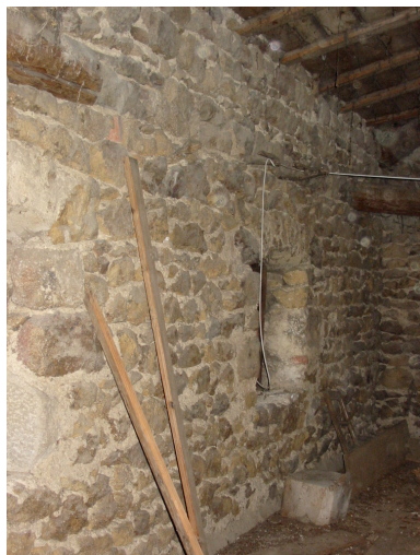
Logis nouveau, comble à surcroît. Vue partielle du mur pigeon est. Phot. Thierry Monnet IVR82_20114201747NUCA
