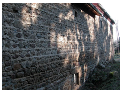
Elévation sud du logis nouveau et de la grange-étable arrière. Phot. Thierry Monnet IVR82_20124200049NUCA
