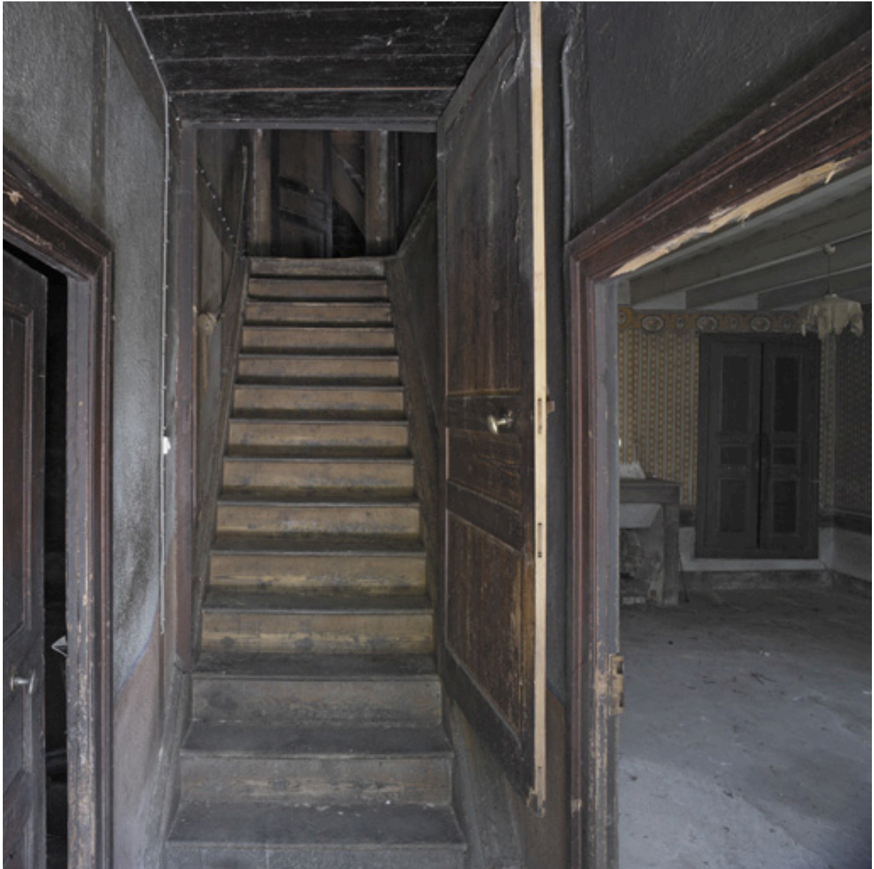
Logis nouveau. Vue d'ensemble de la montée d'escalier du logis.
