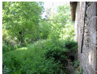
Grange-étable. Vue d'ensemble latérale sud du montoir arrière. Phot. Thierry Monnet IVR82_20114201734NUCA
