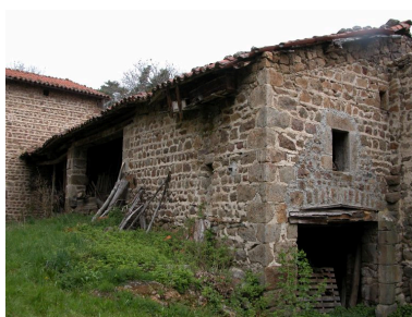
Remises, cuvage de la ferme, vue d'ensemble de trois-quarts. Phot. Thierry Monnet IVR82_20114201706NUCA
