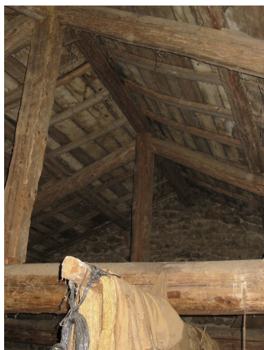
Logis nouveau, comble à surcroît. Détail de la charpente des longs pans.
