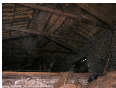
Grange-étable. Vue partielle de la charpente. Phot. Thierry Monnet IVR82_20124200058NUCA
