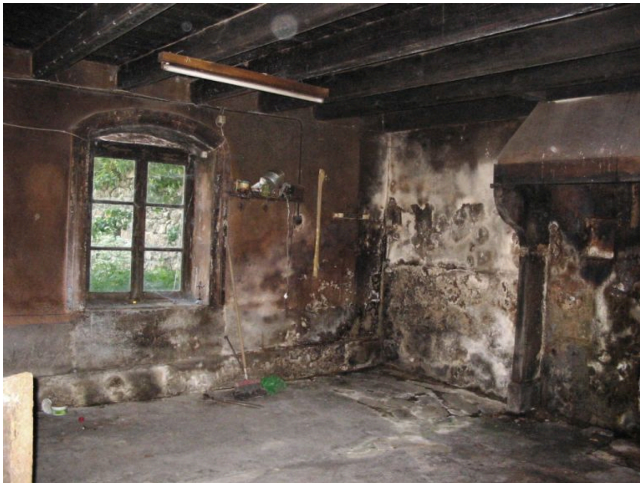
Logis nouveau, cuisine. Vue d'ensemble de la cheminée avec la fenêtre sur cour.
