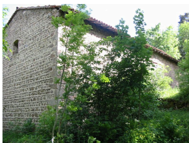
Grange-étable. Vue d'ensemble de trois-quarts du mur pignon nord de la grange-étable. Phot. Thierry Monnet IVR82_20114201733NUCA
