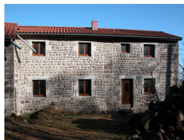
Janvier 2012. Etat après travaux des anciens logis situés dans l'angle nord-est de la cour. Phot. Thierry Monnet IVR82_20124200046NUCA
