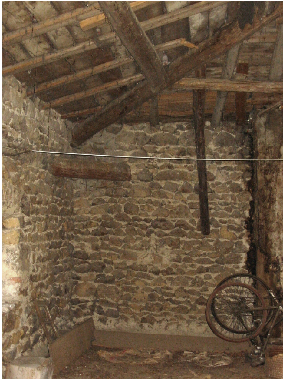
Logis nouveau, comble à surcroît. Détail de la charpente de la croupe.
