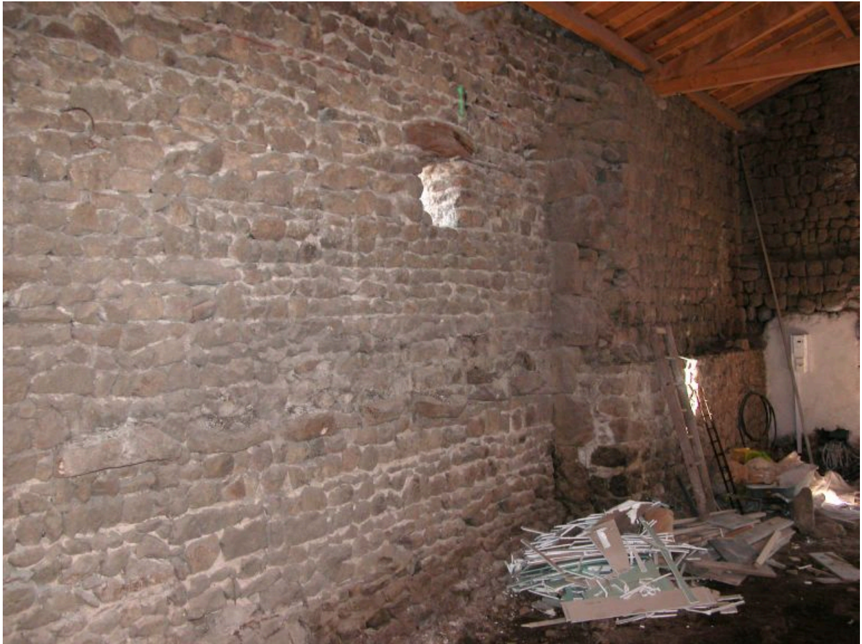
Janvier 2012. Remise, cuvage, étable, vue partielle mur nord.
