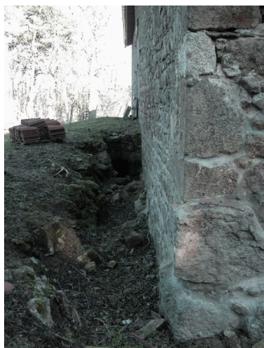
Grange-étable. Vue d'ensemble latérale sud du montoir arrière. Phot. Thierry Monnet IVR82_20124200056NUCA
