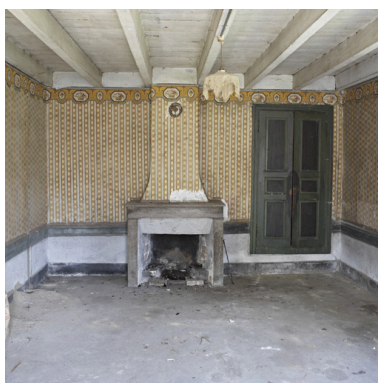
Logis nouveau, salle à manger. Vue d'ensemble avec la cheminée contre le mur ouest. Phot. Eric Dessert IVR82_20054200769NUCA
