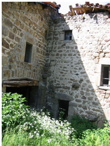
Logis ancien. Détail de l'angle du logis avec l'ancienne grange-étable. Phot. Thierry Monnet IVR82_20114201737NUCA
