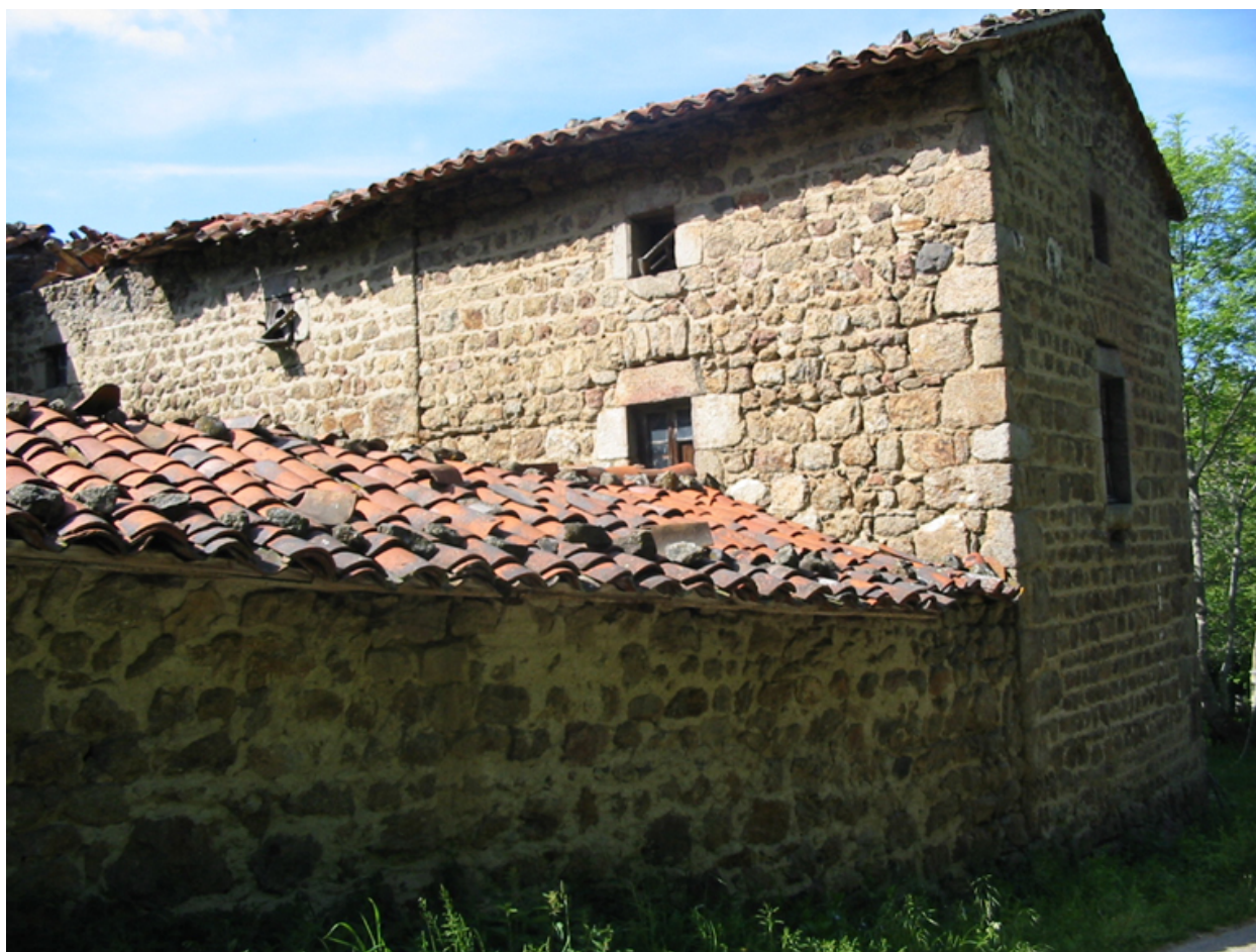
Logis ancien. Vue d'ensemble de trois-quarts du pignon est depuis l'extérieur de la cour.
