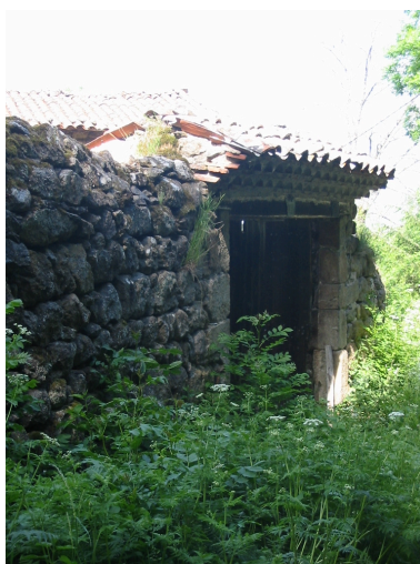
Portail de la cour. Vue d'ensemble de trois-quarts depuis l'extérieur. Phot. Thierry Monnet IVR82_20114201743NUCA
