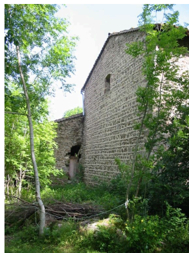
Grange-étable. Vue d'ensemble des murs pignons nord de la grange-étable, et ouest de la remise. Phot. Thierry Monnet IVR82_20114201735NUCA
