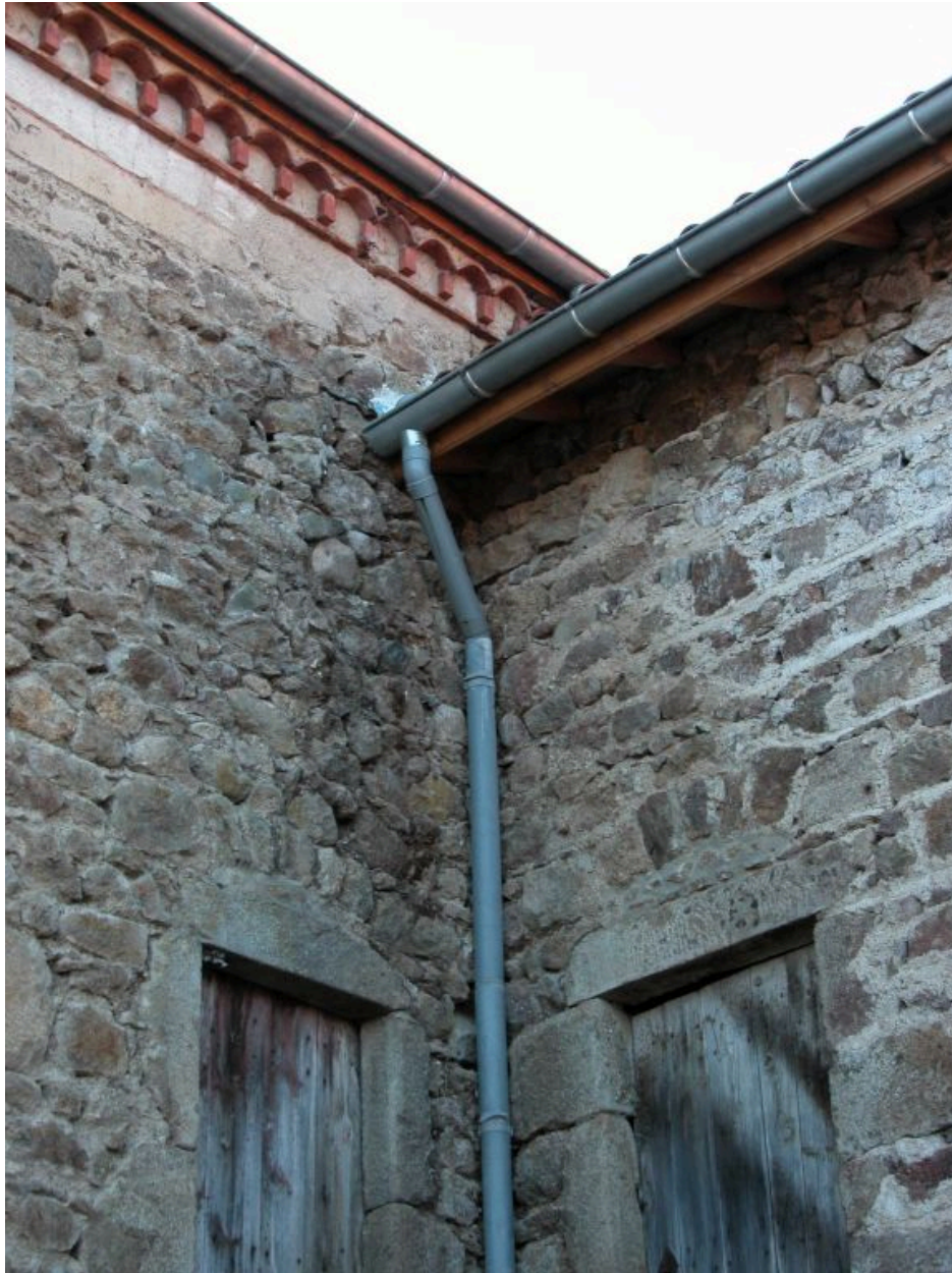
Angle intérieur du logis et de la grange-étable, partie supérieure
