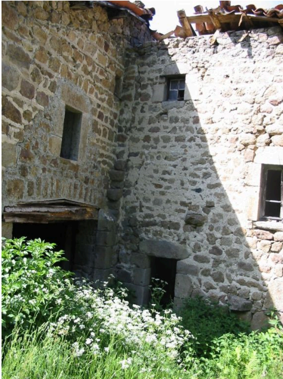
Logis ancien. Dérail de l'angle du logis avec l'ancienne grange-étable.
