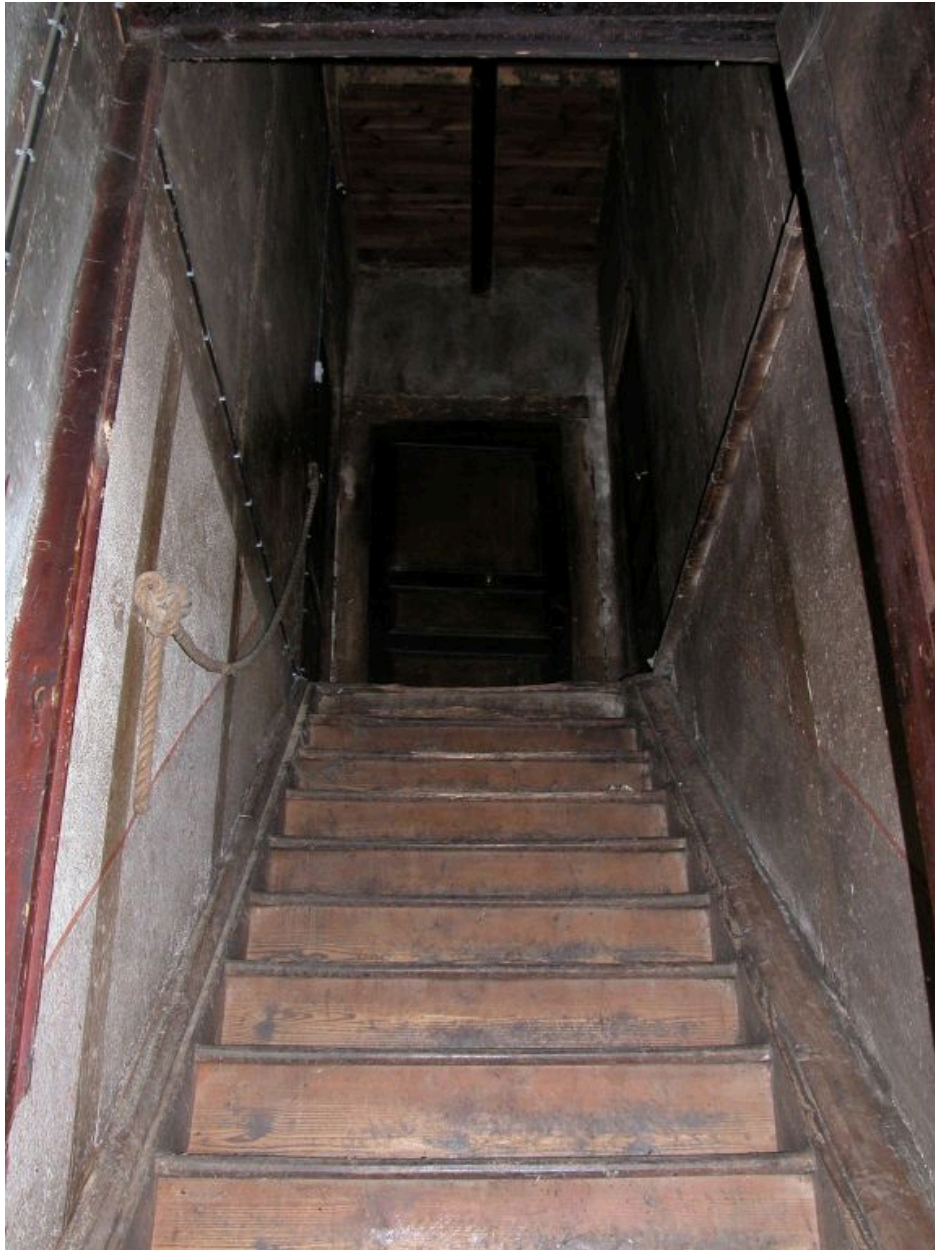
Logis nouveau. Vue partielle de la montée de l'escalier.
