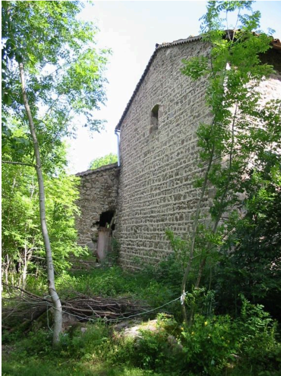
Grange-étable. Vue d'ensemble des murs pignons nord de la grange-étable, et ouest de la remise.
