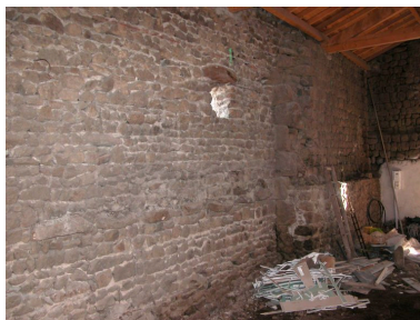
Janvier 2012. Remise, cuvage, étable, vue partielle mur nord. Phot. Thierry Monnet IVR82_20124200042NUCA
