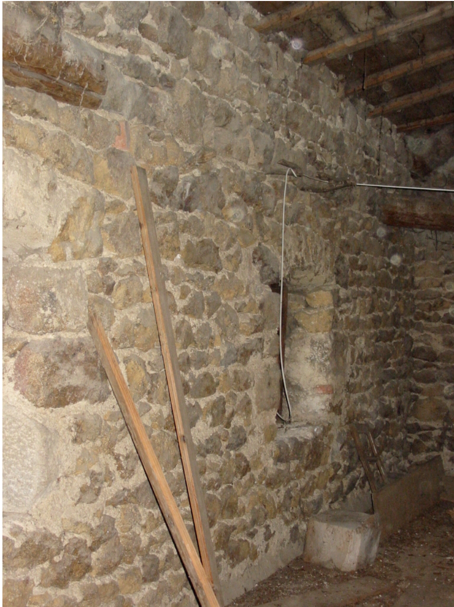
Logis nouveau, comble à surcroît. Vue partielle du mur pigeon est.
