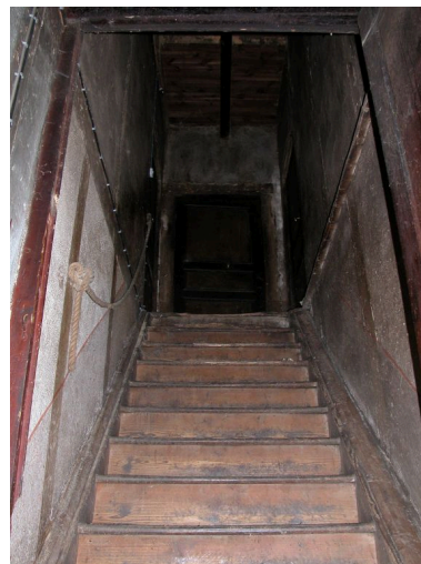
Logis nouveau. Vue partielle de la montée de l'escalier. Phot. Thierry Monnet IVR82_20114201714NUCA
