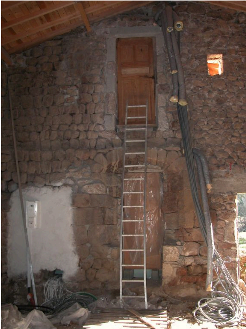
Janvier 2012. Remise, cuvage, étable, détail baie remaniée du mur est.
