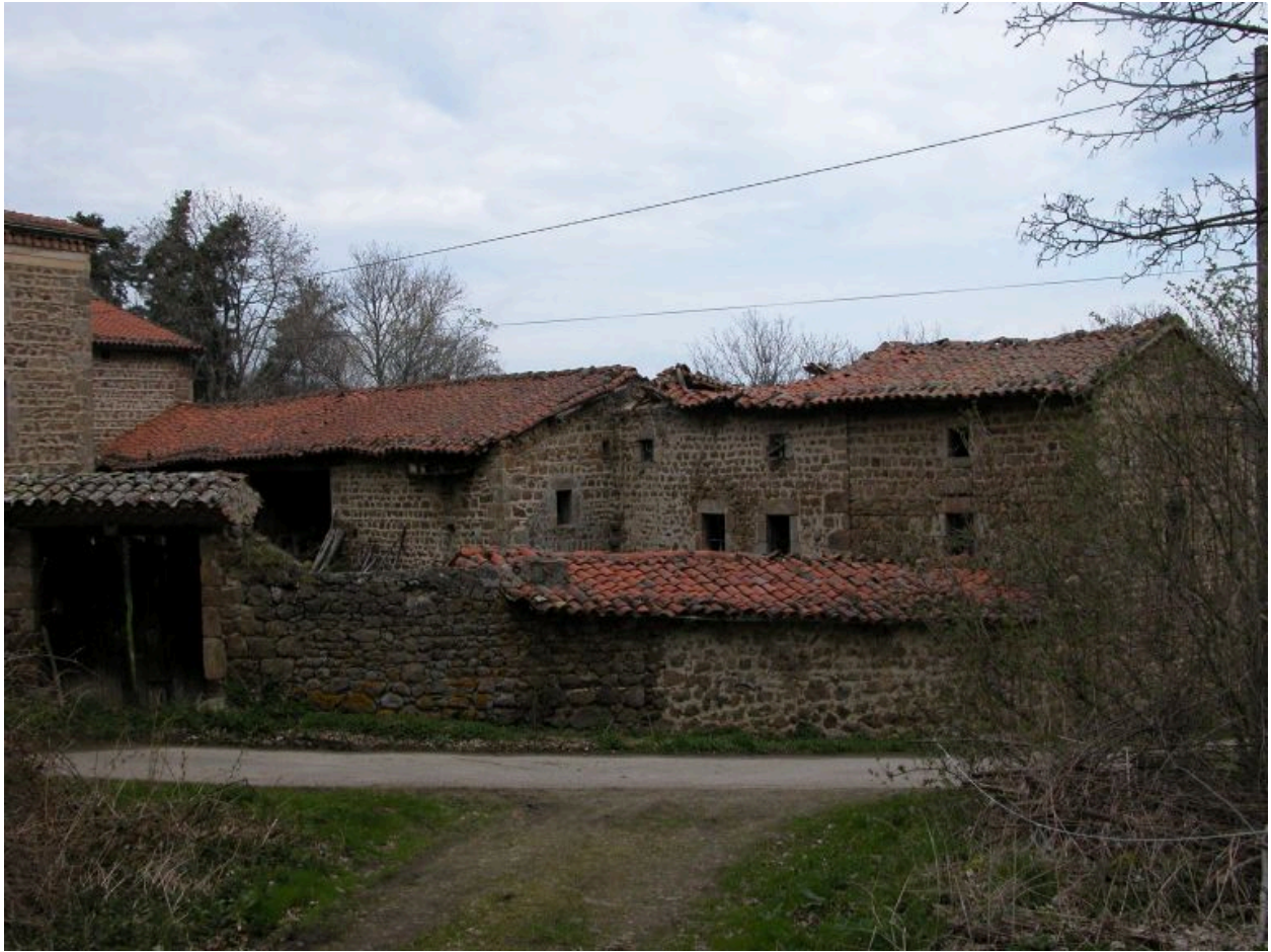
Vue d'ensemble de la remise et de l'ancien logis de la ferme depuis l'extérieur de la cour.
