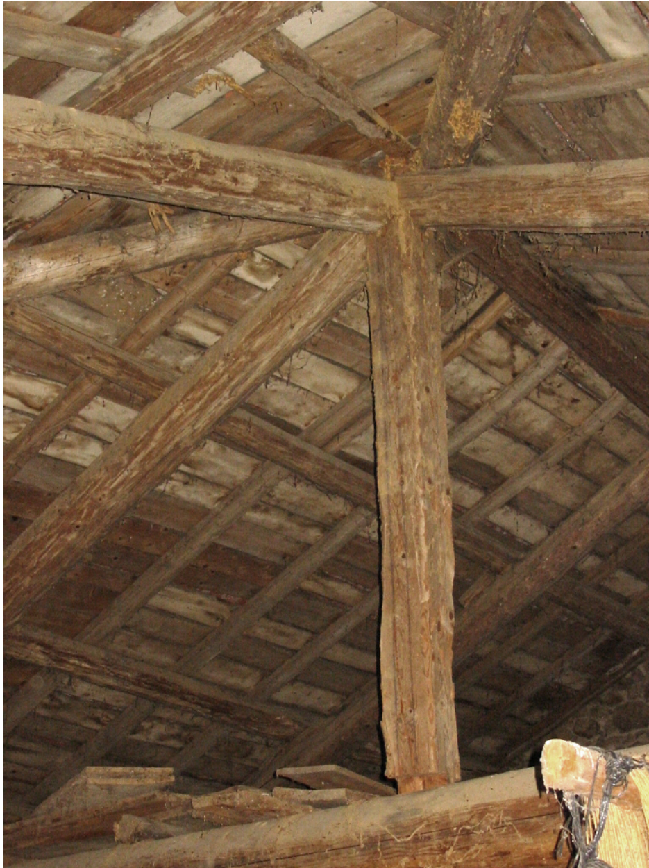
Logis nouveau, comble à surcroît. Détail de la charpente de la croupe, axe centrale.
