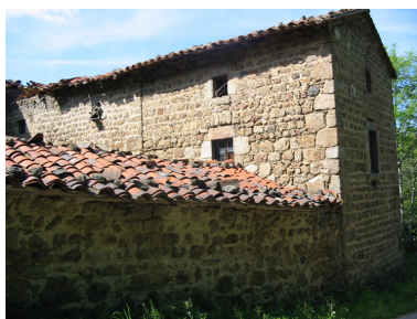
Logis ancien. Vue d'ensemble de trois-quarts du pignon est depuis l'extérieur de la cour. Phot. Thierry Monnet IVR82_20114201746NUCA
