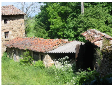
Porcherie. Vue d'ensemble depuis la cour. Phot. Thierry Monnet IVR82_20114201742NUCA
