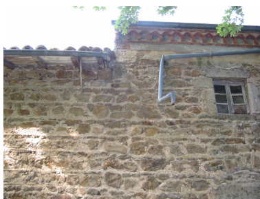
Liaison logis nouveau et grange- étable, détail de la corniche. Phot. Thierry Monnet IVR82_20114201724NUCA
