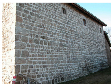
Logis ancien. Vue d'ensemble extérieure nord. Phot. Thierry Monnet IVR82_20124200050NUCA
