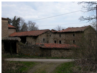
Vue d'ensemble de la remise et de l'ancien logis de la ferme depuis l'extérieur de la cour. Phot. Thierry Monnet IVR82_20114201696NUCA
