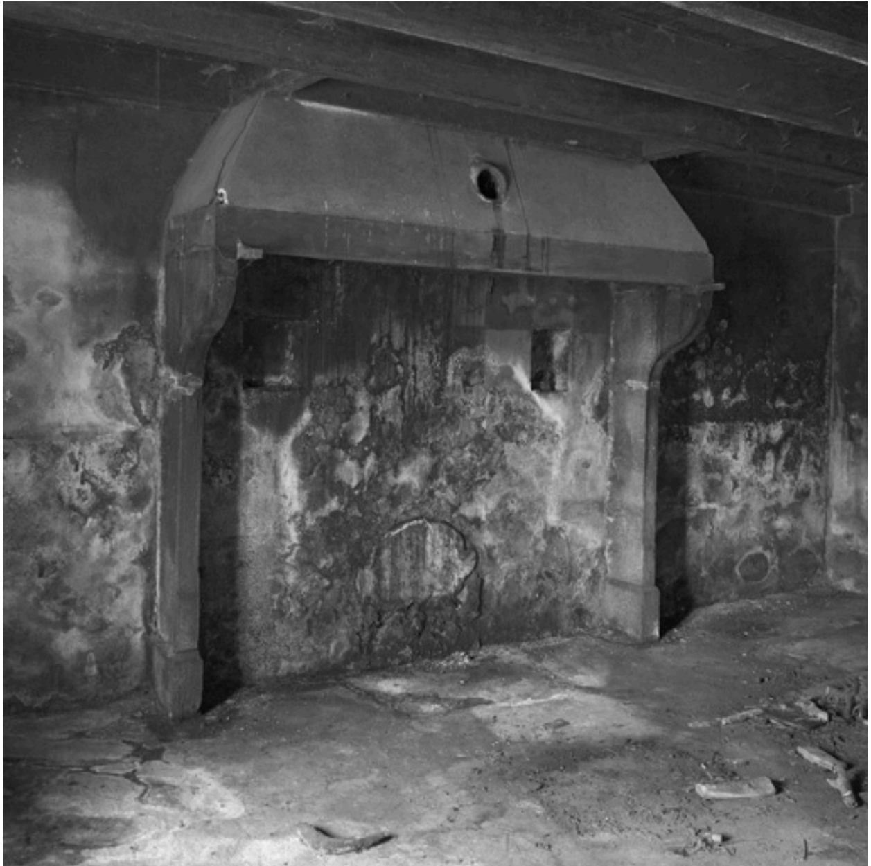
Logis nouveau, cuisine. Vue d'ensemble de la cheminée.
