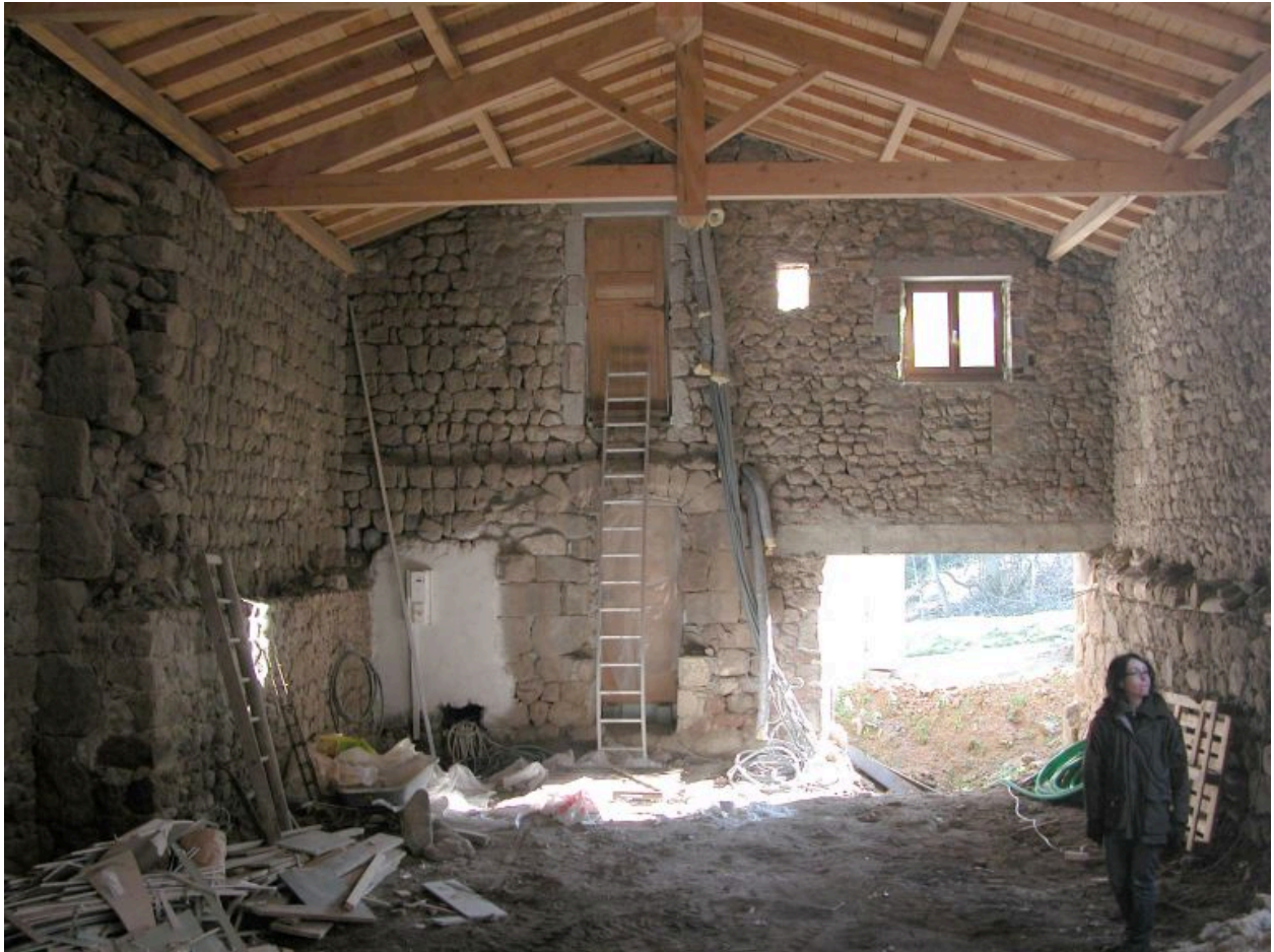
Janvier 2012. Vue d'ensemble intérieure de la remise, cuvage, étable.
