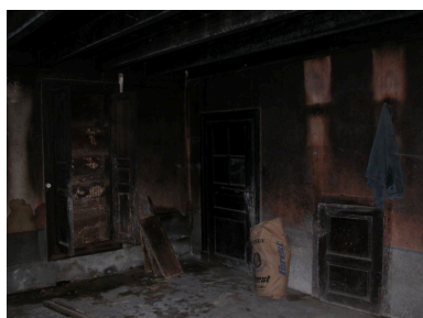
Logis nouveau, cuisine. Vue partielle des murs ouest et nord. Phot. Thierry Monnet IVR82_20114201699NUCA
