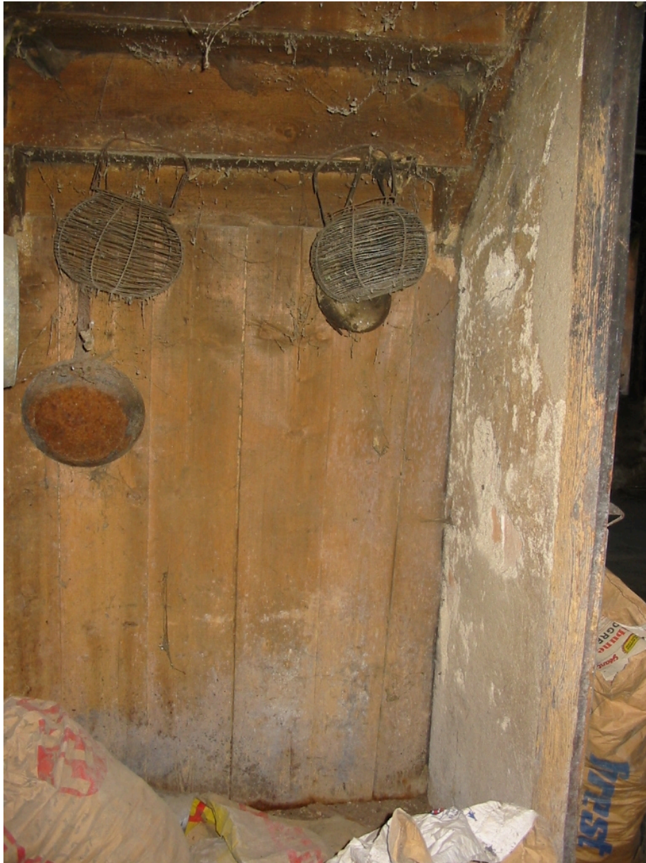
Logis nouveau, cuisine. Vue partielle du dégagement sous l'escalier.
