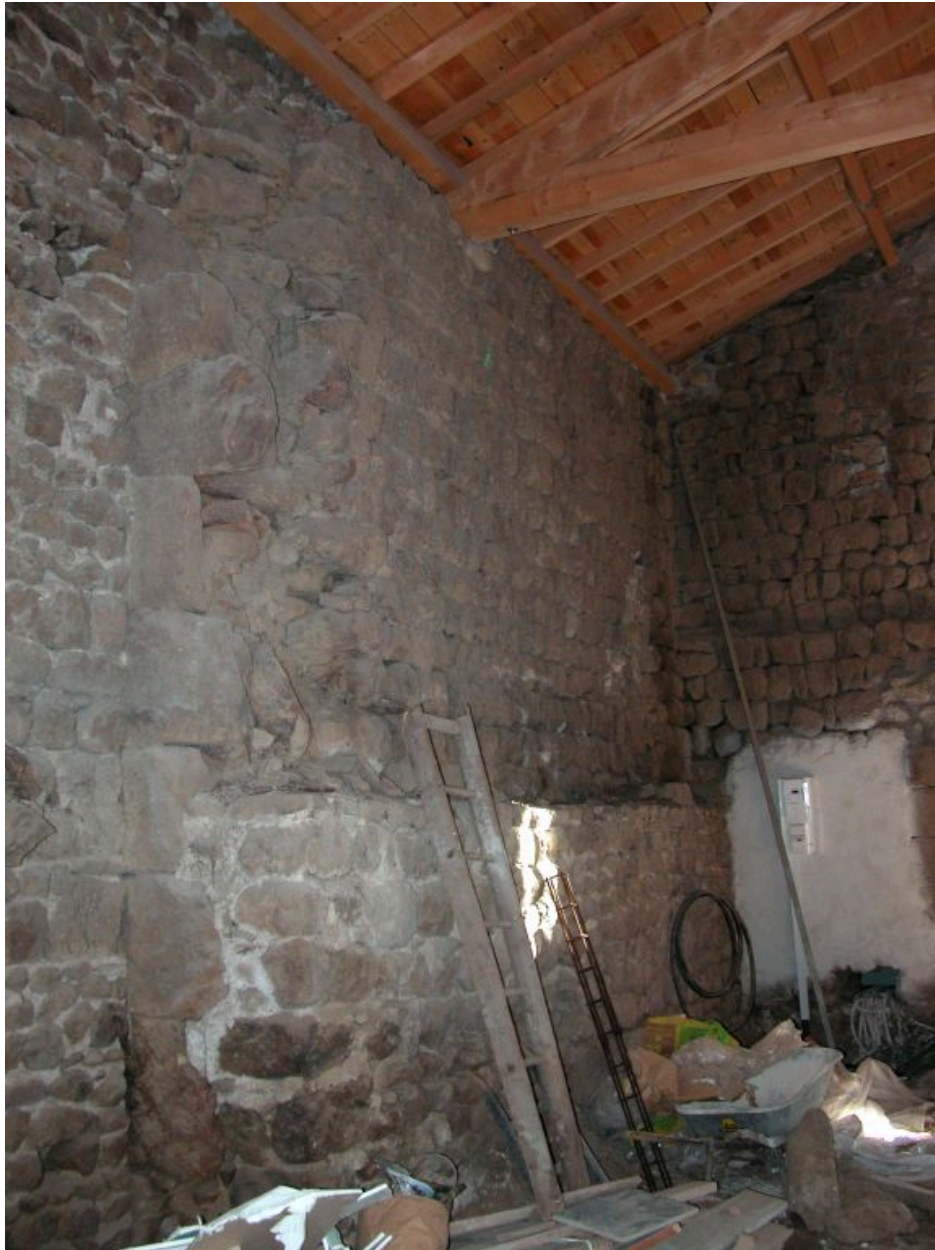
Janvier 2012. Remise, cuvage, étable, détail intérieur mur nord.
