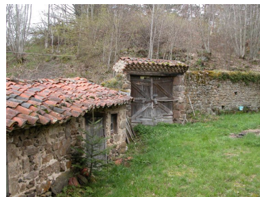
Portail de la cour. Vue partielle intérieure de l'enclos du mur avec le portail. Phot. Thierry Monnet IVR82_20114201713NUCA
