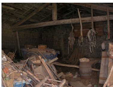
Remise de la ferme, vue d'ensemble intérieure. Phot. Thierry Monnet IVR82_20114201709NUCA
