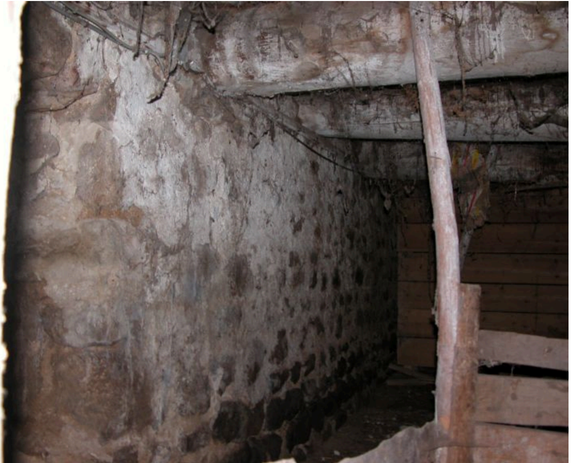
Grange-étable. Vue partielle intérieure, mur est.
