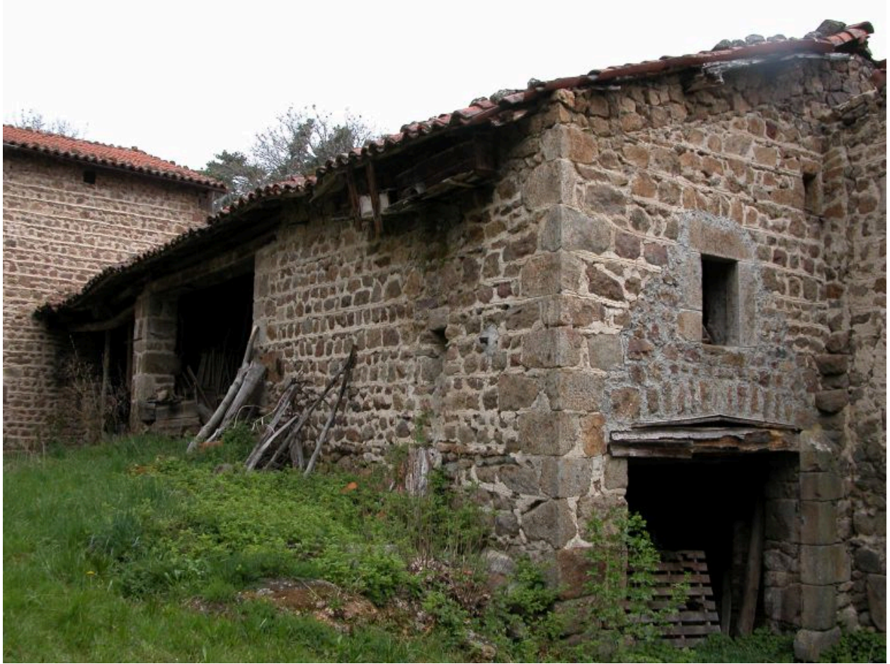
Remises, cuvage de la ferme, vue d'ensemble de trois-quarts.
