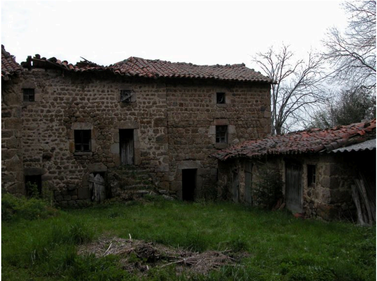
Logis ancien. Vue d'ensemble de face.
