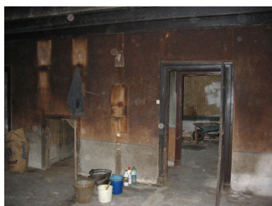
Logis nouveau, cuisine. Enfilade des portes depuis la cuisine jusqu'à la salle à manger. Phot. Thierry Monnet IVR82_20114201728NUCA
