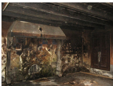
Logis nouveau, cuisine. Vue d'ensemble de la cheminée de face. Phot. Thierry Monnet IVR82_20114201725NUCA
