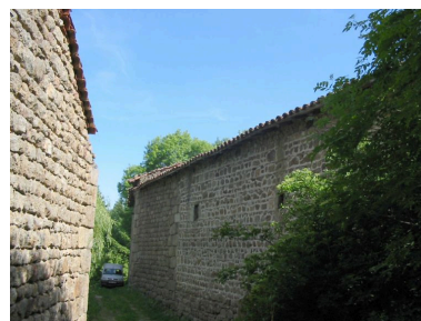
Logis ancien. Vue d'ensemble arrière depuis la rue. Phot. Thierry Monnet IVR82_20114201740NUCA
