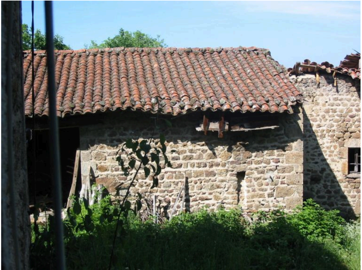
Remise - cuve. Vue partielle gauche, de face, depuis la cour.
