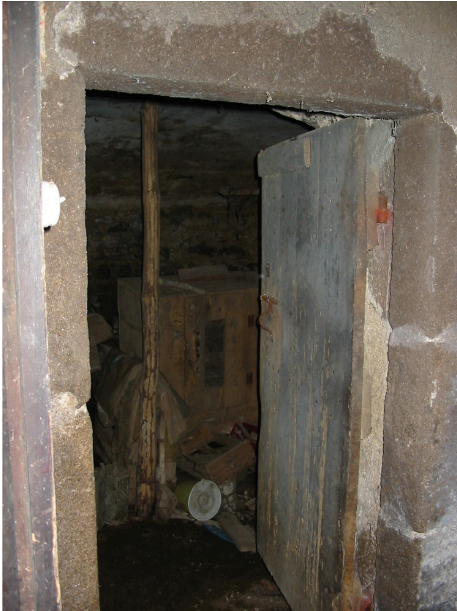
Logis nouveau, cave. Vue d'ensemble extérieure de la porte intérieure.
