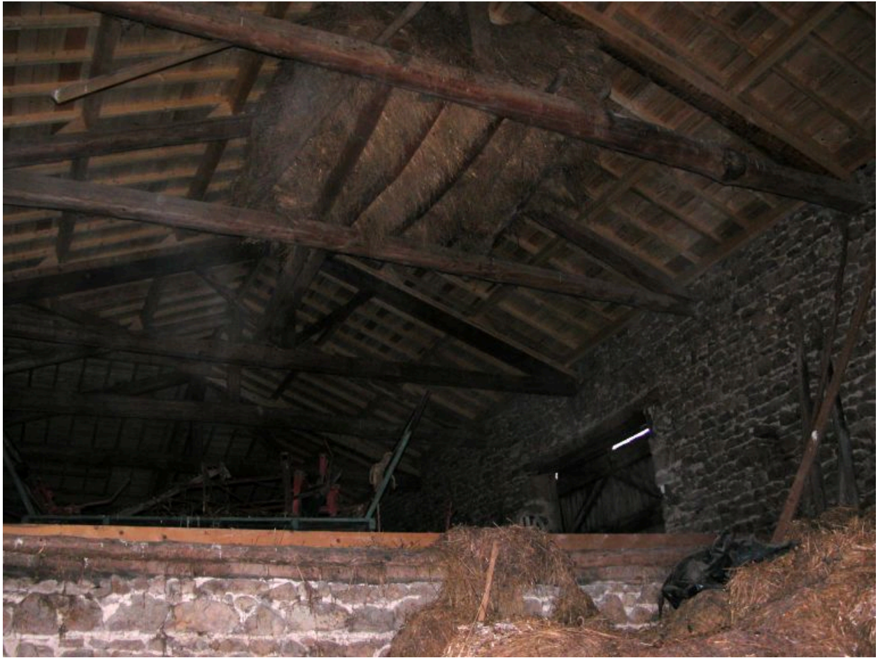
Grange-étable. Vue partielle de la charpente.
