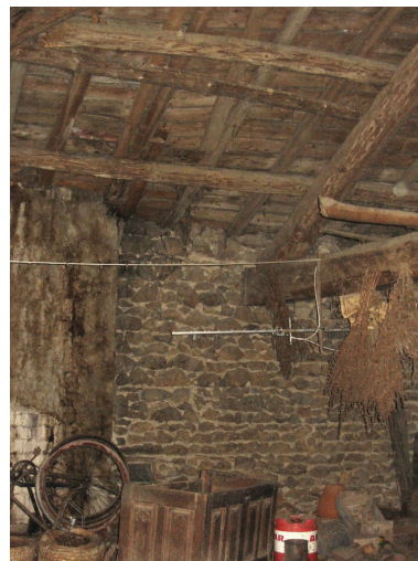
Logis nouveau, comble à surcroît. Détail de la charpente de la croupe. Phot. Thierry Monnet IVR82_20114201749NUCA
