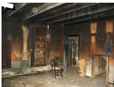
Logis nouveau, cuisine. Vue d'ensemble des ouvertures conduisant sous l'escalier. Phot. Thierry Monnet IVR82_20114201727NUCA
