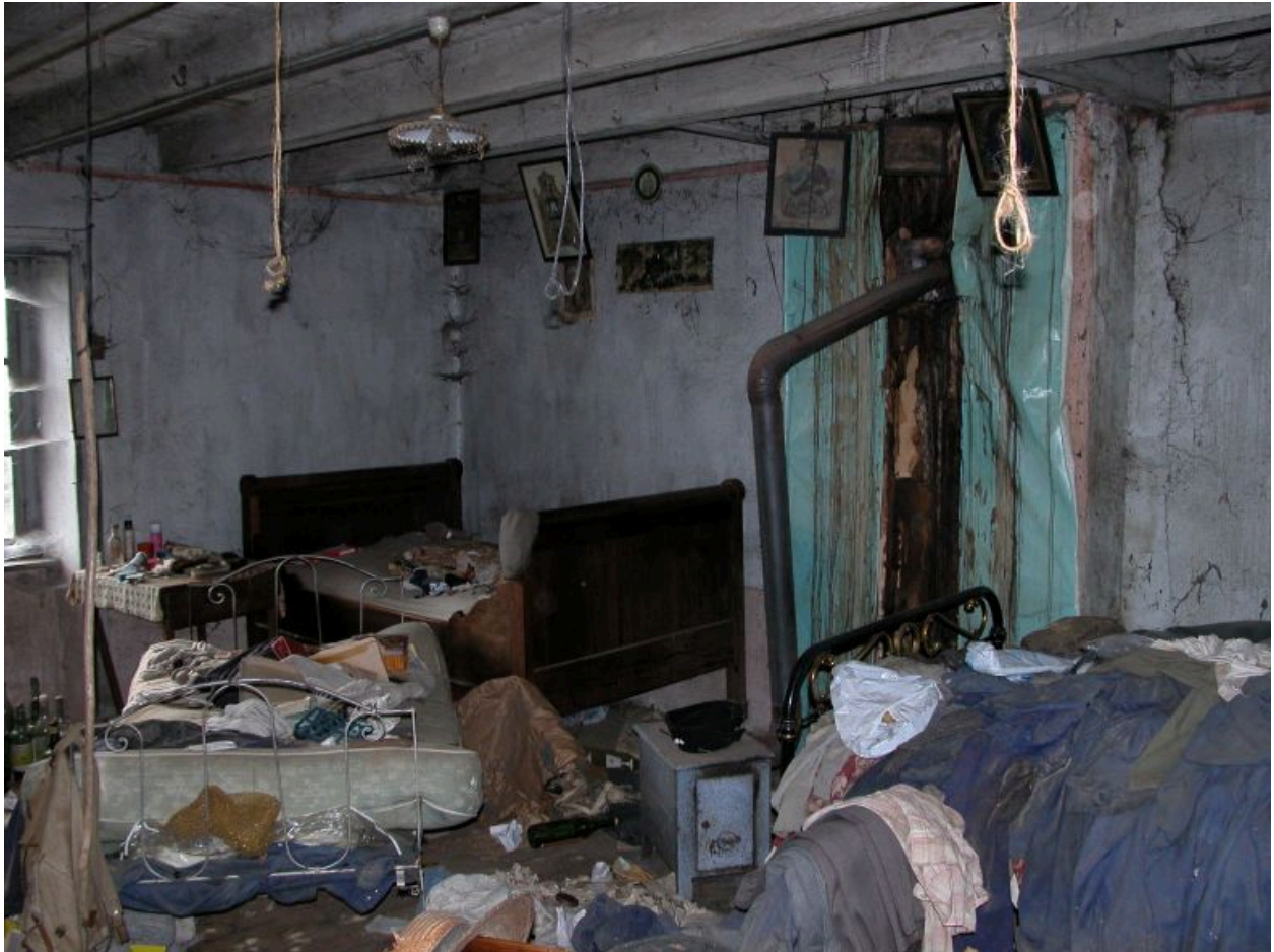
Logis nouveau, chambre. Vue partielle d'une des chambres situées à l'étage.
