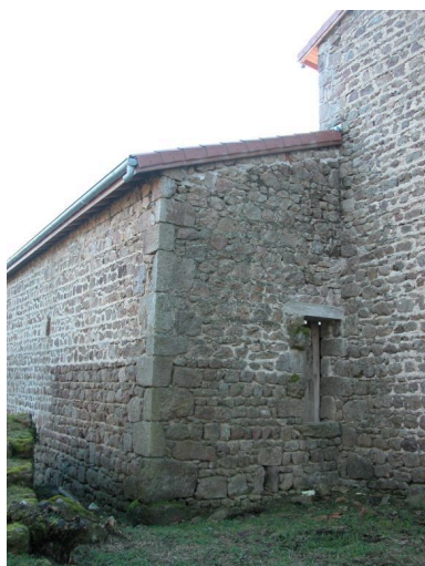
Grange-étable. Vue d'ensemble des murs pignons nord de la grange-étable, et ouest de la remise. Phot. Thierry Monnet IVR82_20124200053NUCA
