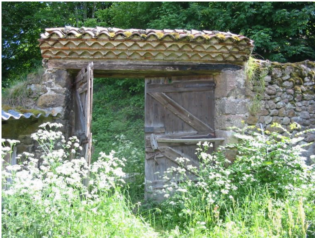
Portail de la cour. Vue d'ensemble depuis l'intérieur de la cour.
