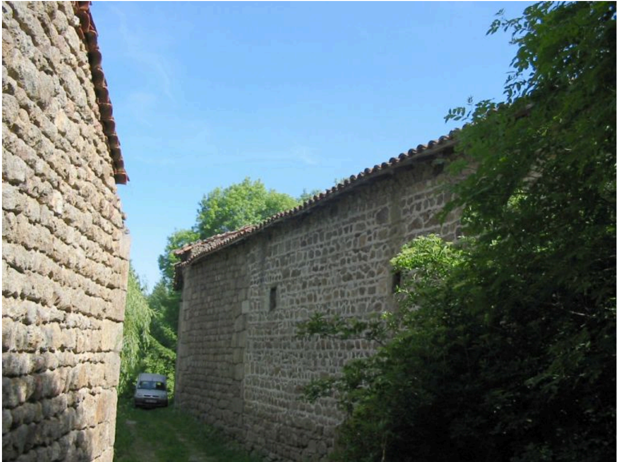
Logis ancien. Vue d'ensemble arrière depuis la rue.
