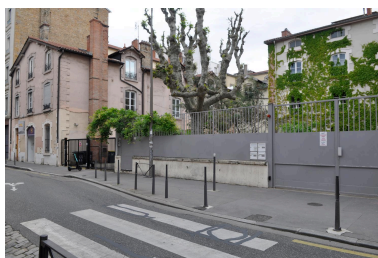
Vue des bâtiments subsistants, depuis la rue Pasteur (aile nord et bâtiment de la meunerie) Phot. Magali Delavenne IVR84_20226900273NUCA
