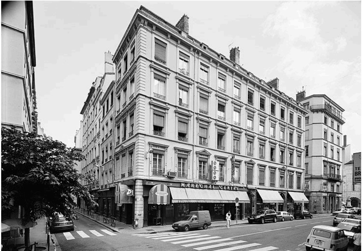
Vue de la partie entre la rue Lanterne et la place Meissonier, côté nord
