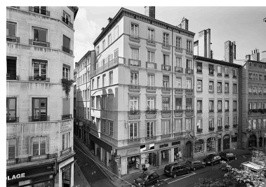
Côté sud de l'ancienne place et croisement avec la rue Lanterne Phot. Didier Gourbin IVR82_20046900840P
