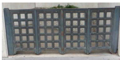
Vue de l'une des deux clôtures métalliques Phot. Véronique Belle IVR82_20186900501NUCA
