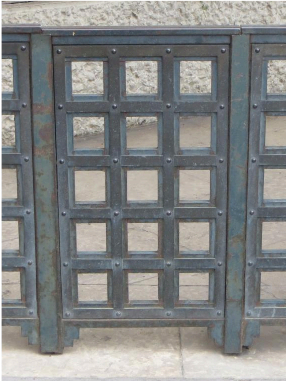
Clôtures métalliques : détail de l'un des panneaux verticaux
