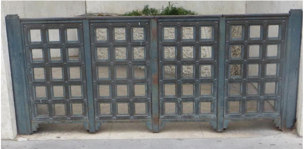
Vue de l'une des deux clôtures métalliques
