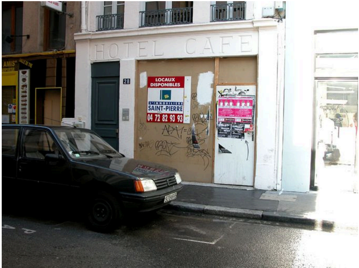
Façade, détail du rez-de-chaussée
