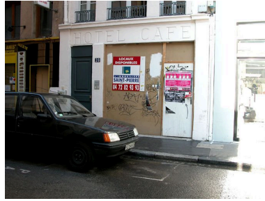
Façade, détail du rez-de-chaussée Phot. Bernard Ducouret IVR82_20046901054NUCA
