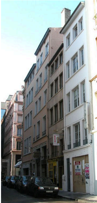
Façade sur rue, vue générale Phot. Bernard Ducouret IVR82_20046901053NUCA
