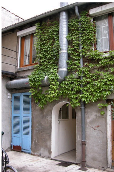
Elévation principale sur la 2e cour, au sud-ouest, partie ouest Phot. N. Giroud IVR82_20046904115NUCA
