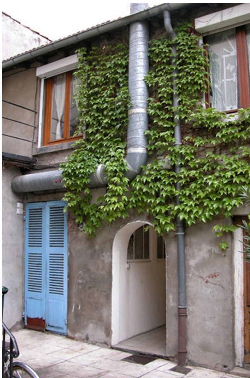
Elévation principale sur la 2e cour, au sud-ouest, partie ouest
