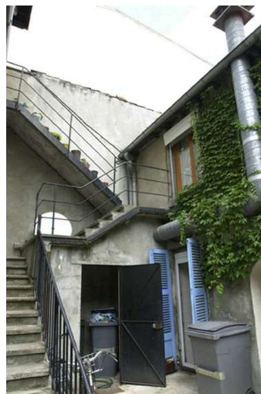
Vue de l'escalier desservant les étages de AD 7 B et AD 7 C Phot. Coralie Belleville IVR82_20046904619NUCA
