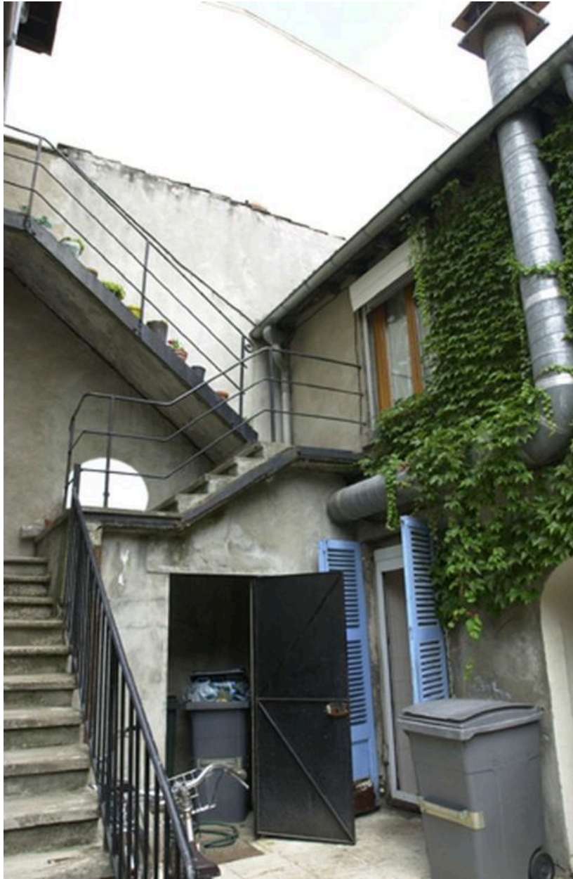
Vue de l'escalier desservant les étages de AD 7 B et AD 7 C
