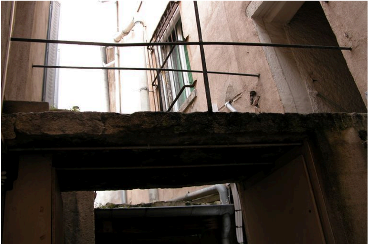
Passerelle reliant l'escalier de AD 7 A à l'étage de AD 7 B
