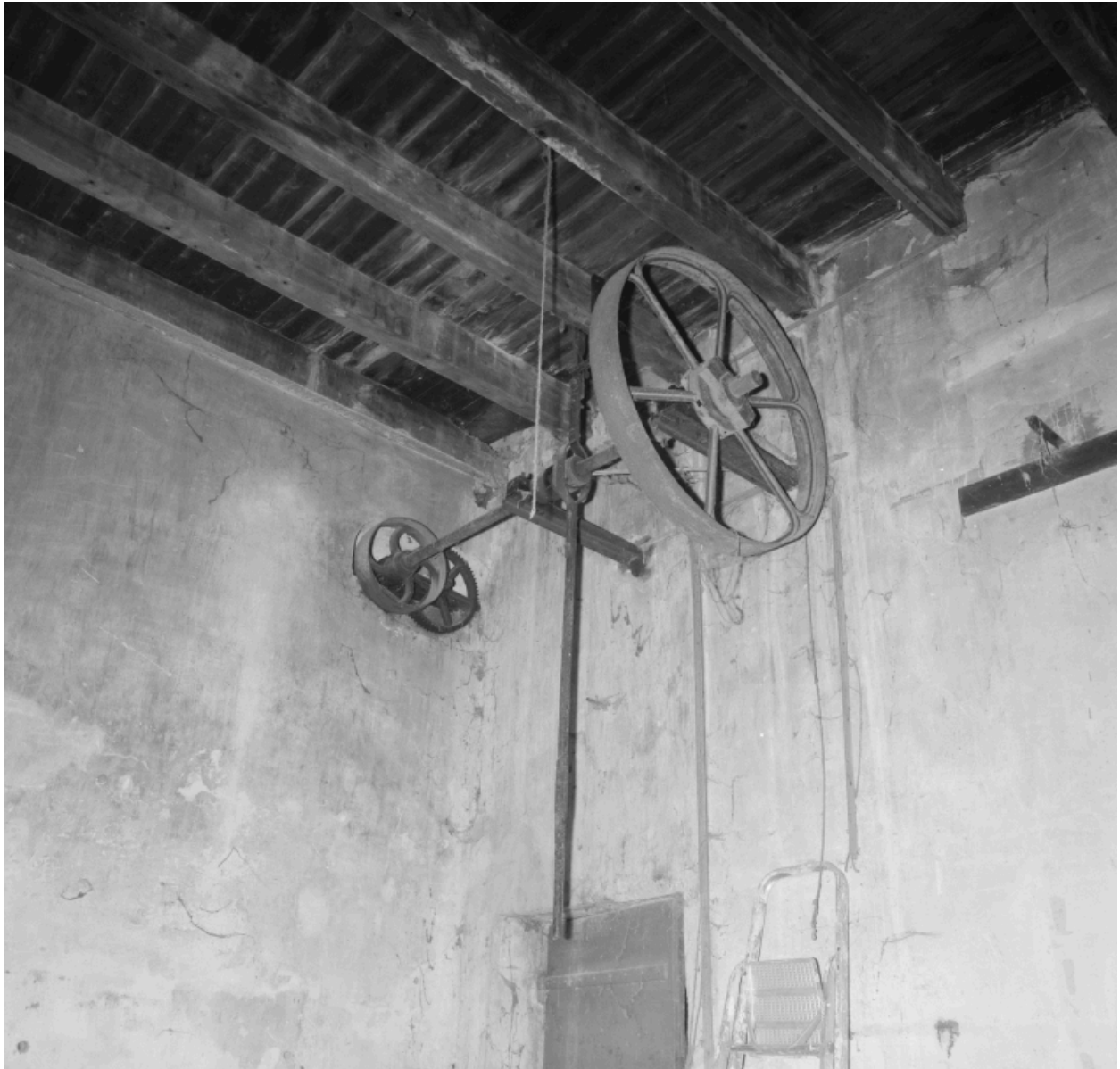
Moulin, système de pompe relié à une turbine.
