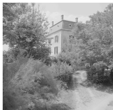
Entrée de l'usine, vue de trois quarts de la maison de maître.
