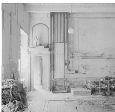
Vue intérieure des ateliers. 1er étage de soubassement, système de monte-charge.
