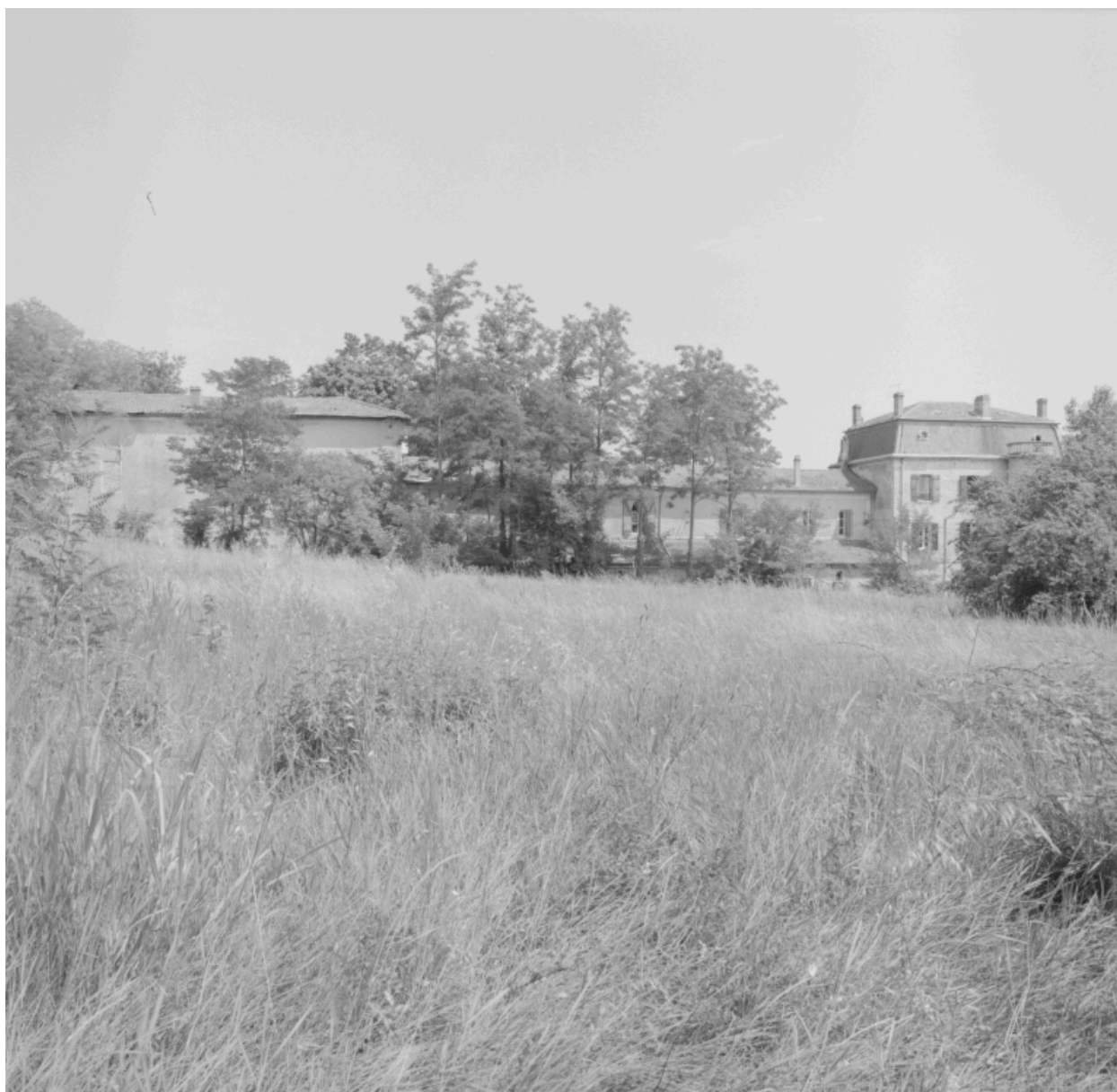
Vue d'ensemble depuis l'ouest : ateliers, chapelle, logement des religieuses et maison de maître.
