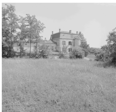
Aile ouest, partie sud, avec la maison de maître à l'extrémité.
