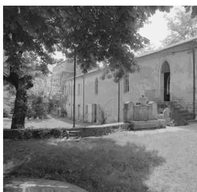
Aile ouest du moulinage, élévation sur jardin : chapelle, logement des religieuses et maison de maître.
