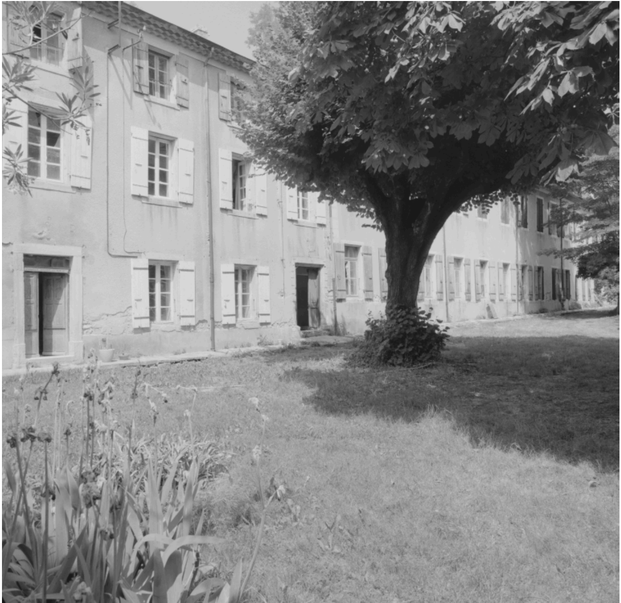
Aile nord, anciens ateliers, vue d'ensemble de la façade sur jardin.
