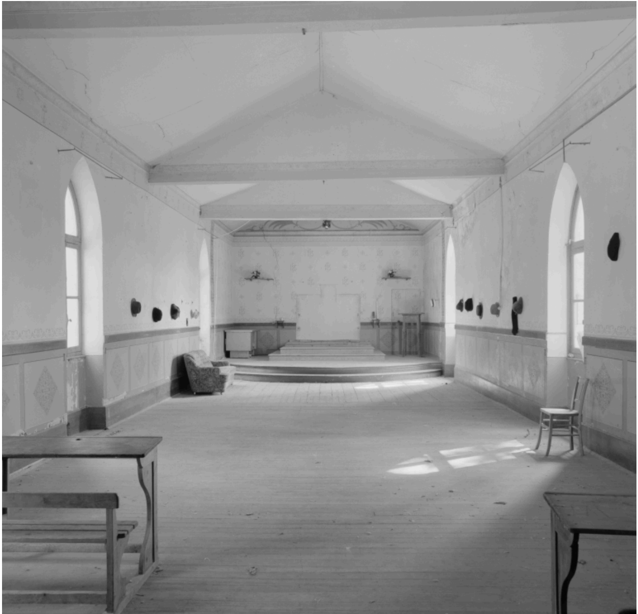
Vue intérieure de l'ancienne chapelle.
