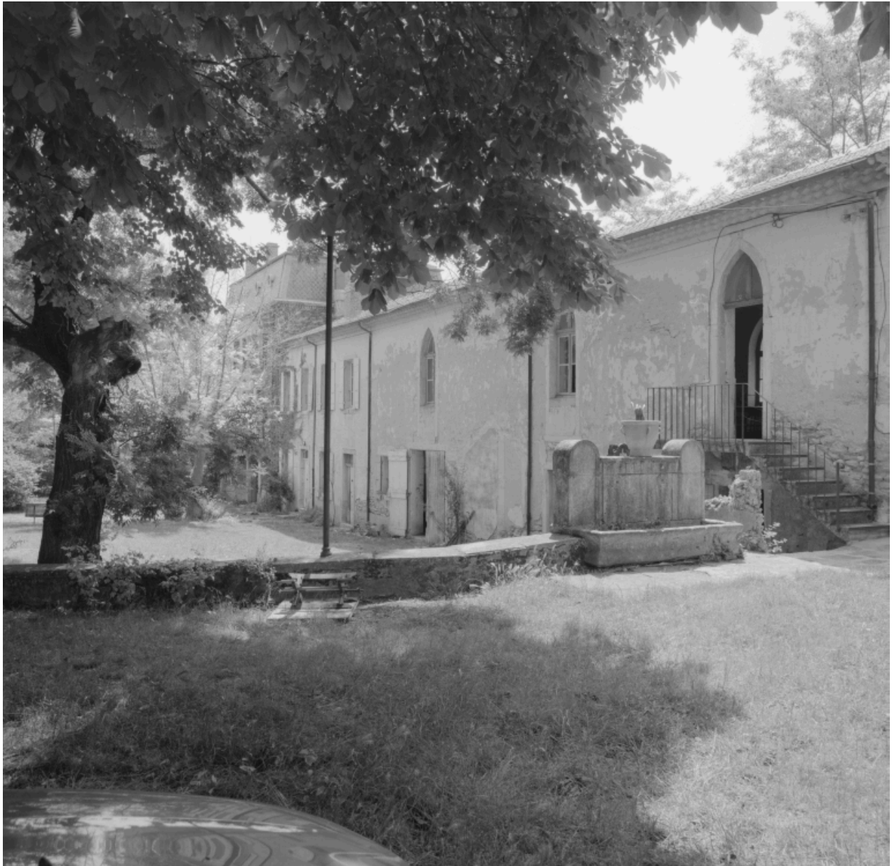
Aile ouest du moulinage, élévation sur jardin : chapelle, logement des religieuses et maison de maître.
