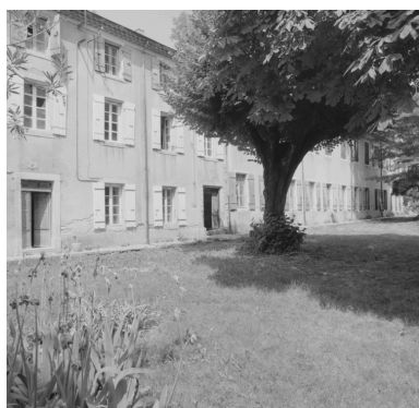
Aile nord, anciens ateliers, vue d'ensemble de la façade sur jardin. Phot. Eric Dessert IVR82_20002600482X
