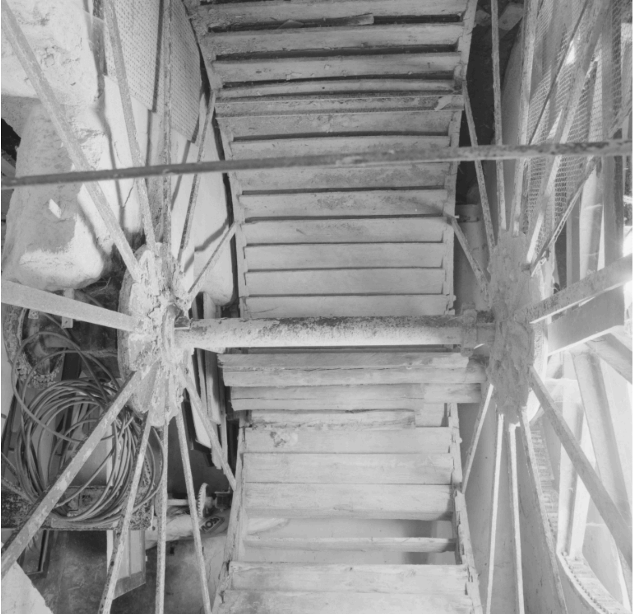
Moulin, détail de la roue actionnée par l'eau du canal.
