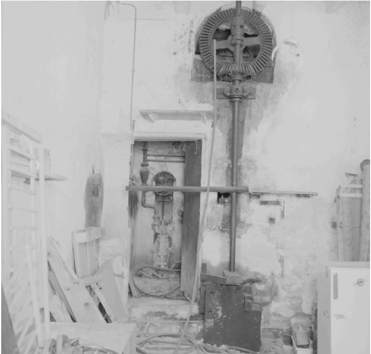
Ancien essieu en partie démonté, situé dans les ateliers du moulinage.
