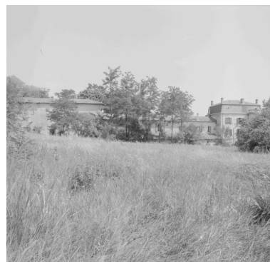
Vue d'ensemble depuis l'ouest : ateliers, chapelle, logement des religieuses et maison de maître.
