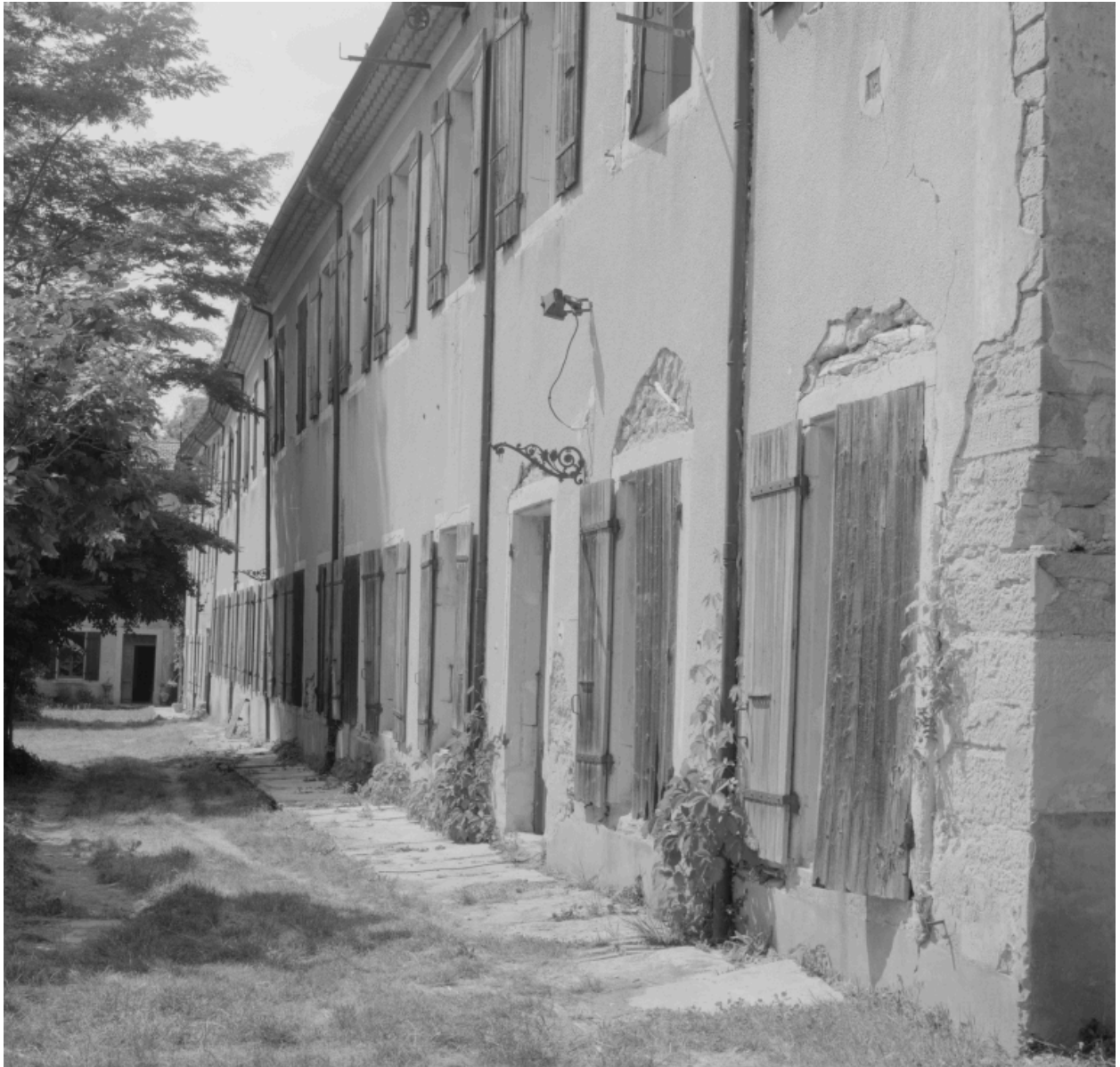
Aile nord, anciens ateliers de moulinage, façade.
