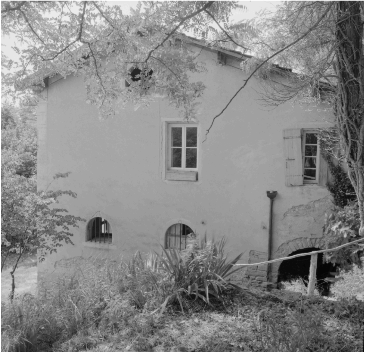
Aile nord, élévation latérale est : mur pignon.
