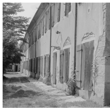
Aile nord, anciens ateliers de moulinage, façade. Phot. Eric Dessert IVR82_20002600730X
