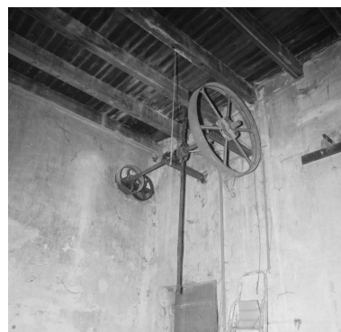
Moulin, système de pompe relié à une turbine. Phot. Eric Dessert IVR82_20002600735X
