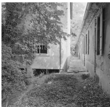
Vue partielle du moulin, à gauche, construit au-dessus du canal. En face, élévation postérieure de l'aile nord : niveau du logement des ouvrières situé au-dessus des ateliers. Phot. Eric Dessert IVR82_20002600718P
