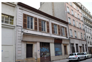
Immeuble, rue Sébastien-Gryphe Phot. Magali Delavenne IVR84_20166902087NUCA
