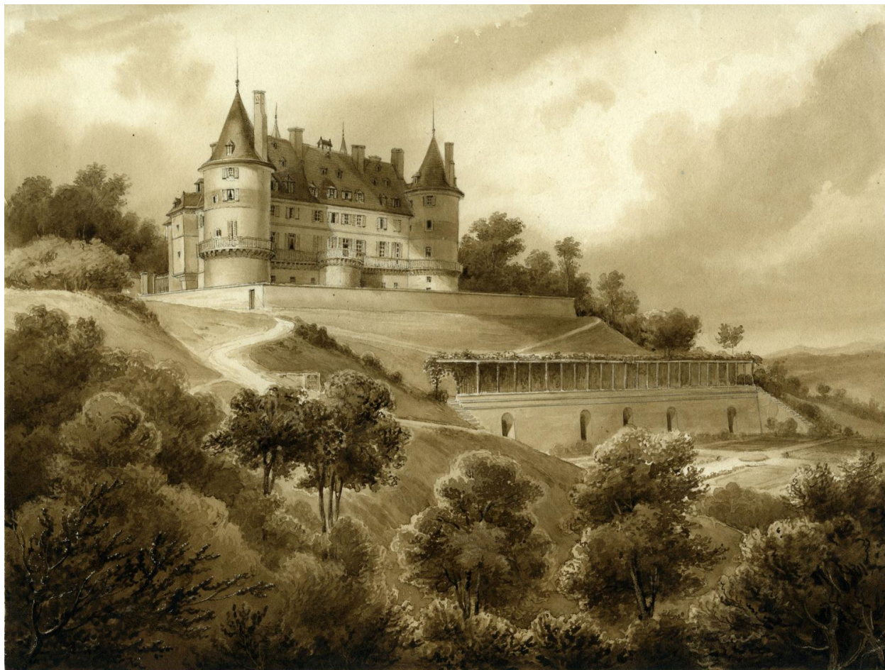
Vue sud après travaux
