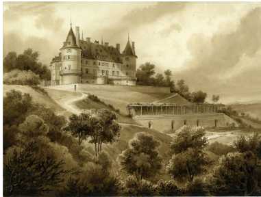
Vue sud après travaux Phot. Lionel Sauzade IVR84_20216300945NUCA
