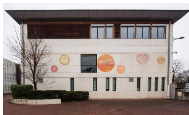
Mur gnomonique Phot. Pascal Lemaître IVR82_20146902058NUCA
