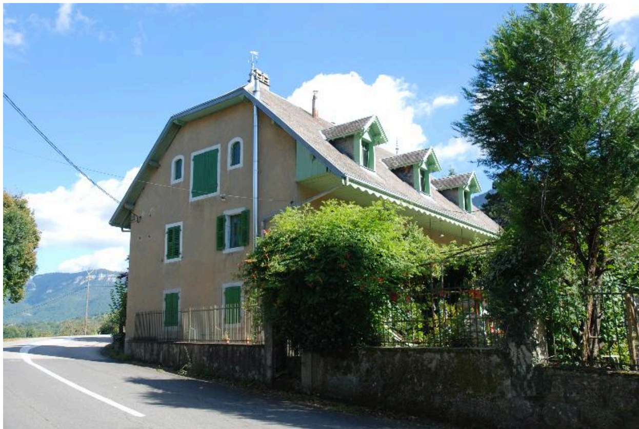
Maison-villa (Trévignin, 2014 B4 947), vue de trois-quarts (face nord-ouest).
