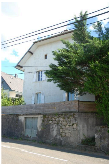
Maison (2014 B4 1280), au-dessus de la RD 913, non repérée. Phot. Caroline Guibaud IVR84_20167304733NUCA
