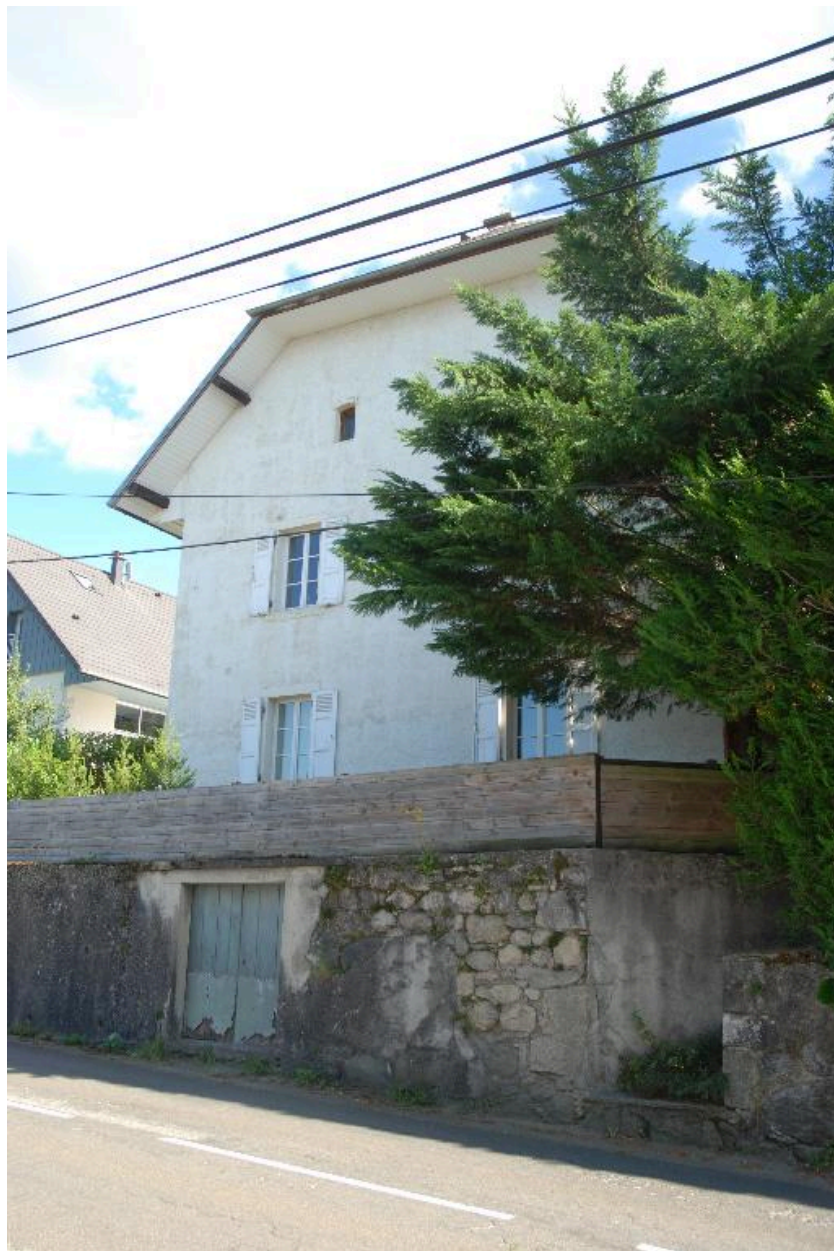
Maison (2014 B4 1280), au-dessus de la RD 913, non repérée.
