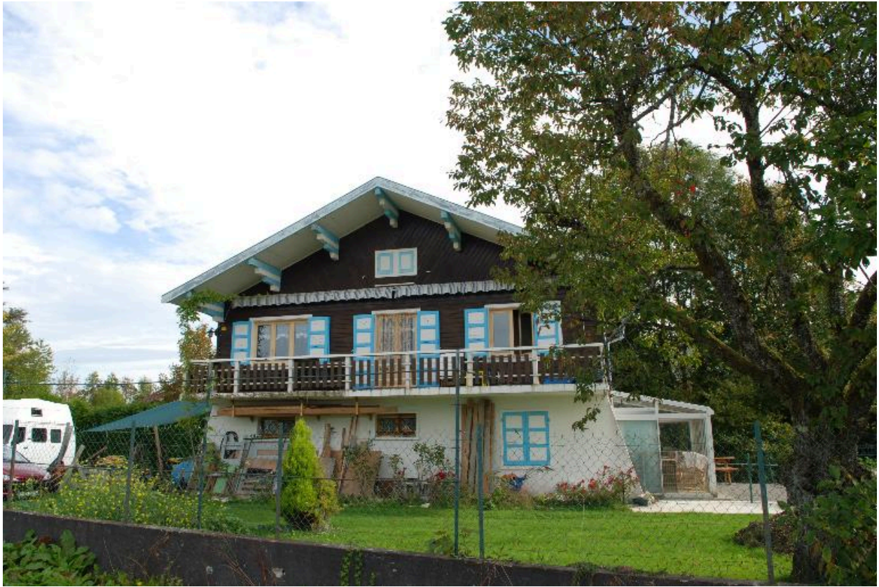
Maison de type "chalet skieur" simialire à ceux édiés à la station du Revard (Verlioz, 2014 B4 1209a, non repéré).
