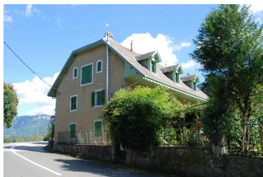
Maison-villa (Trévignin, 2014 B4 947), vue de trois- quarts (face nord-ouest). Phot. Thierry Monnet IVR84_20167304732NUCA
