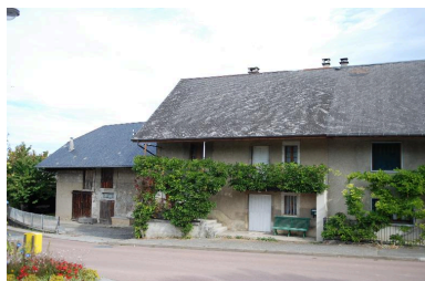
Vue d'ensemble d'une ferme à Trévignin (2014 B4 336), non repérée : partie habitation. Phot. Thierry Monnet IVR84_20177301208NUCA
