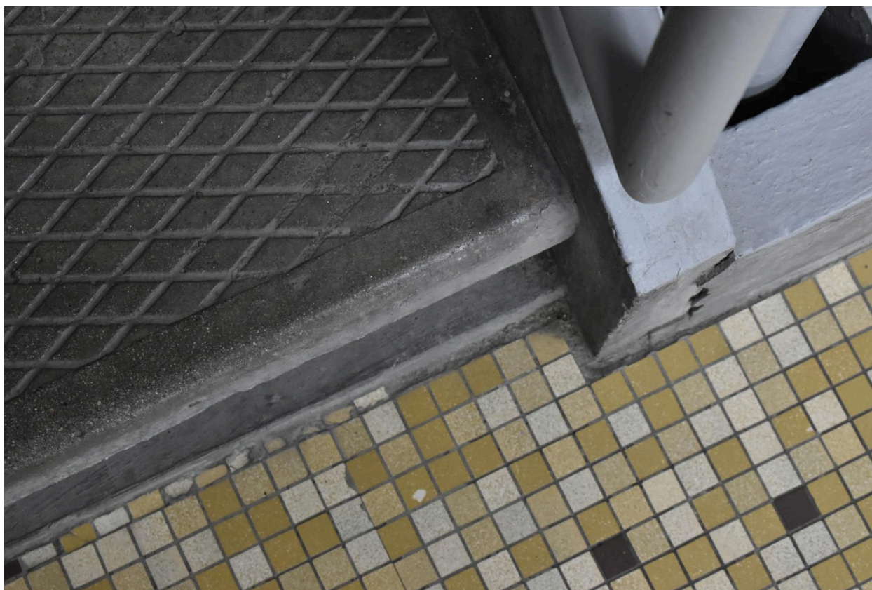
Détail d'un palier du deuxième étage : carrelage en grès-cérame, probablement d'origine, et marche en ciment. (Photo chercheur.)
