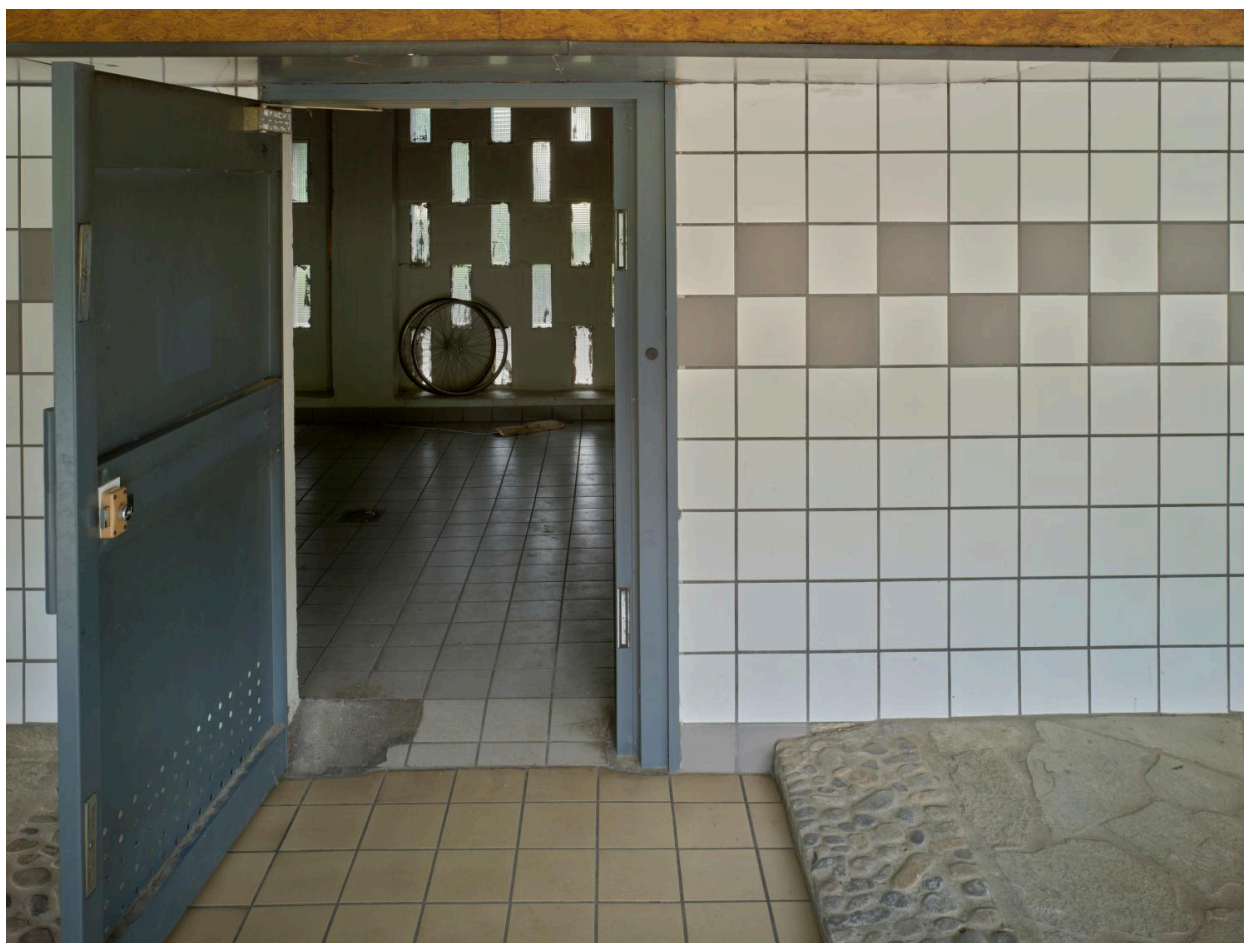
Garage à poussettes éclairé par des pavés de verre, intégrés (a posteriori ?) dans la claustra.
