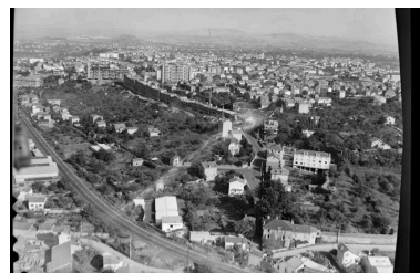
La Muraille de Chine en construction, depuis le nord-ouest. Photographie aérienne de Léon Gendre, [1959]. Phot. Service de numérisation des AD du Puy-de-Dôme IVR84_20216300021NUCA
