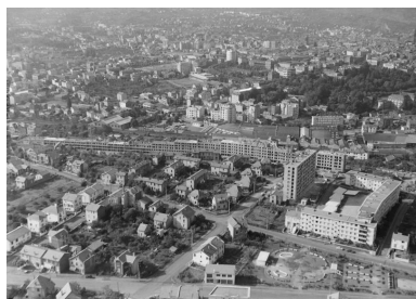
La Muraille de Chine en construction, depuis le sud. Photographie aérienne de Léon Gendre, datant donc probablement de 1959. À droite du cliché sont disposés en U les immeubles d'un premier ensemble préexistant : les HBM dits Les Horizons. Phot. Service de numérisation des AD du Puy-de-Dôme IVR84_20216300019NUCA
