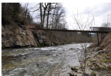
Structures métalliques de l'ancien pont du moulin enjambant le torrent de la Fillière Phot. Samir Mahfoudi, Autr. Samir Mahfoudi IVR82_20107400193NUCA
