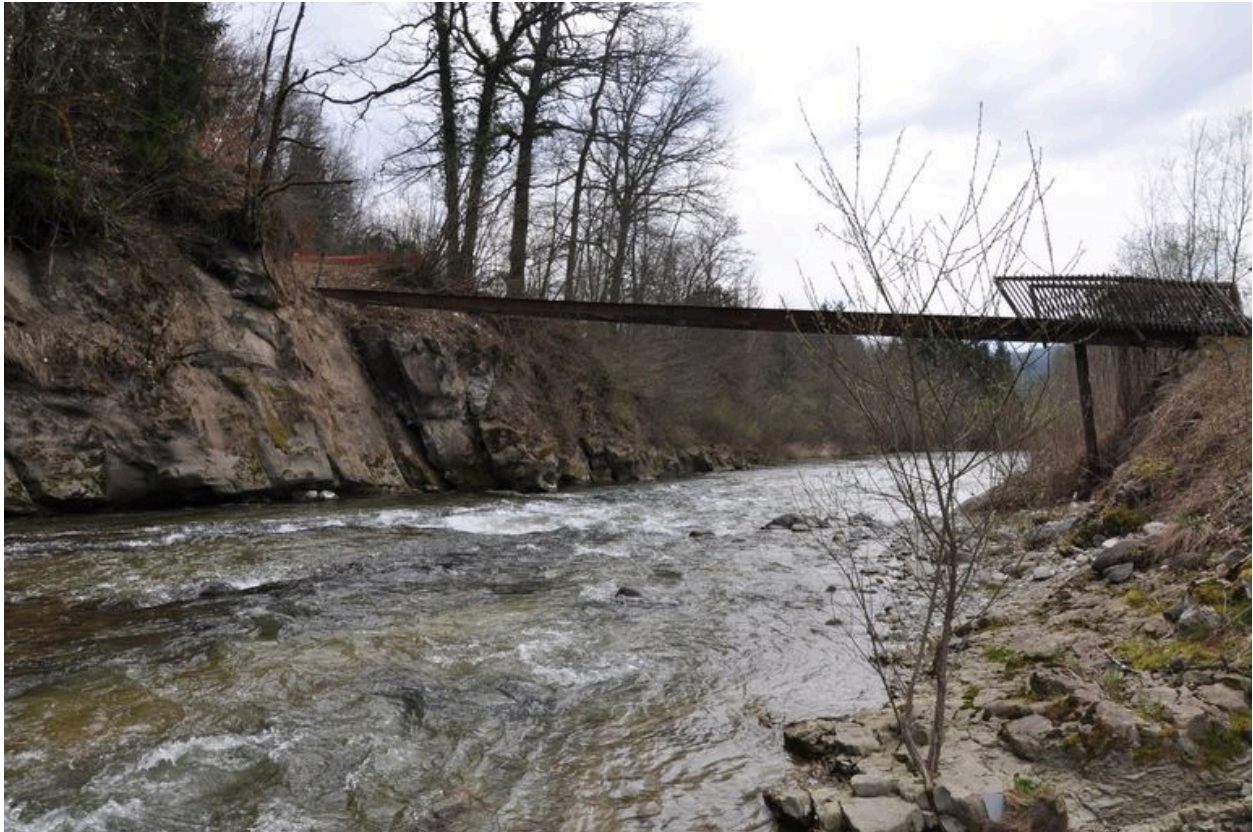
Structures métalliques de l'ancien pont du moulin enjambant le torrent de la Fillière
