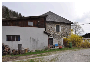
Elévation ouest et extension du bâtiment du moulin Phot. Samir Mahfoudi, Autr. Samir Mahfoudi IVR82_20107400191NUCA
