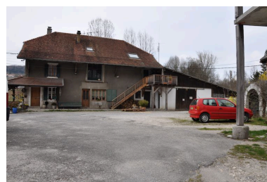
Façade postérieure est de l'ancienne maison du meunier Phot. Samir Mahfoudi, Autr. Samir Mahfoudi IVR82_20107400181NUCA
