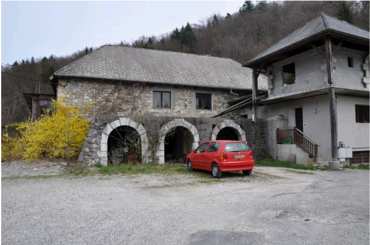
Façade latérale sud avec extensions en appentis du bâtiment du moulin
