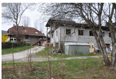
Vue d'ensemble des extensions en appentis du moulin et de la maison du meunier Phot. Samir Mahfoudi, Autr. Samir Mahfoudi IVR82_20107400187NUCA
