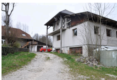
Ancien canal de fuite du moulin comblé par une chemin près du torrent de la Fillière Phot. Samir Mahfoudi, Autr. Samir Mahfoudi IVR82_20107400190NUCA
