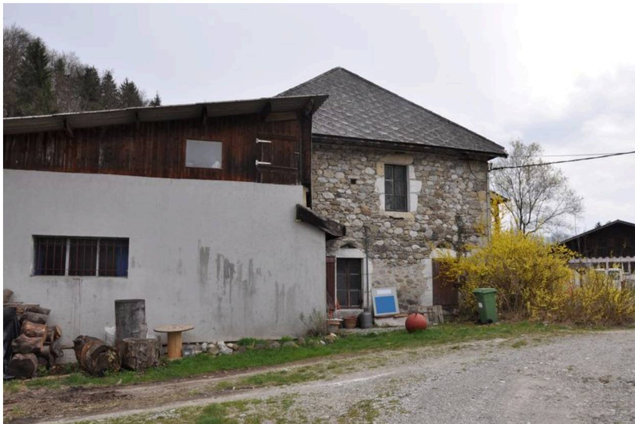
Elévation ouest et extension du bâtiment du moulin
