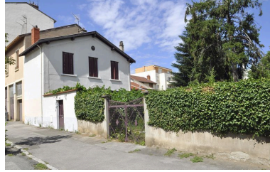
Vue de la façade antérieure et de la façade latérale. Phot. Julien Defillon IVR82_20106901185NUCA
