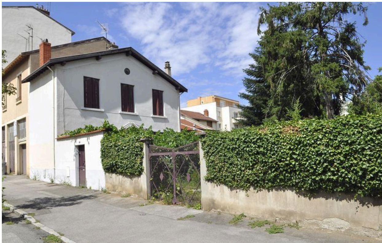
Vue de la façade antérieure et de la façade latérale.
