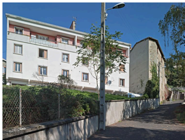
Partie centrale de la rue, en direction du haut. Phot. Jean-Michel Périn IVR83_20146301026NUC4A
