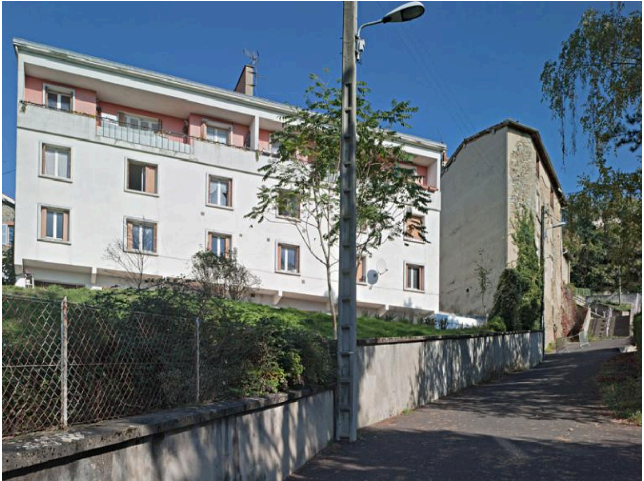
Partie centrale de la rue, en direction du haut.
