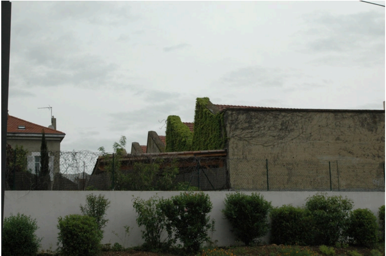
Façade arrière, détail des sheds, vue sud.
