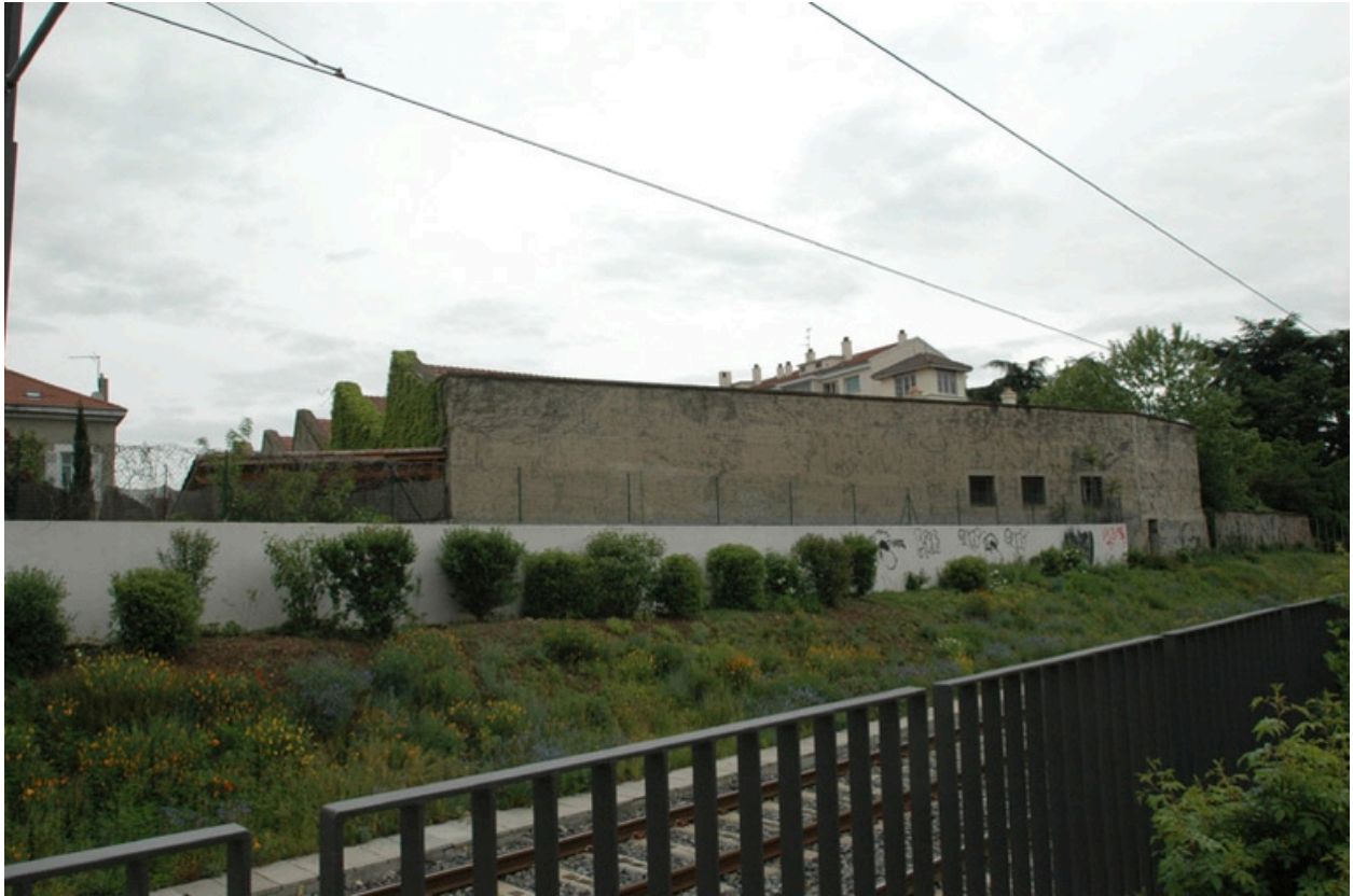
Façade arrière et voie ferrée, vue sud.
