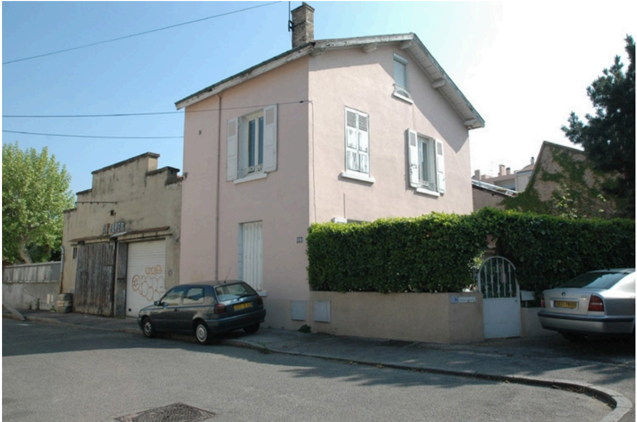
Atelier arrière, toits en sheds. Vue sud ouest.
