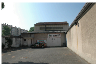
Atelier, vue nord. Phot. Nadine Halitim-Dubois IVR82_20096901776NUCA
