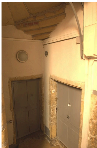
Cage d'escalier : trompe et portes palières Phot. Véronique Belle IVR82_20086901274NUCA
