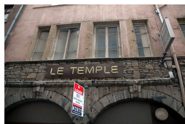
Détail des baies du premier étage Phot. Véronique Belle IVR82_20086902008NUCA
