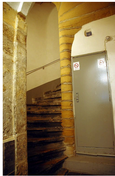
Départ d'escalier Phot. Véronique Belle IVR82_20086902009NUCA
