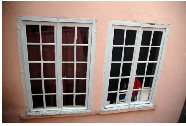
Corps de bâtiment ouest : détail de fenêtres à petits carreaux Phot. Véronique Belle IVR82_20086902012NUCA
