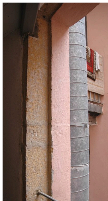
Cage d'escalier : détail de marques de tâcherons Phot. Véronique Belle IVR82_20086902011NUCA
