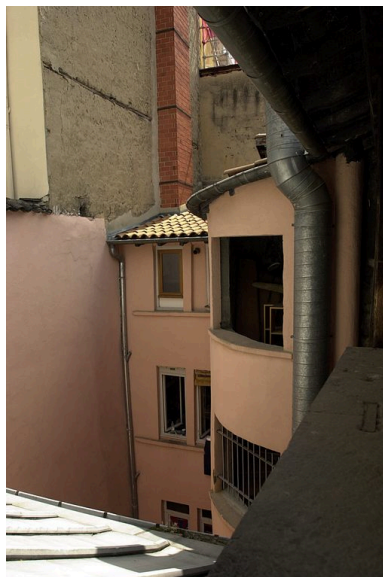
La cage d'escalier et le corps de bâtiment est depuis la galerie desservant le corps de bâtiment ouest, dernier étage Phot. Véronique Belle IVR82_20086901273NUCA
