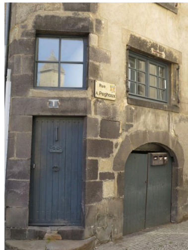
Entrées de l'habitation et de la cave Phot. Bruno Decrock IVR84_20206300107NUCA
