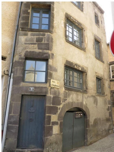
Vue partielle de la façade principale Phot. Bruno Decrock IVR84_20206300106NUCA
