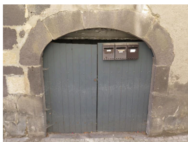
Entrée de la cave Phot. Bruno Decrock IVR84_20206300108NUCA
