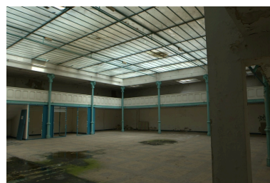
Vue nord-est Phot. Nadine Halitim-Dubois IVR82_20086900289NUCA
