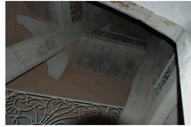
Détail escalier de l'immeuble de la rue Sainte-Marie-des-Terreux Phot. Nadine Halitim-Dubois IVR82_20086900215NUCA
