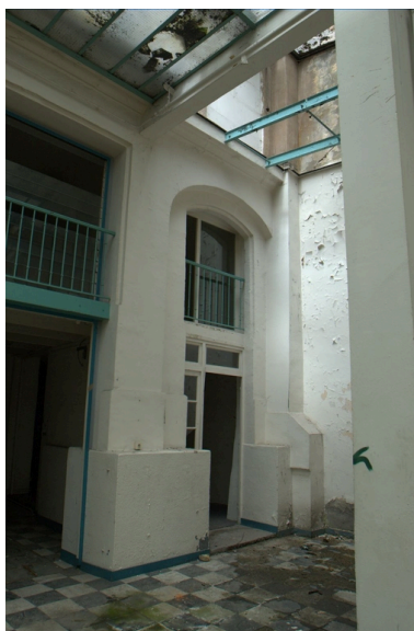
Détail ouverture latérale de la halle Phot. Nadine Halitim-Dubois IVR82_20086900285NUCA
