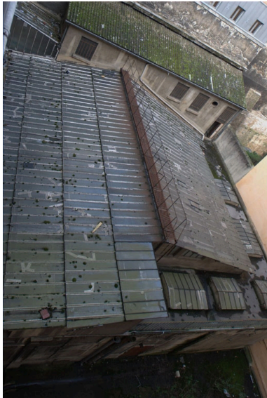
Détail de la toiture Phot. Nadine Halitim-Dubois IVR82_20086900213NUCA
