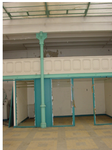
Détail vue intérieure Phot. Philippe Marin-Lafèche IVR82_20086900323NUCA
