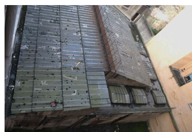
Détail de la toiture de l'atelier Phot. Nadine Halitim-Dubois IVR82_20086900212NUCA
