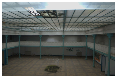
Vue de la grande halle Phot. Nadine Halitim-Dubois IVR82_20086900296NUCA
