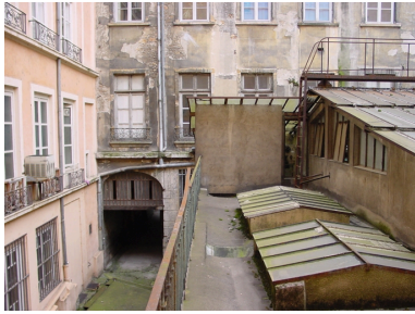
Détail verrière Phot. Philippe Marin-Lafèche IVR82_20086900346NUCA
