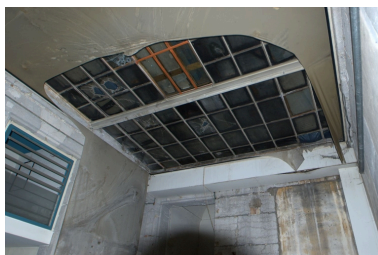
Plaque de verre permettant l'éclairage du sous-sol Phot. Nadine Halitim-Dubois IVR82_20086900294NUCA
