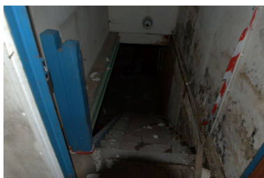
Escaliers menant au sous-sol Phot. Nadine Halitim-Dubois IVR82_20086900291NUCA
