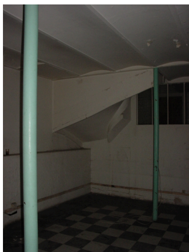
Détail plafond (entrevous) Phot. Philippe Marin-Lafèche IVR82_20086900330NUCA
