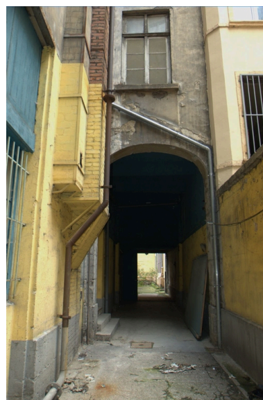
Vue ouest Phot. Nadine Halitim-Dubois IVR82_20086900316NUCA
