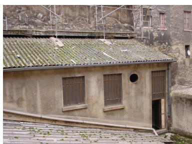
Détail toiture Phot. Philippe Marin-Lafèche IVR82_20086900333NUCA
