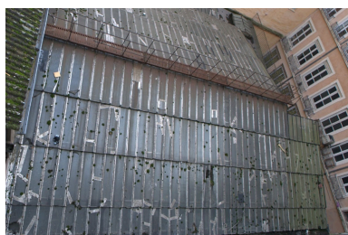
Détail passerelle de la verrière Phot. Nadine Halitim-Dubois IVR82_20086900207NUCA
