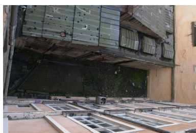
Passage principal, vue zénithale ouest Phot. Nadine Halitim-Dubois IVR82_20086900211NUCA
