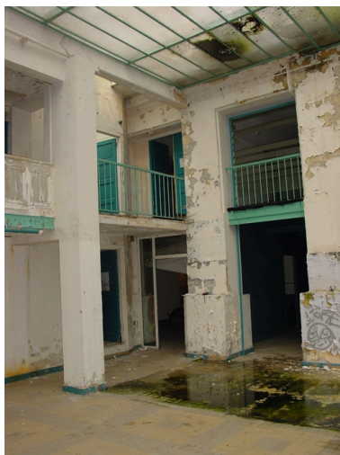
Vue intérieure Phot. Philippe Marin-Lafèche IVR82_20086900322NUCA
