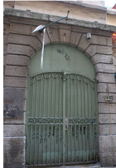
Accès latéral droit à la verrière Phot. Nadine Halitim-Dubois IVR82_20086900218NUCA
