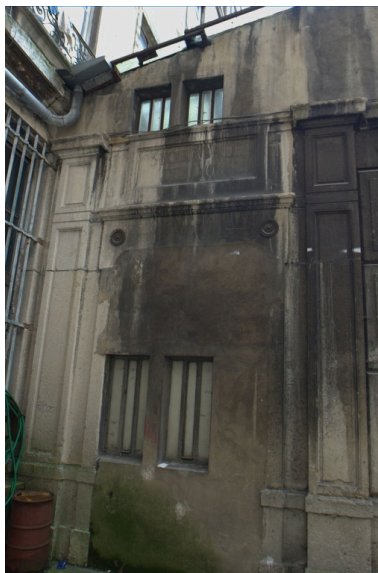
Entrée de la halle localisée dans l'impasse Phot. Nadine Halitim-Dubois IVR82_20086900279NUCA
