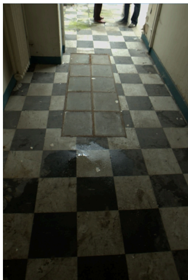
Plaques de verre permettant l'éclairage du sous-sol Phot. Nadine Halitim-Dubois IVR82_20086900293NUCA
