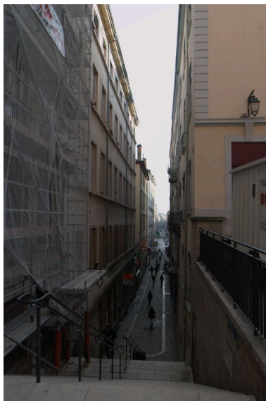
Vue nord de l'immeuble XVIIIe de la rue Sainte-Marie-des-Terreux Phot. Nadine Halitim-Dubois IVR82_20086900220NUCA
