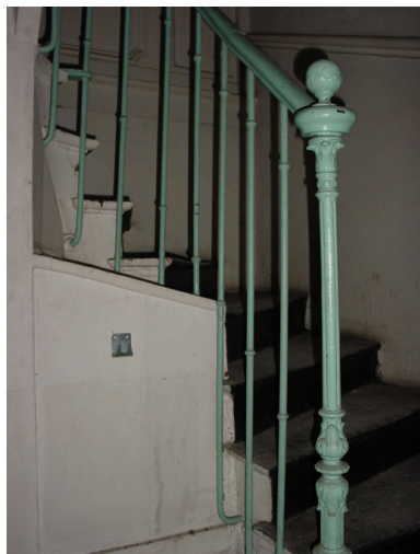
Détail escalier et rampe Phot. Philippe Marin-Lafèche IVR82_20086900327NUCA
