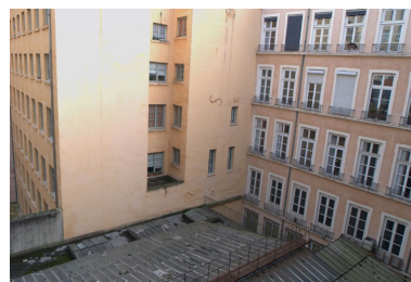
Verrière vue ouest Phot. Nadine Halitim-Dubois IVR82_20086900206NUCA
