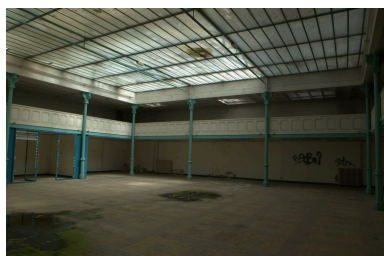
Vue ouest Phot. Nadine Halitim-Dubois IVR82_20086900290NUCA
