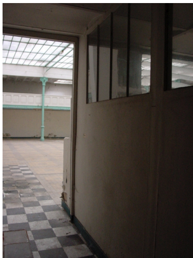
Circulation intérieure Phot. Philippe Marin-Lafèche IVR82_20086900328NUCA
