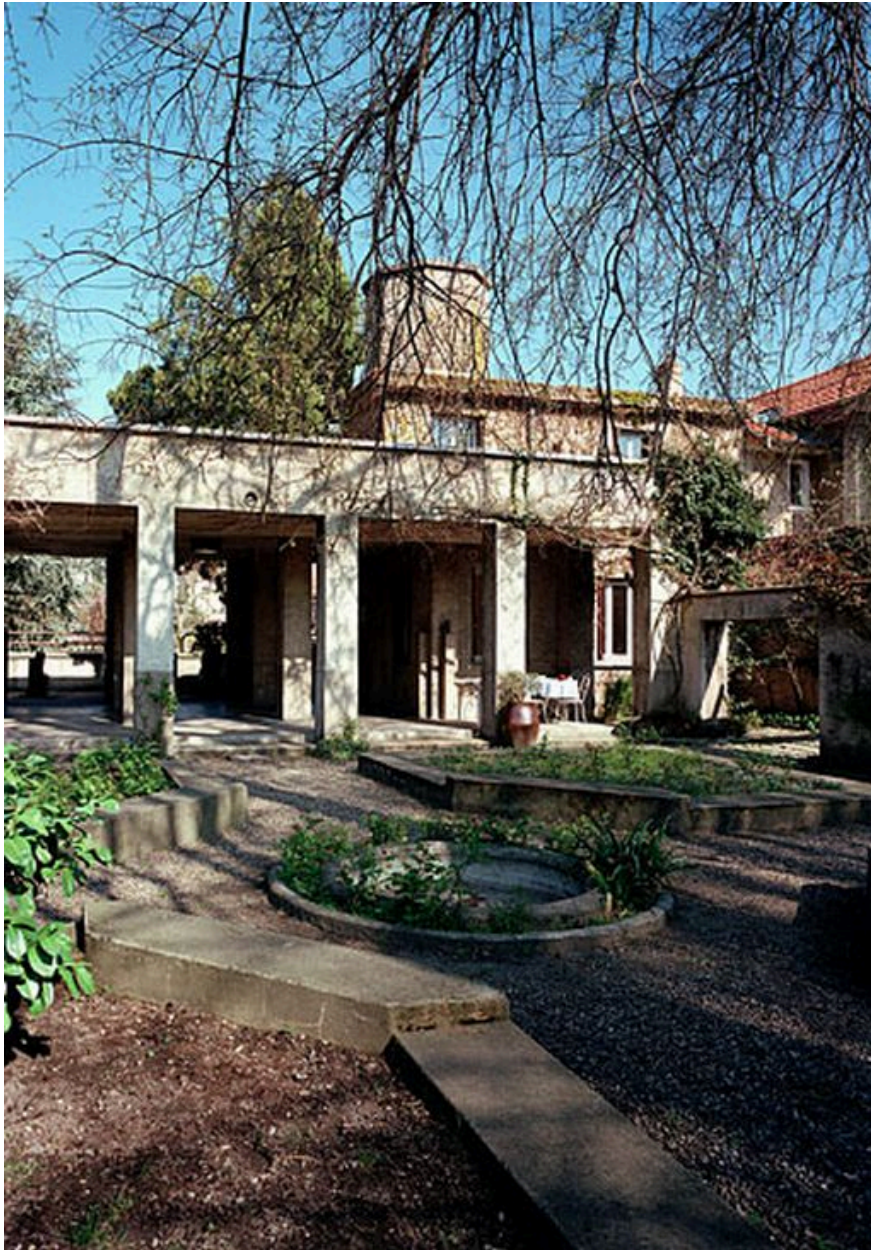
Vue partielle de la maison et du portique avec le jardin au premier plan
