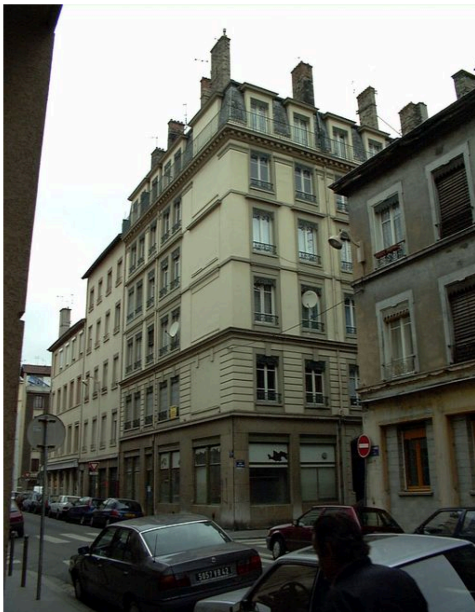
Vue générale depuis la rue Victor-Hugo
