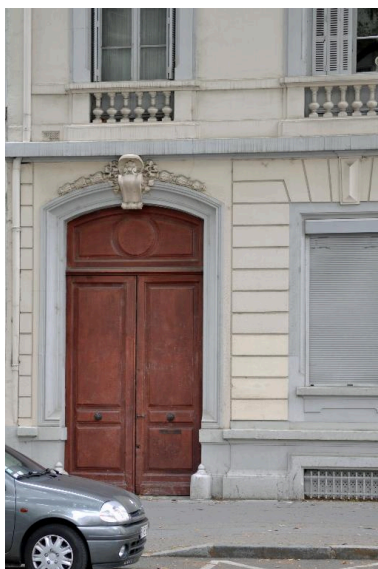
Élévation sur l'avenue Jean- Jaurès, détail de la porte bâtarde Phot. Magali Delavenne IVR84_20176901459NUCA
