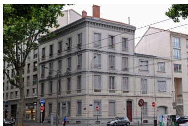
Vue d'ensemble, prise depuis le nord-ouest Phot. Magali Delavenne IVR84_20176901458NUCA
