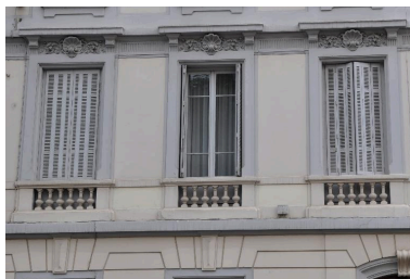
Elévation sur la rue du Père-Chevrier, détail des fenêtres à décor de coquilles du premier étage Phot. Magali Delavenne IVR84_20176901465NUCA
