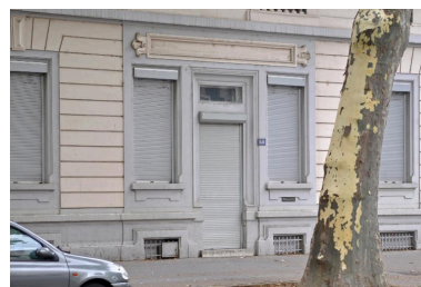
Élévation sur l'avenue Jean- Jaurès, détail de l'ancien magasin Phot. Magali Delavenne IVR84_20176901460NUCA
