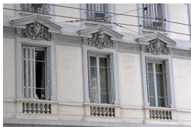
Élévation sur l'avenue Jean- Jaurès, détail des fenêtres à décor sculpté du premier étage Phot. Magali Delavenne IVR84_20176901461NUCA
