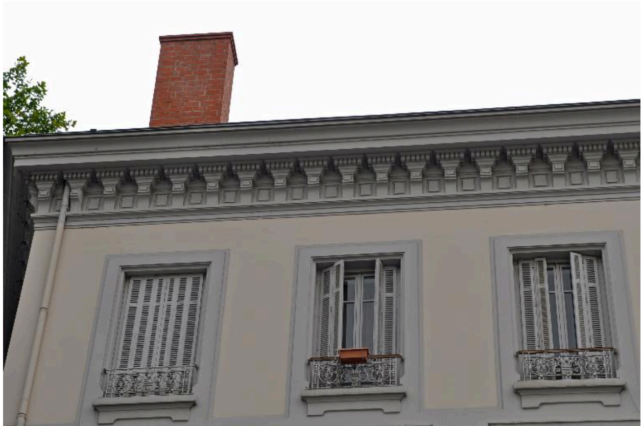
Elévation sur la rue du Père-Chevrier, détail du couronnement et de la corniche sculptée
