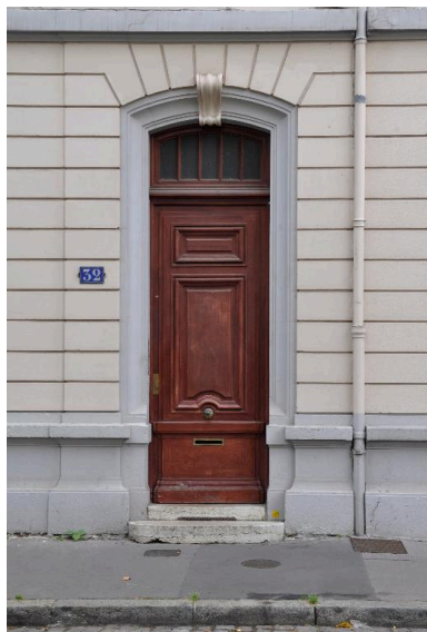
Elévation sur la rue du Père-Chevrier, détail de la porte piétonne Phot. Magali Delavenne IVR84_20176901464NUCA
