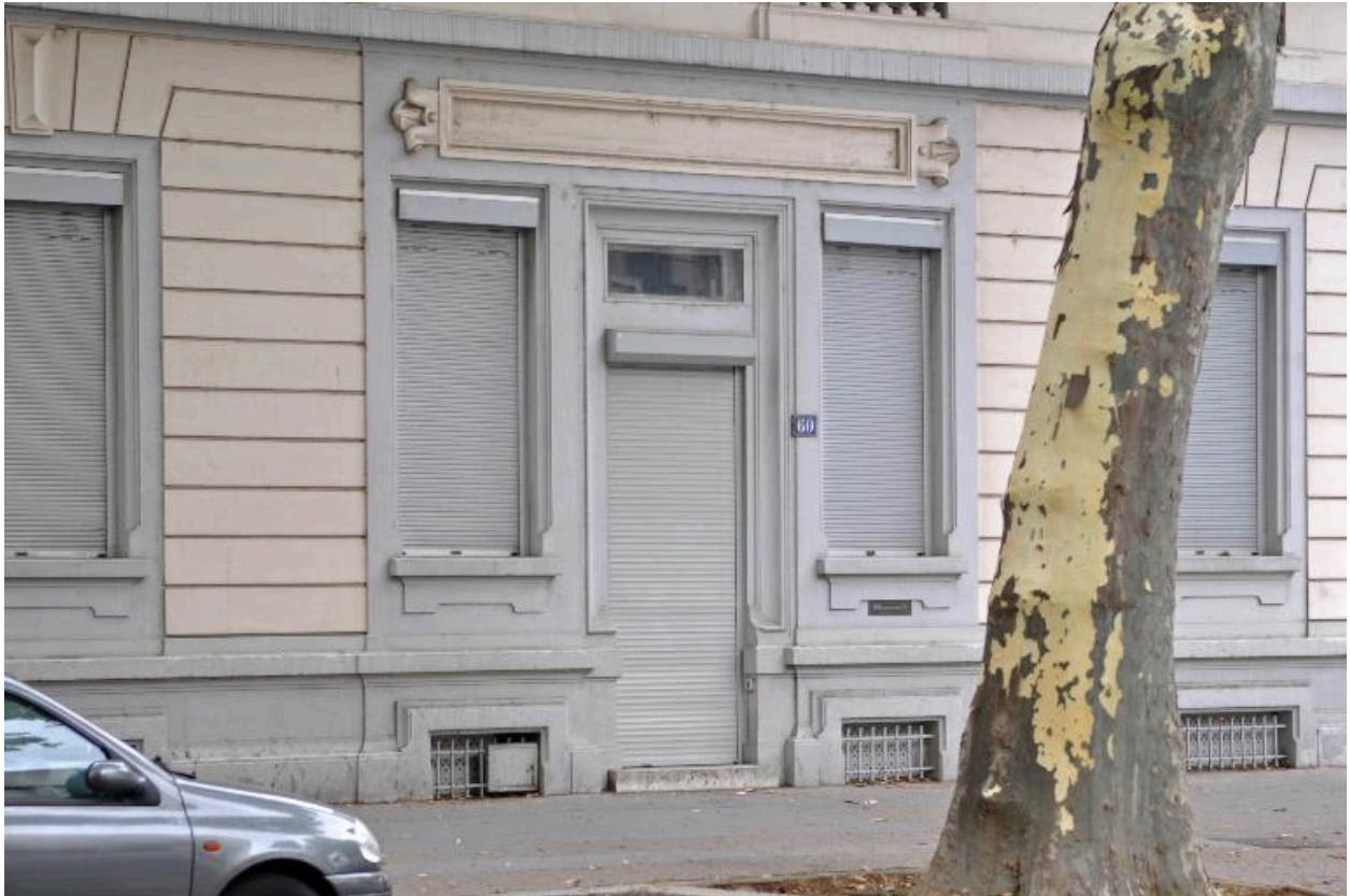
Elévation sur l'avenue Jean-Jaurès, détail de l'ancien magasin
