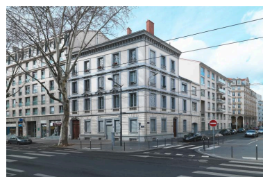
Vue de situation depuis l'est Phot. Franck Trabouillet IVR84_20196900283NUCAQ
