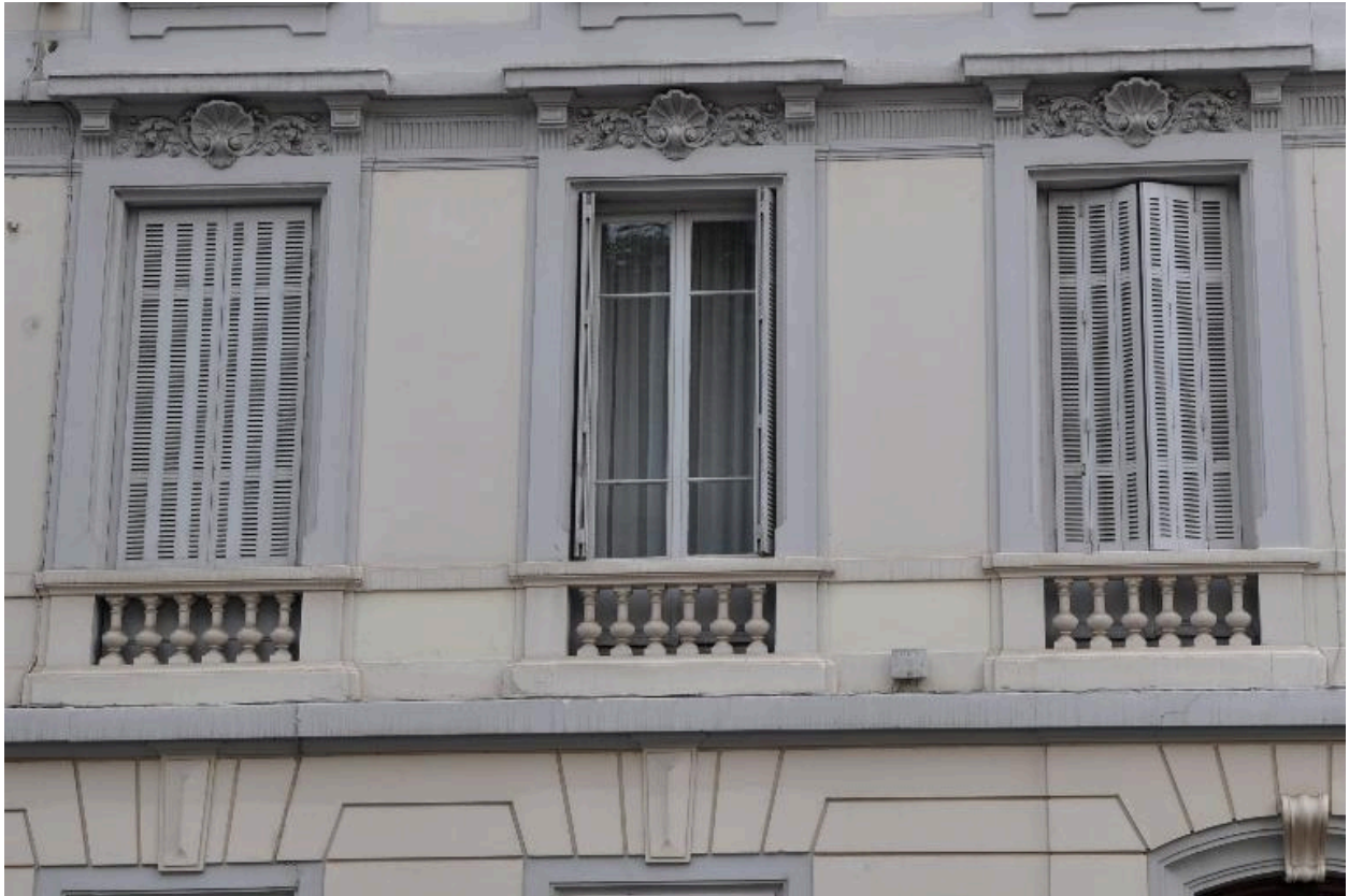
Elévation sur la rue du Père-Chevrier, détail des fenêtres à décor de coquilles du premier étage
