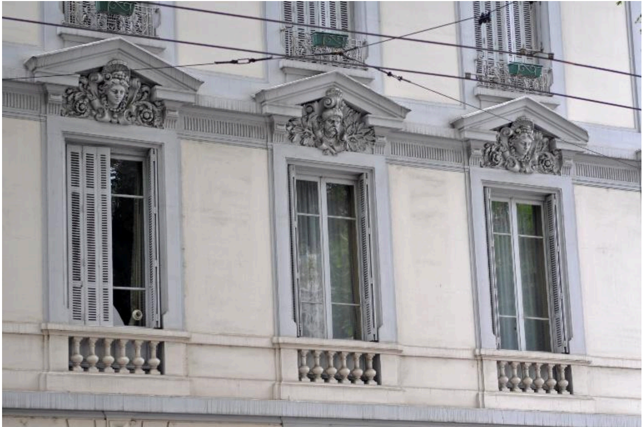
Elévation sur l'avenue Jean-Jaurès, détail des fenêtres à décor sculpté du premier étage
