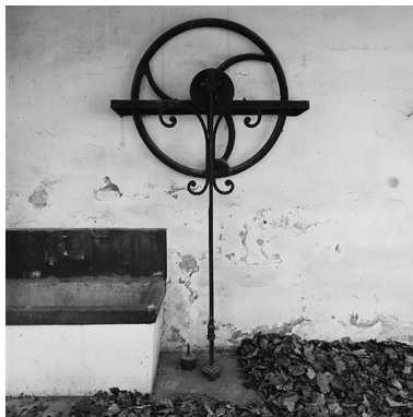
Cour attenante au logement du gardien, ouvrant 4, rue des Alouettes, pompe vue de face Phot. Eric Dessert IVR82_20006900225X
