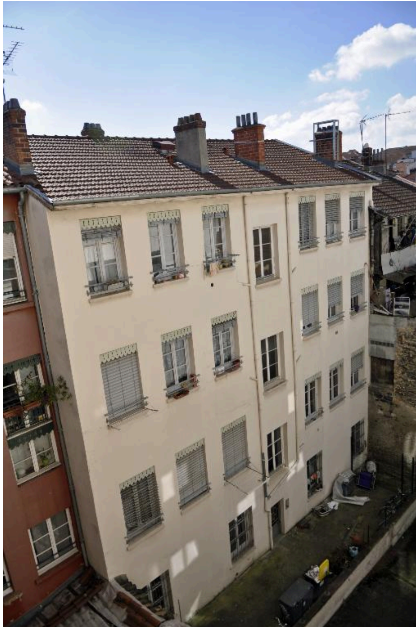
Vue générale, élévation sur cour
