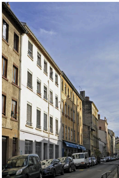
Vue générale, élévation sur rue Phot. Catherine Guégan IVR84_20176901001NUCA
