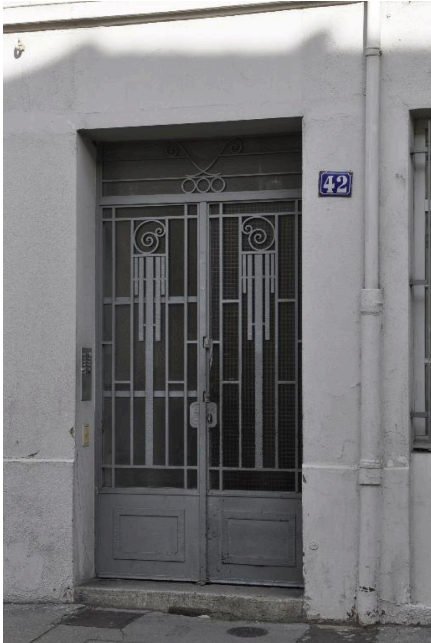
Vue rapprochée de la porte, ferronneries Art Déco
