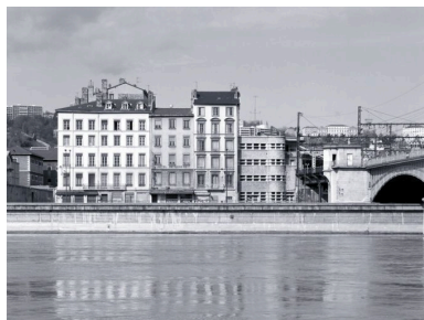
Vue générale depuis l'est Phot. Eric Dessert IVR82_20026903020X
