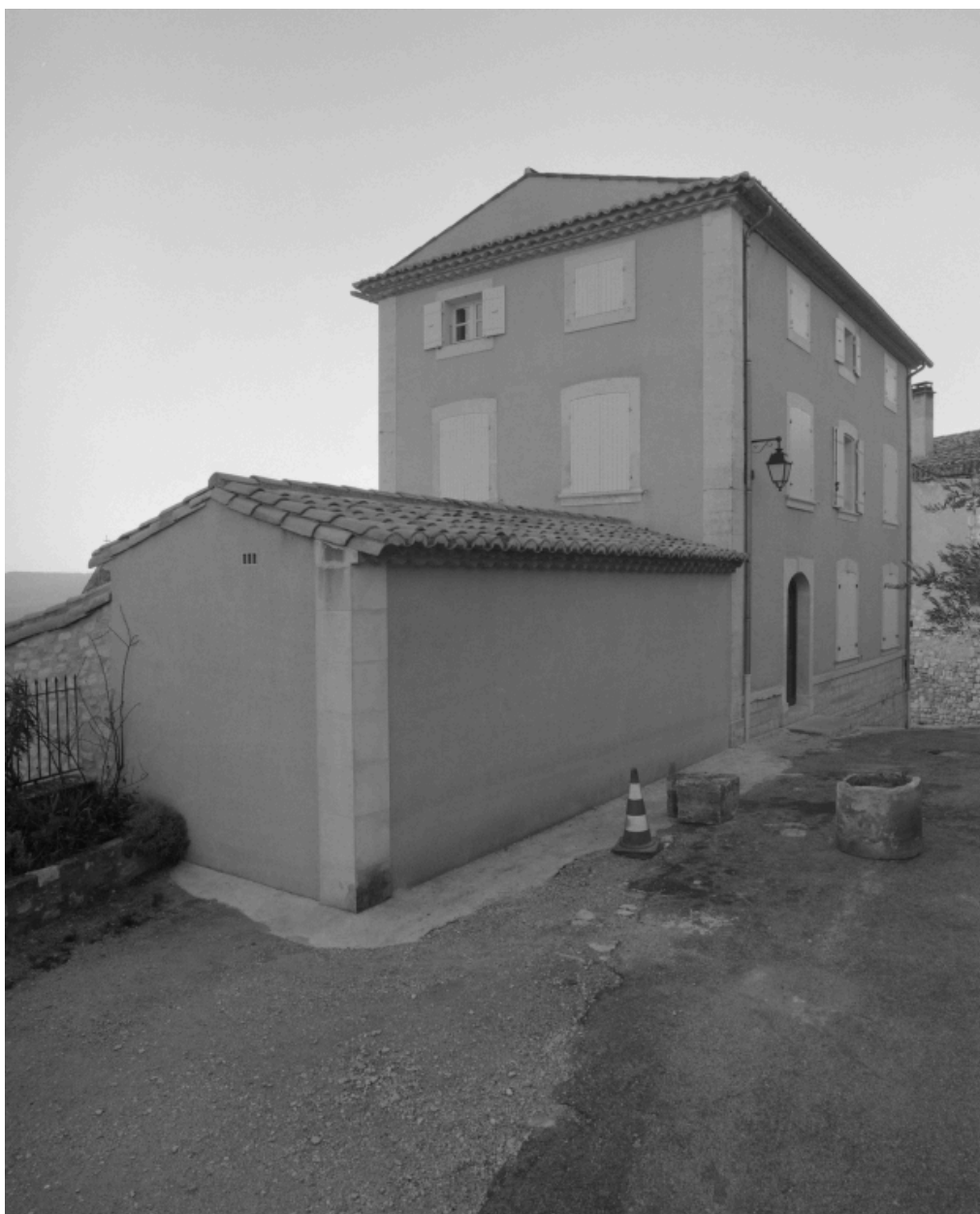
Vue de 3/4 de l'ancienne école de filles, sur la rue des Ecoles et le Belvédère.
