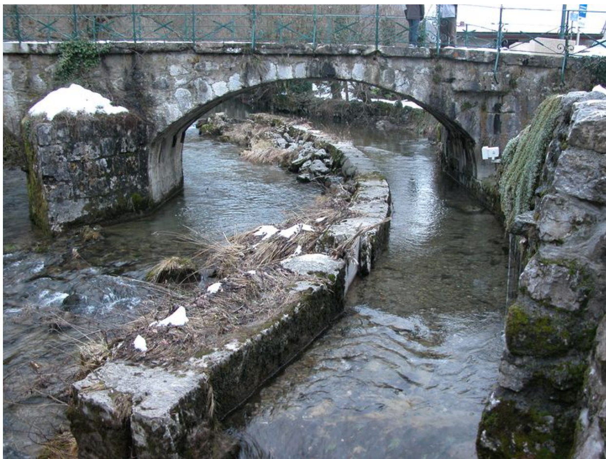
Canal de dérivation sous le pont.
