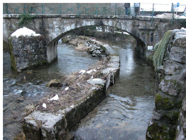
Canal de dérivation sous le pont. Phot. Jérôme Daviet IVR82_20107400819NUCA
