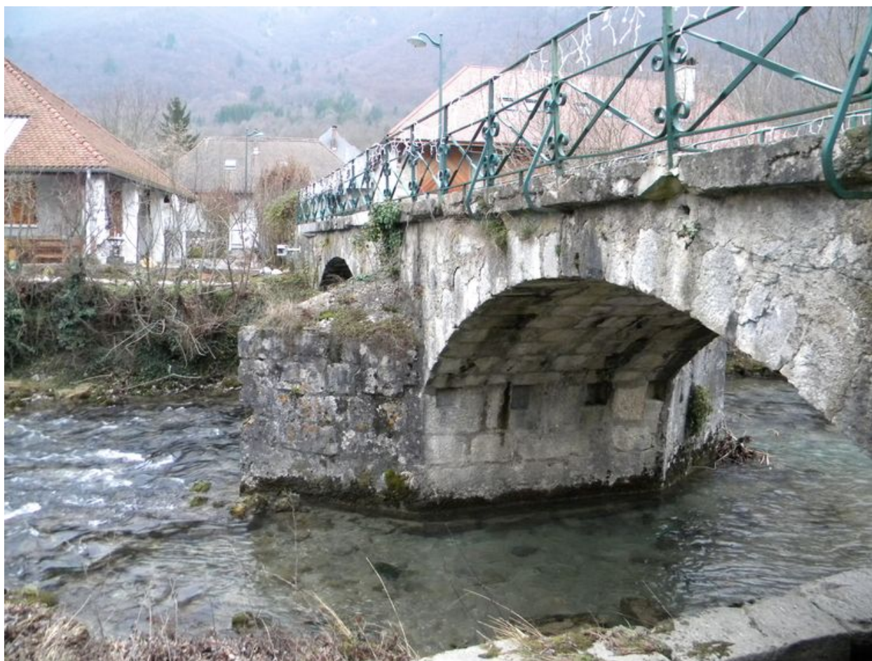
Vue de la pile centrale depuis l'aval.
