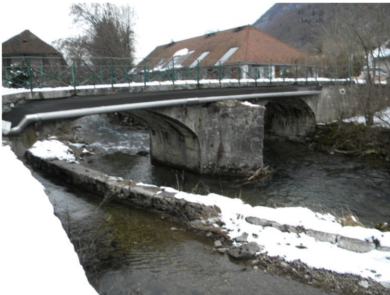
Vue générale depuis l'amont.
