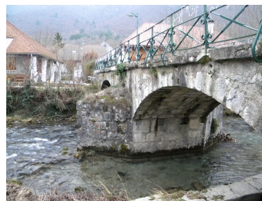
Vue de la pile centrale depuis l'aval. Phot. Jérôme Daviet IVR82_20107400818NUCA
