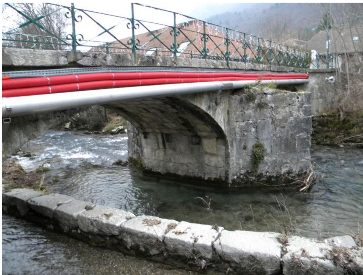
Vue générale depuis l'amont.
