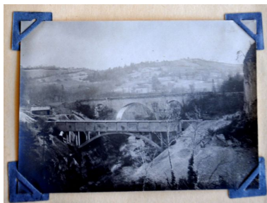
le pont aqueduc sur le Fier terminé. Photo. Archives départementales de la Haute-Savoie © Archives départementales de la Haute-Savoie. 7 S 43 Phot. Samir Mahfoudi, Autr. Société des Forces du Fier IVR82_20107400471NUCA
