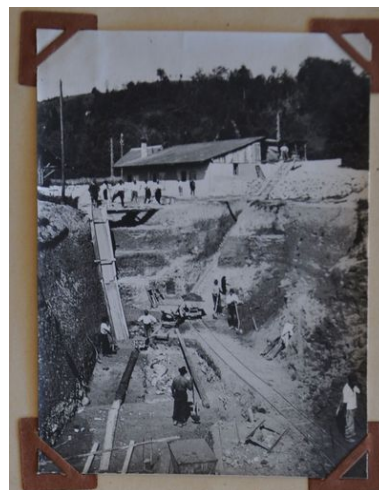
construction du canal d amenée. Photo. Archives départementales de la Haute- Savoie © Archives départementales de la Haute-Savoie. 7 S 43 Phot. Samir Mahfoudi, Autr. Société des Forces du Fier IVR82_20107400463NUCA
