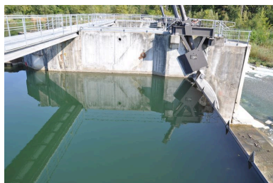
Vue générale du bassin de décantation du barrage Phot. Samir Mahfoudi, Autr. Cécile Dupré IVR82_20107403234NUCA
