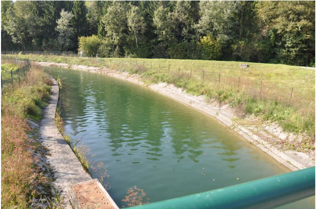
Vue générale de la canal de dérivation
