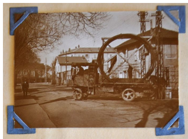
transport de l'armature métallique de la conduite souterraine. Photo. Archives départementales de la Haute-Savoie © Archives départementales de la Haute-Savoie. 7 S 43 Phot. Samir Mahfoudi, Autr. Société des Forces du Fier IVR82_20107400467NUCA
