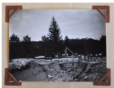
construction du canal d amenée. Photo. Archives départementales de la Haute- Savoie © Archives départementales de la Haute-Savoie. 7 S 43 Phot. Samir Mahfoudi, Autr. Société des Forces du Fier IVR82_20107400464NUCA
