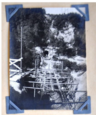
raccordement du pont et du second tunnel. Photo. Archives départementales de la Haute-Savoie © Archives départementales de la Haute-Savoie. 7 S 43 Phot. Samir Mahfoudi, Autr. Société des Forces du Fier IVR82_20107400474NUCA
