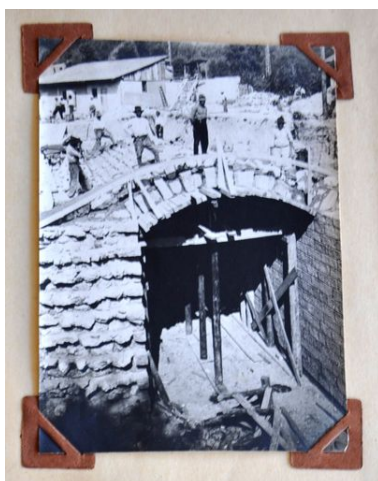
passage souterrain du canal sous la voie ferrée. Photo. Archives départementales de la Haute- Savoie © Archives départementales de la Haute-Savoie. 7 S 43 Phot. Samir Mahfoudi, Autr. Société des Forces du Fier IVR82_20107400465NUCA
