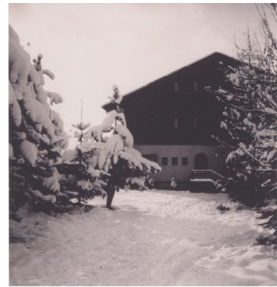
Elévation antérieure. Photogr., vers 1930 Phot. F. Véry IVR82_20127402125NUCAB
