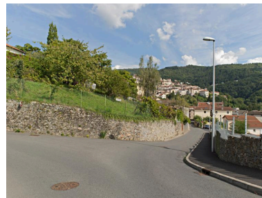
La rue, en direction de la ville, à l'est. Phot. Jean-Michel Périn IVR83_20146300733NUC4A
