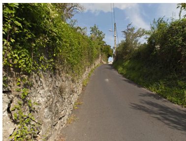
Partie ouest de la rue. Phot. Jean-Michel Périn IVR83_20146300735NUC4A
