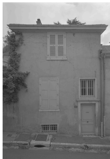
Elévation sur rue : aile droite. Phot. Eric Dessert
