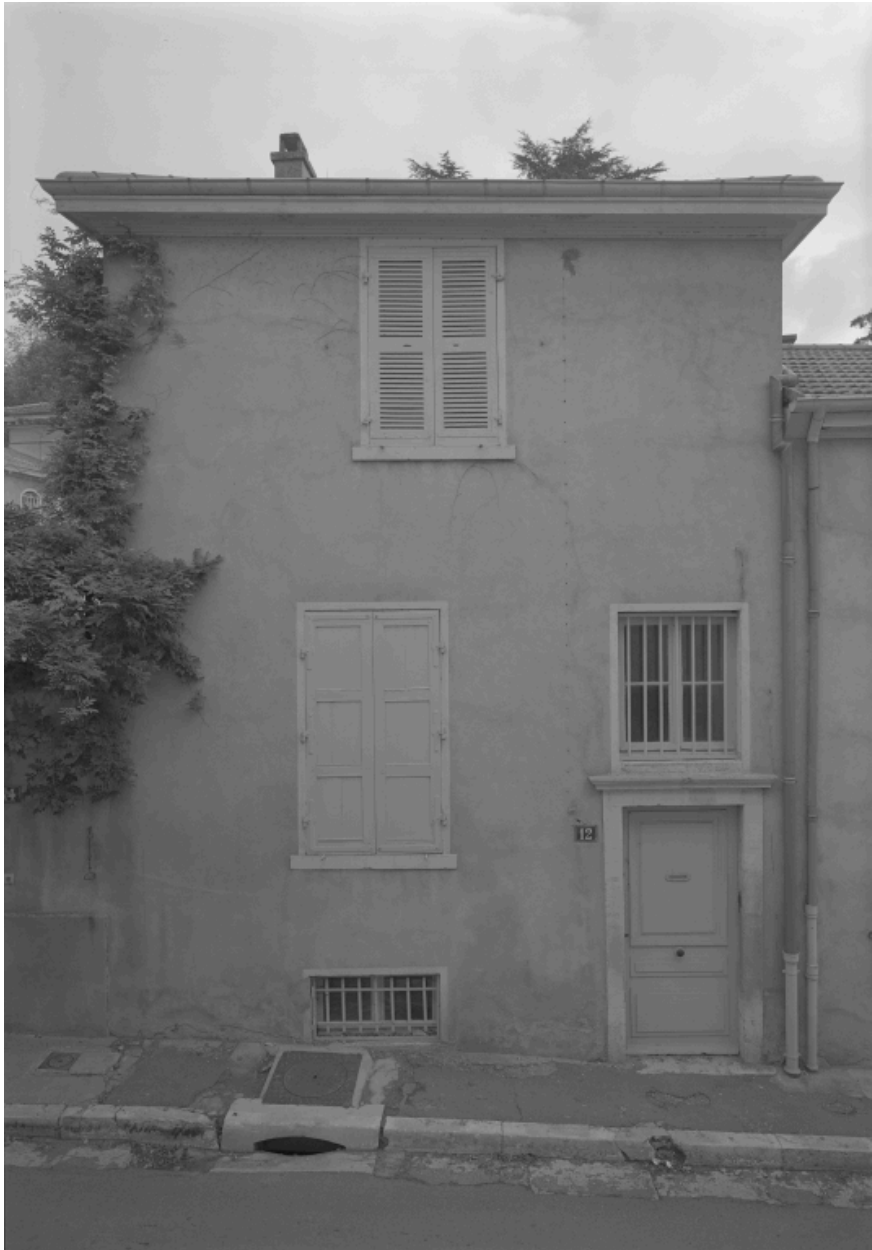
Elévation sur rue : aile droite.
