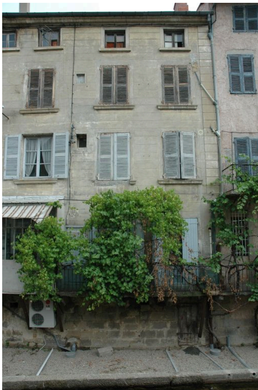
Vue partielle de l'élévation postérieure, travées de droite.
