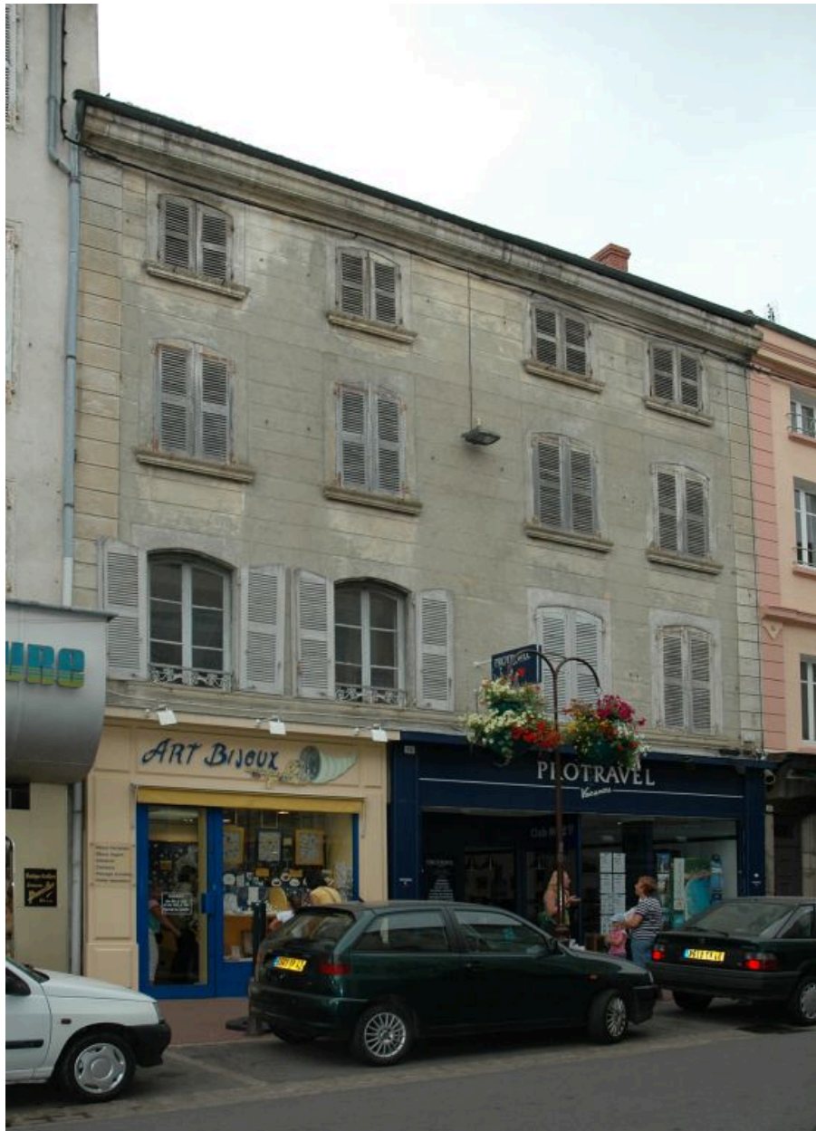
Vue générale, rue Tupinerie
