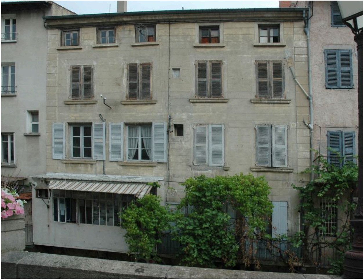
Elévation postérieure, du côté de la rivière.
