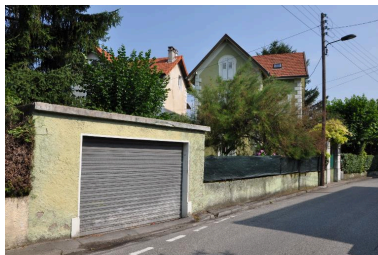
Vue d'ensemble Phot. Denys Harreau IVR82_20137300762NUCA
