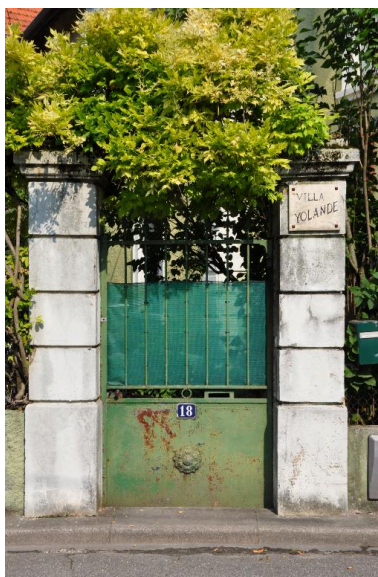
Portail piéton d'entrée Phot. Denys Harreau IVR82_20137300763NUCA
