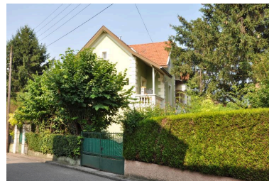
Vue d'ensemble depuis l'arrière Phot. Denys Harreau IVR82_20137300760NUCA
