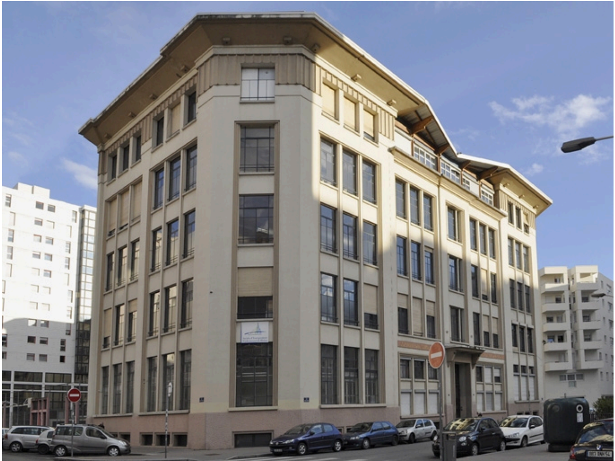
Vue nord-ouest façade principale
