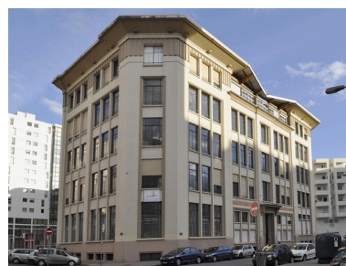
Vue nord-ouest façade principale Phot. Nadine Halitim-Dubois IVR82_20106900642NUCA
