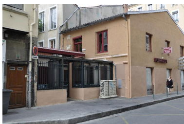
Vue d'ensemble nord est depuis la rue Pailleron Phot. Nadine Halitim-Dubois IVR82_20146900553NUCA
