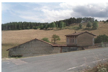
Aux Genettes, vue d'ensemble d'une ferme (1986 A 235). Phot. Thierry Monnet IVR82_20034200896ZE
