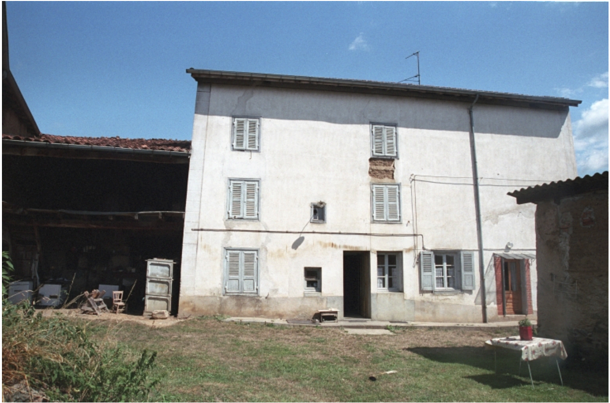
Culvé, ferme, vue d'ensemble du logis (1986 A 464).
