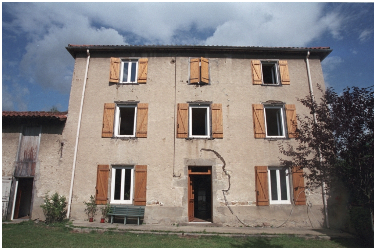
Aux Places, ferme (1986 A1 312, 856), vue d'ensemble de la façade avant du logis de la ferme donnant sur la cour.
