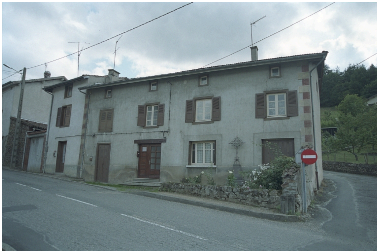
Au Trève, ferme (1986 C2 809, 810). Bâtiment en pisé à encadrements en bois ; ferme existante en 1835, remaniements de baies en façade, décor de faux chaînage d'angle en brique et pierre. Vue d'ensemble du logis sur rue.
