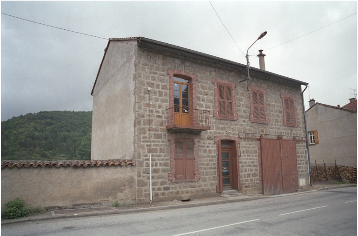
Croix Besson, ferme (1986 B3 1017), vue d'ensemble de la façade principale depuis la route.
