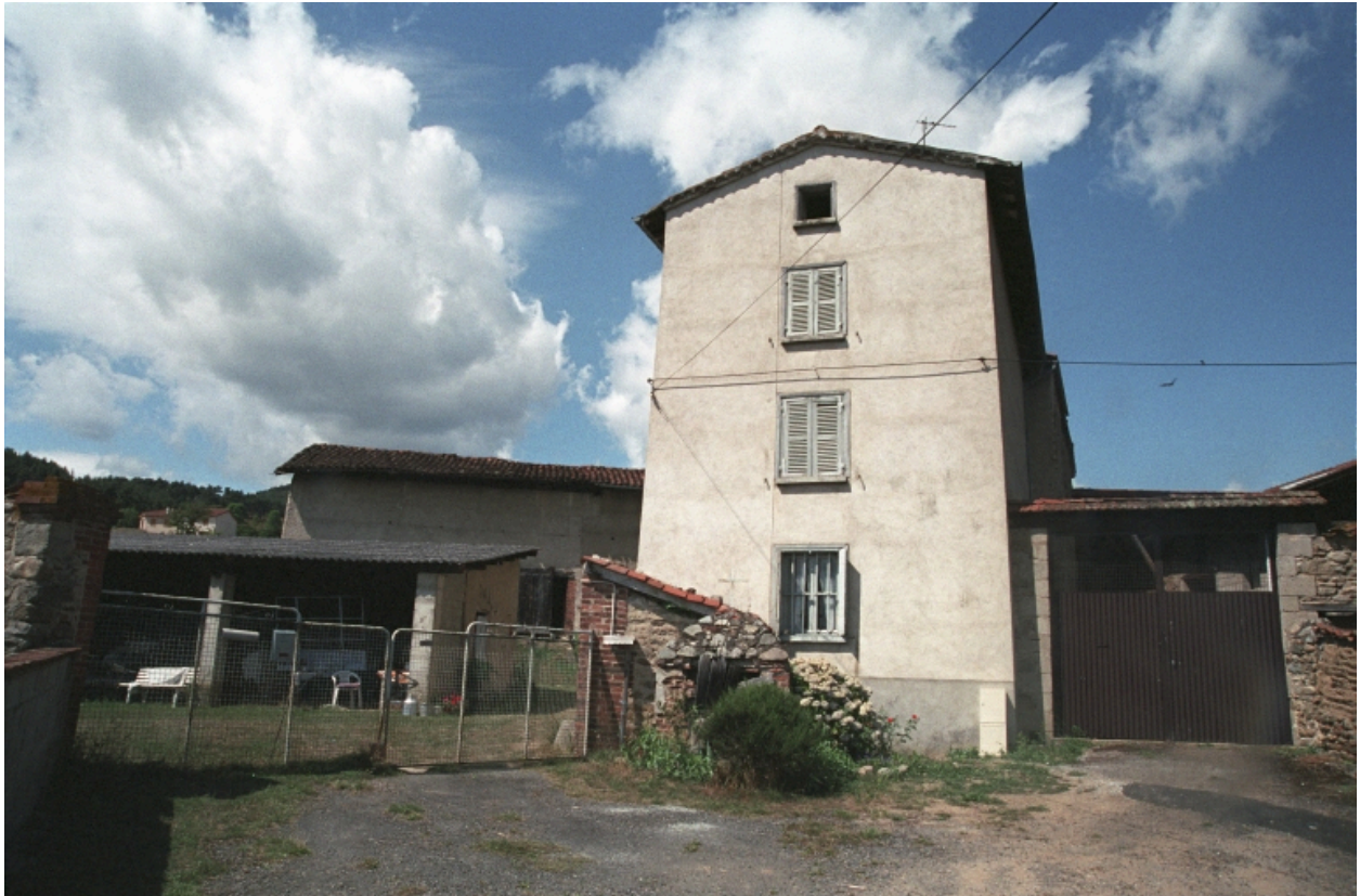
Culvé, ferme, vue d'ensemble (1986 A 464).
