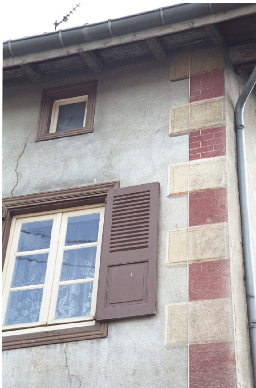
Au Trève, ferme (1986 C2 809, 810). Bâtiment en pisé à encadrements en bois ; ferme existante en 1835, remaniements de baies en façade, décor de faux chaînage d'angle en brique et pierre. Détail du faux chaînage d'angle peint.
