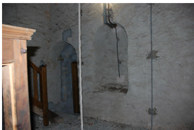
Vue intérieure : ouvertures dans la salle haute du clocher. Phot. Thierry Monnet IVR84_20207402815NUCA
