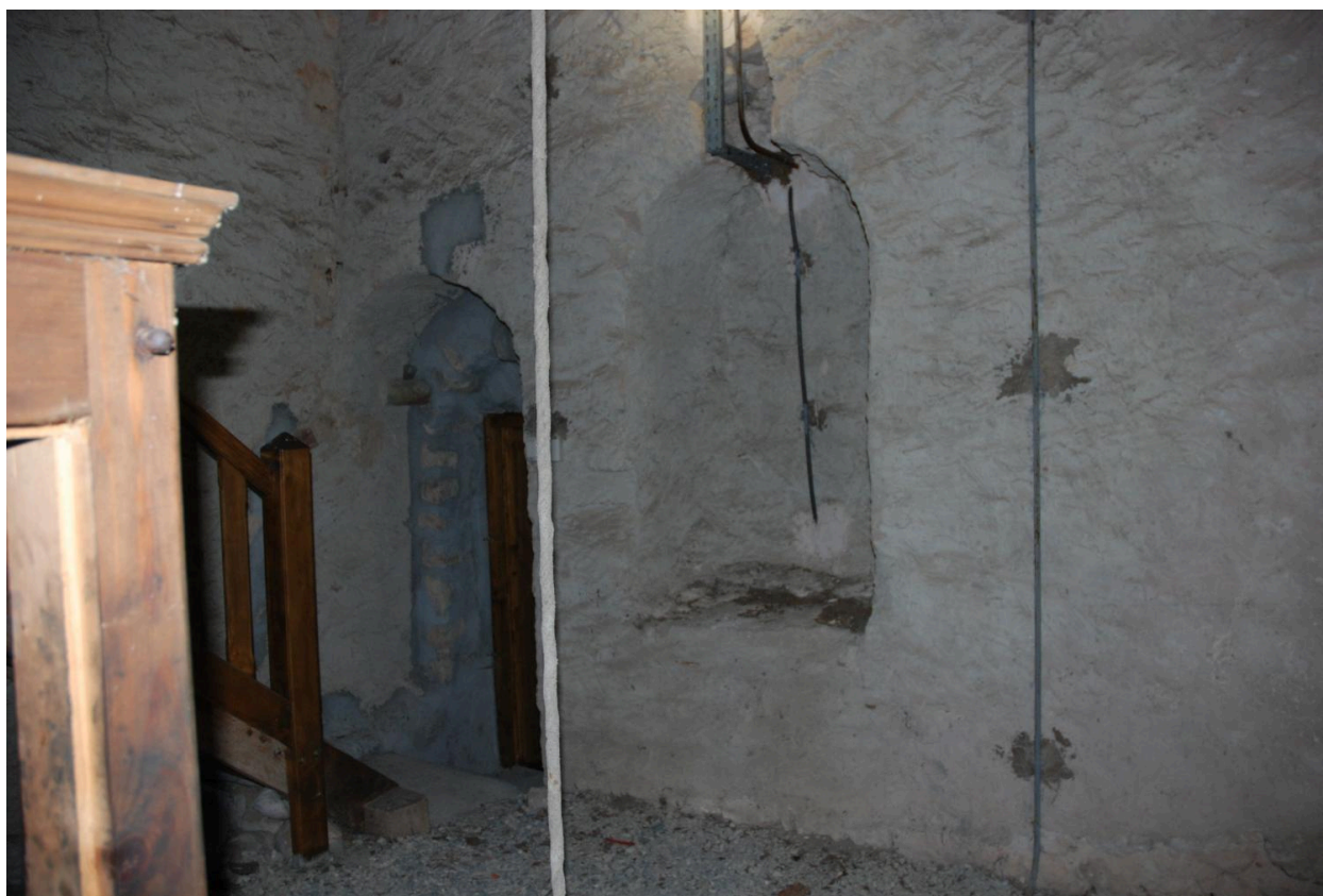
Vue intérieure : ouvertures dans la salle haute du clocher.
