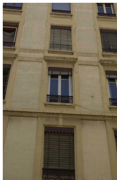
Détail des fenêtres Phot. Coralie Belleville IVR82_20026902955NUCA
