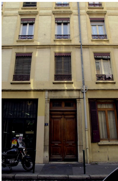
Vue d'ensemble de la travée centrale Phot. Maryannick Chalabi IVR82_20036900538NUCA
