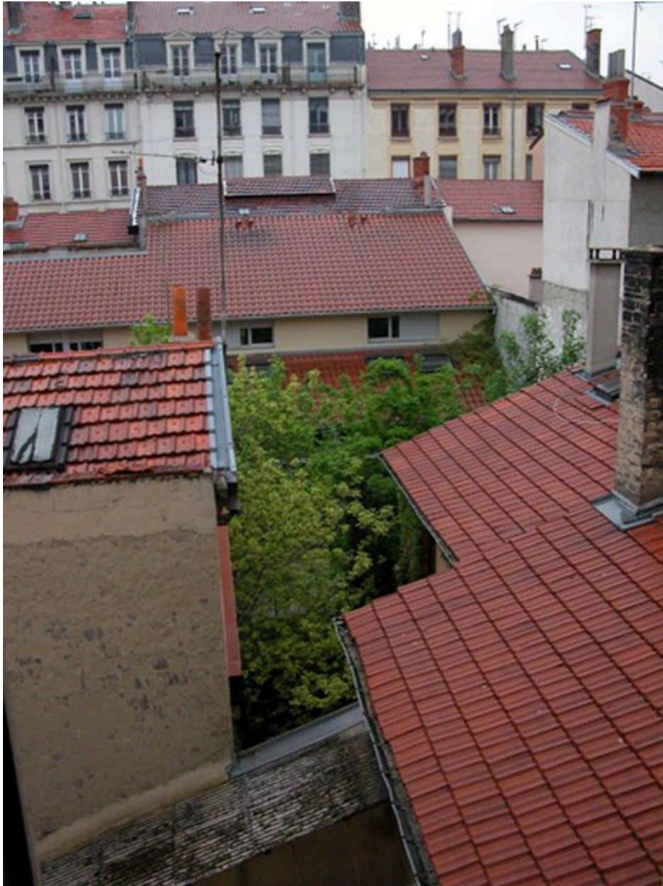
Détail des derniers niveaux depuis le 17 rue Sébastien-Gryphe
