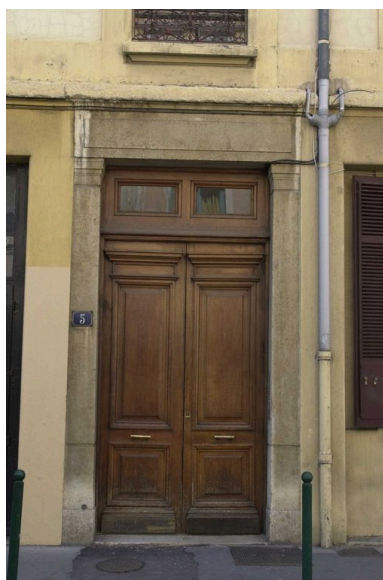
Porte d'entrée Phot. Coralie Belleville IVR82_20026902953NUCA
