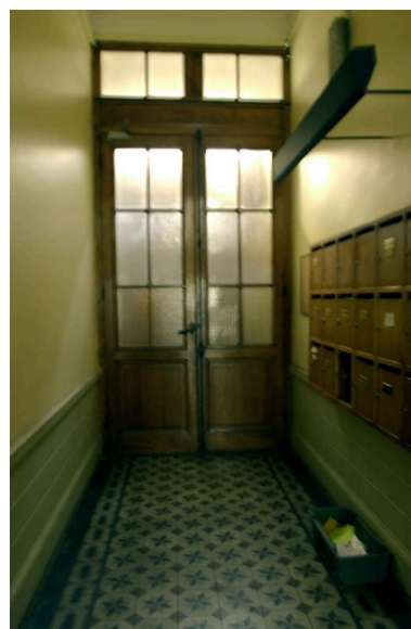
Vue du vestibule vers l'entrée Phot. Maryannick Chalabi IVR82_20036900540NUCA
